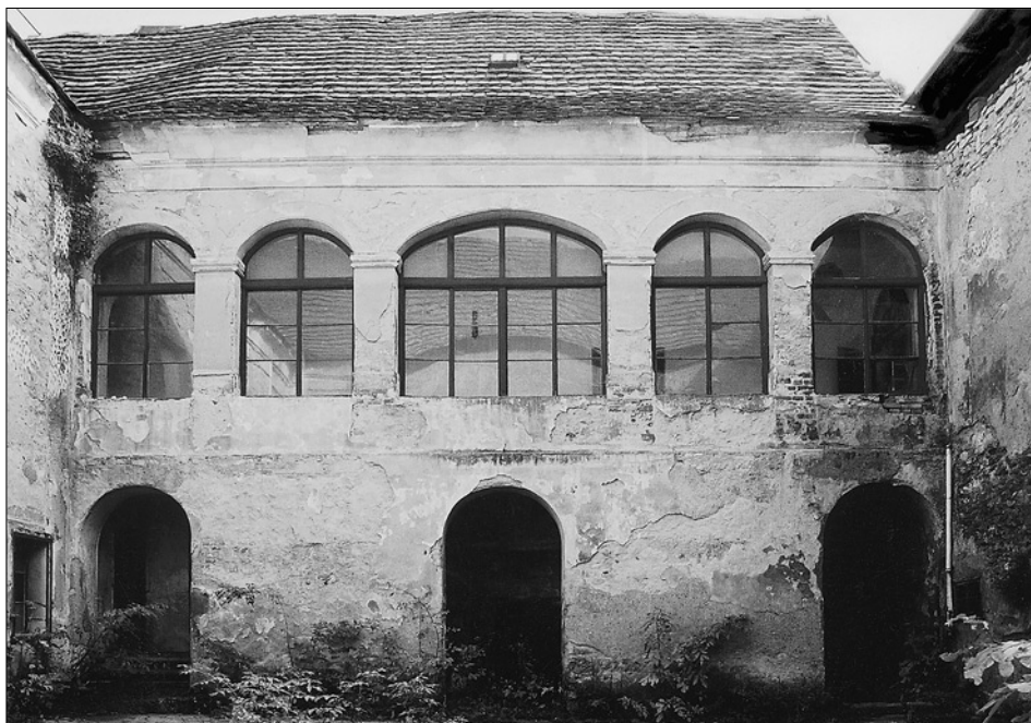
Obr. 11: Třebotov, fara čp. 1 – bývalá tvrz. Celkový pohled na dvorní průčelí jihovýchodního křídla s představeným barokním arkádovým traktem.
