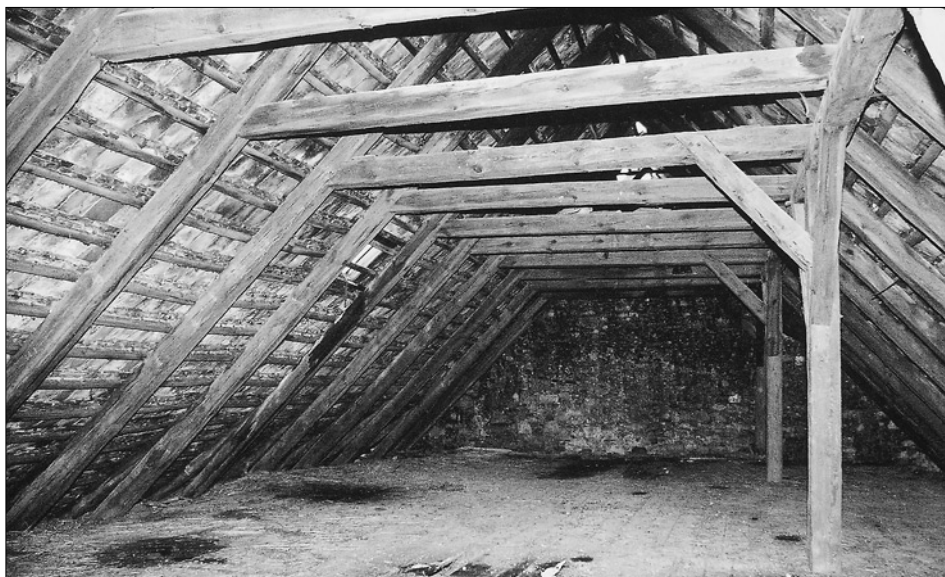
Obr. 19: Třebotov, fara čp. 1 – bývalá tvrz. Krov nad středním sýpkovým dílem jihovýchodního křídla. Jednoduchá soustava krovu, tvořená jen pevnými trojúhelníky krokvi a hambálky, je na dvorní straně jednostranně zesílena stolicí.
