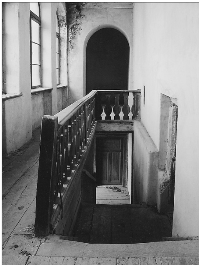
Obr. 15: Třebotov, fara čp. 1 – bývalá tvrz. Barokní nástupní schodiště do patra s proezávaným dřevěným zábradlím. Vpravo torzo gotického portálu do místnosti ve středním dílu patra jihovýchodního křídla (bývalého paláce).
