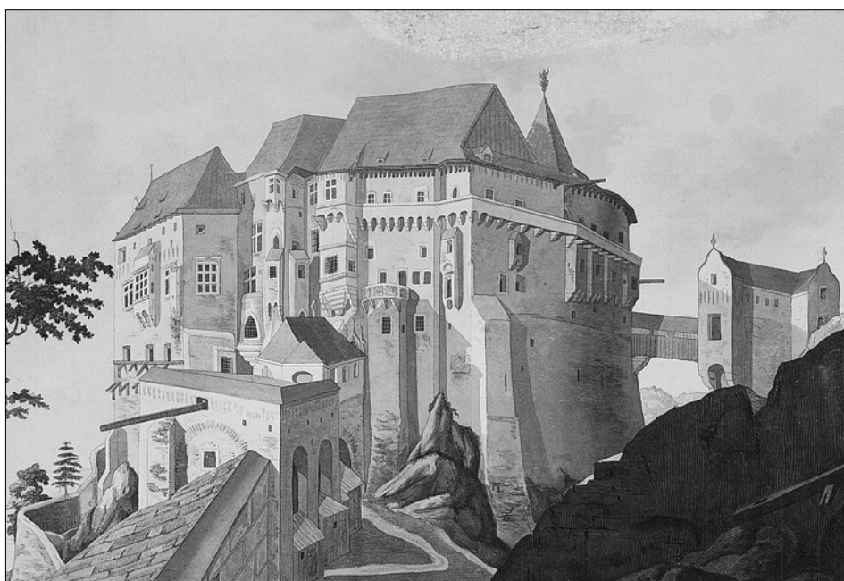
Obr. 1: Hrad Pernštejn, pohled na palác od severovýchodu (Franz Strüff, 1806).
