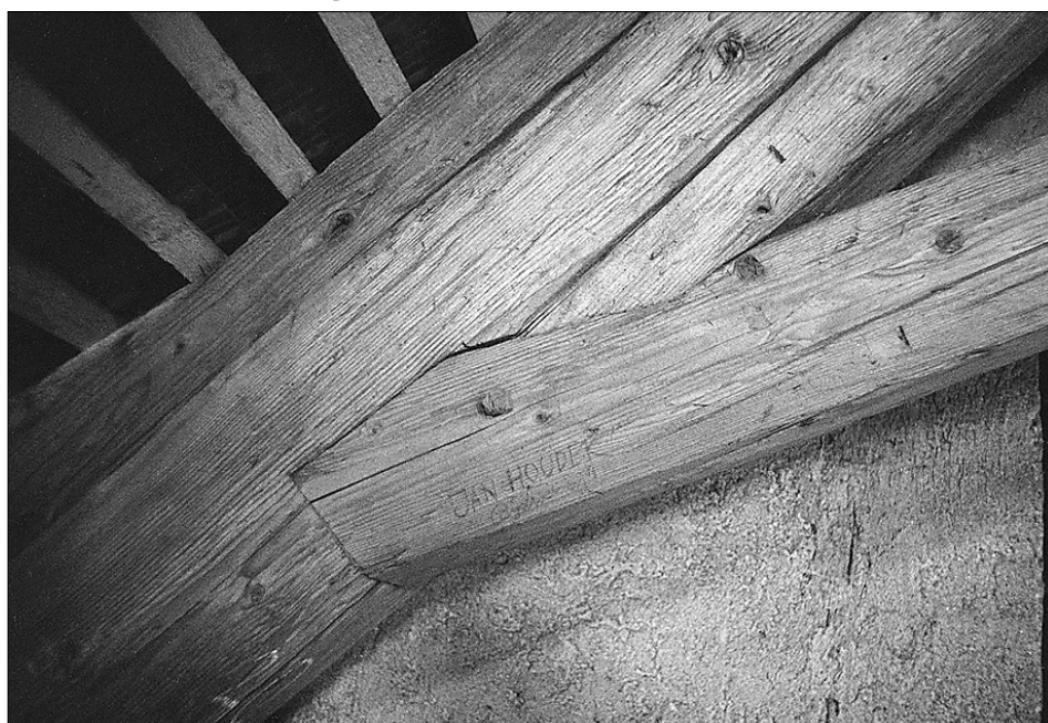
Obr. 13: Hrad Pernštejn, detail spoje na pásku ležaté stoličky v krovu nad obytnou věží (foto J. Bláha, 2001).
