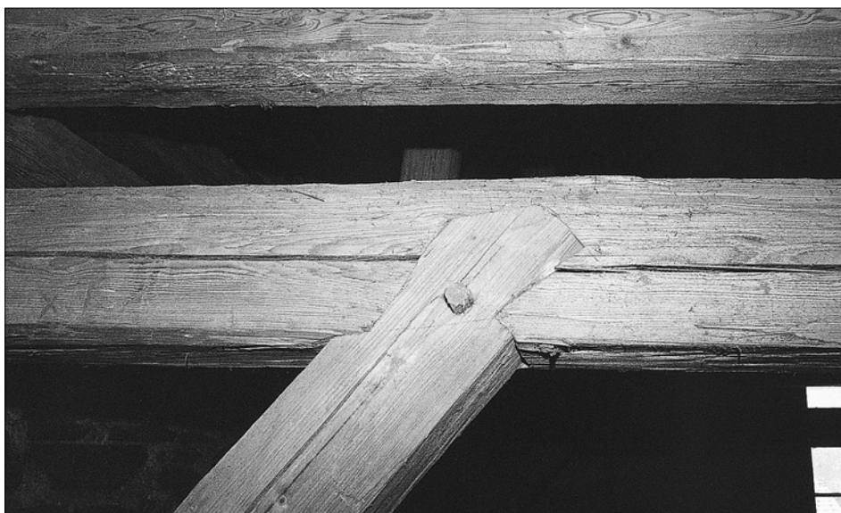
Obr. 11: Hrad Pernštejn, detail spoje na pásku stojaté stolice v krovu nad Schröfflovými pokoji (foto J. Bláha, 2001).
