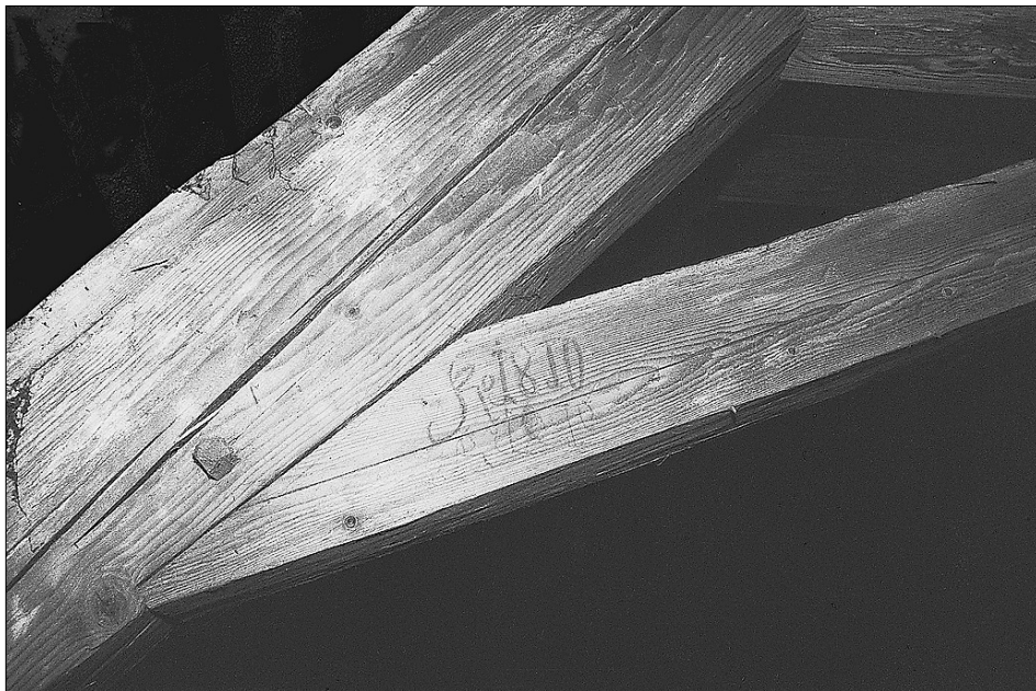
Obr. 16: Hrad Pernštejn, stavební datování v krovu nad přijímacím sálem (foto J. Bláha, 2001).
