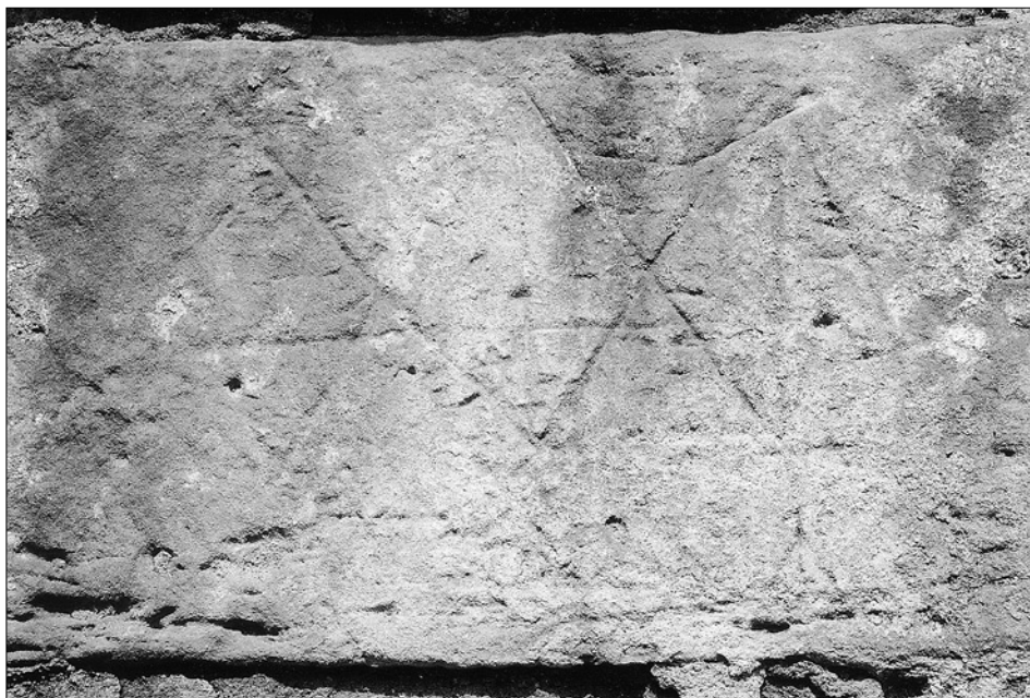
Obr. 2: Lounky, kostel sv. Mikuláše. Jižní opěrný pilíř presbytáře, detail rytiny podélné vazby pozdně středověkého typu krovu. Pohled od jihu (foto autor, 2002).
