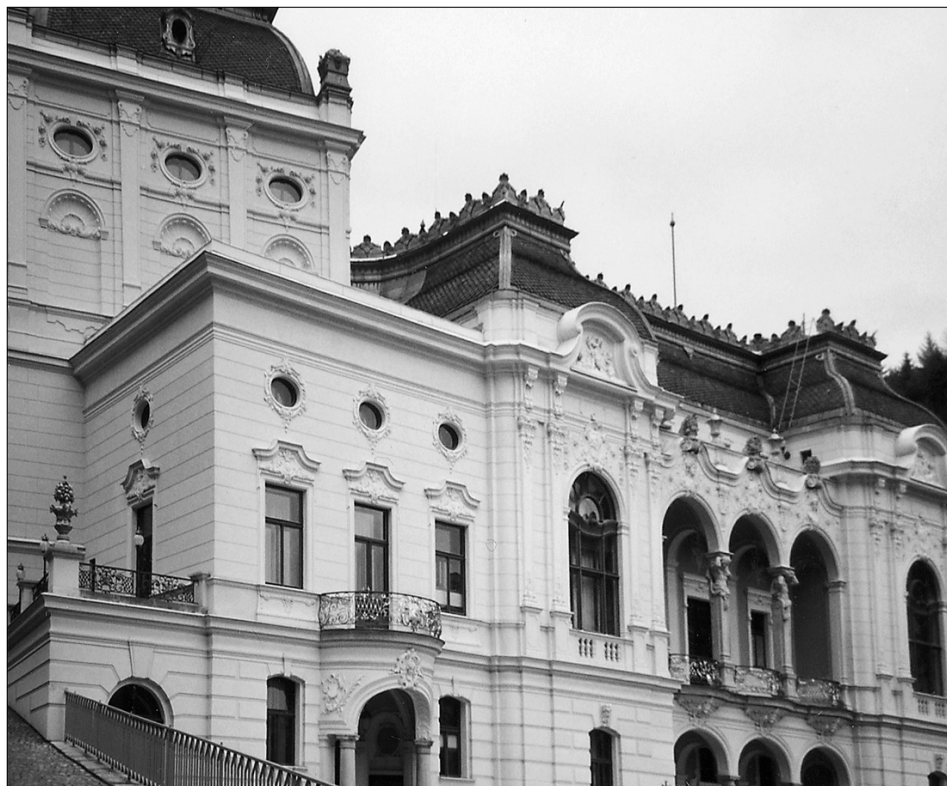
Obr. 5: Karlovy Vary, divadlo V. Nezvala, pohled na boční průčelí od jevištní části (foto D. Hladíková, 2000).
