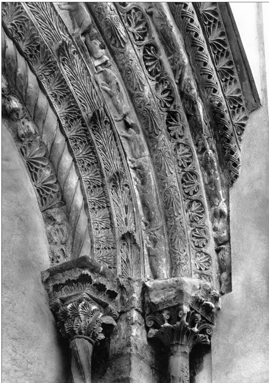
Obr. 9: Pravé ostění portálu kostela sv. Prokopa v Zábři (viz obr. 8).
