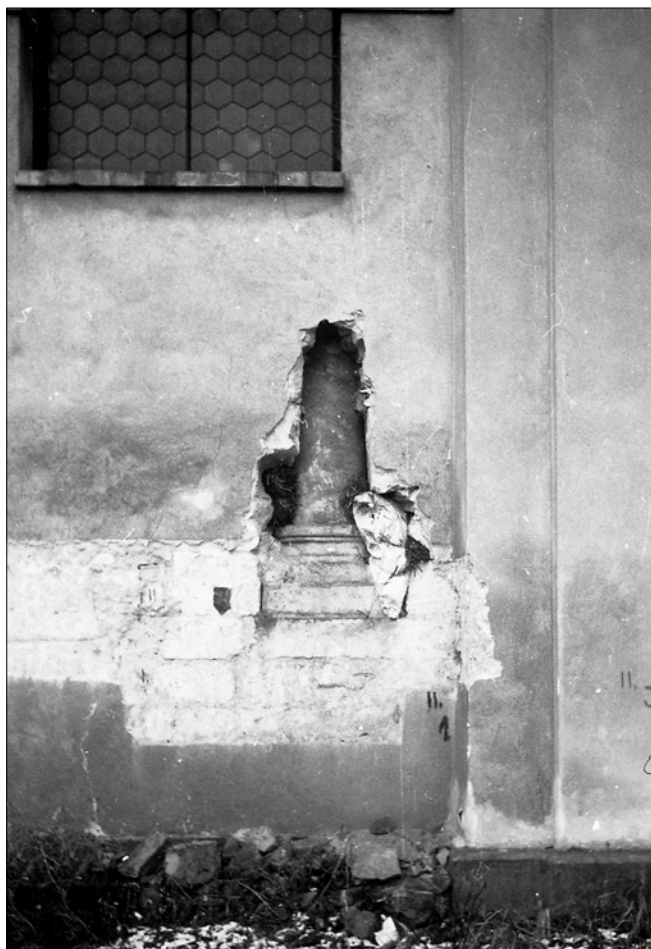
Obr. 2: Zábore nad Labem, jižní stěna předsíně kostela s odhaleným sloupkem arkády v roce 1971.
