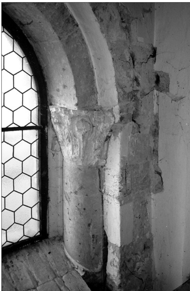
Obr. 4: Záboří nad Labem, barokní úprava arkády na okno.
