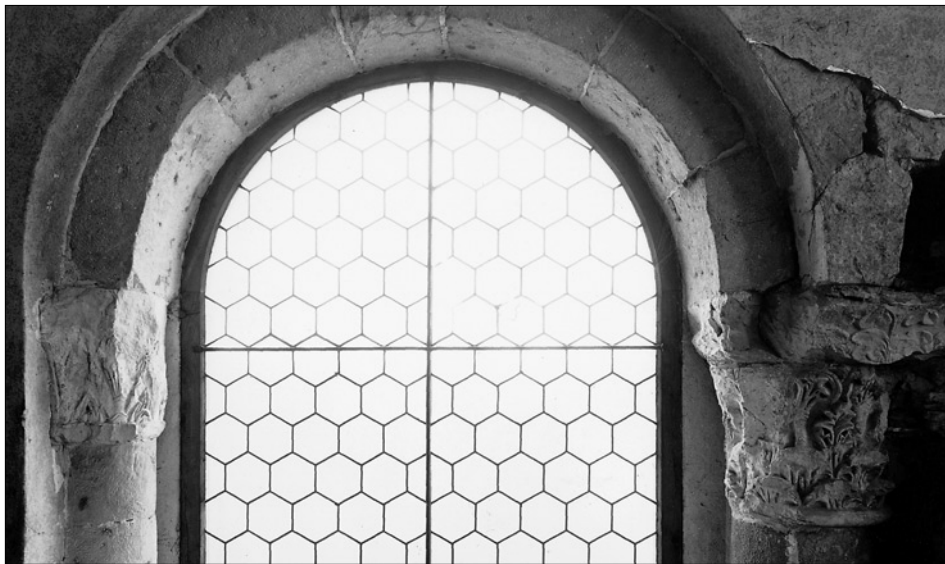
Obr. 3: Záboří nad Labem, arkáda předsíně v interiéru.
