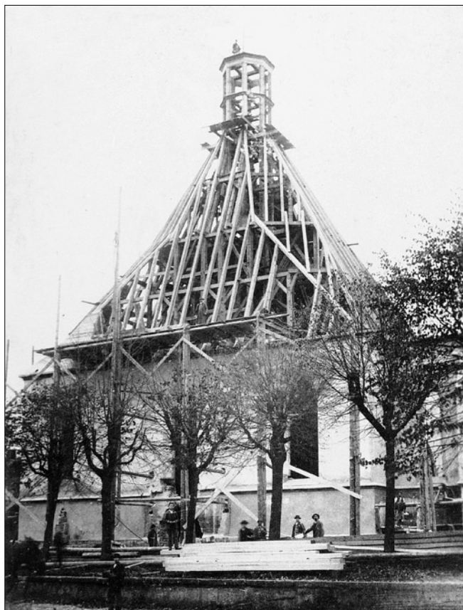
Obr. 9: Česká Lípa, kostel sv. Kříže. Celkový pohled od jihu v průběhu stavby nového krovu, H. Pelikan, 27. října 1896 (OVM Č. Lípa, Sbirka starých fotografií).
