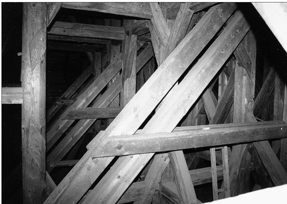
Obr. 16: Česká Lípa, kostel sv. Kříže, krov lodi, spodní část. Severní strana, druhá úroveň, systém zdvojených vzpěr mohutných věšadel, prostupujících centrální rámovou konstrukcí. Vlevo sloup č. 2 rámu č. 5, dobře je vidět odříznuté jednostranně rybinovité pláty původních ondřejských křížů, pohled od západu.
