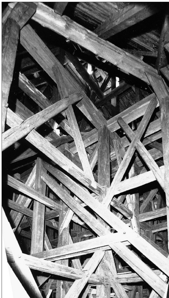
Obr. 15: Česká Lípa, kostel sv. Kříže, krov lodi, spodní část. Centrální prostorová rámová konstrukce, pohled od severovýchodu (všechny následující snímky M. Panáček, 2002).
