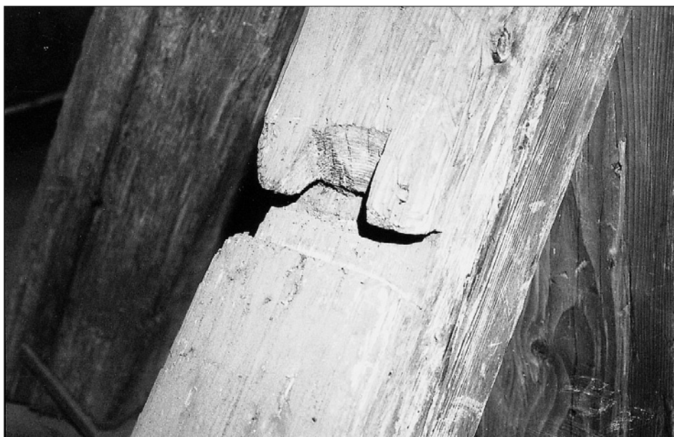
Obr. 33: Česká Lípa, kostel sv. Kříže, krov lodi. Centrální prostorová konstrukce, rám č. 12, západní zápora, detail zařízení pro uchycení opracovávaného dřeva (latě, šindele), pohled od jihozápadu.
