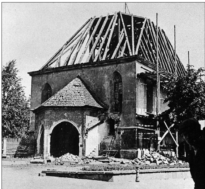
Obr. 8: Česká Lípa, kostel sv. Kříže. Celkový pohled od jihozápadu v průběhu rozebírání původního krovu, přelom června a července 1896 (OVM Č. Lípa, Sbirka starých fotografií).
