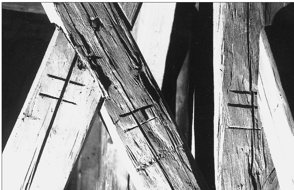
Obr. 32: Česká Lípa, kostel sv. Kříže, krov lodi. Centrální prostorová konstrukce, rám č. 5, sloup č. 12 a vedlejší jižní ondřejský kříž v první úrovni, detail tesařského značení částečně překrytého šikmým prvkem rámu č. 3, všechny značky jsou porušeny trhlinou vzniklou při vysychání dřeva, pohled od východu.
