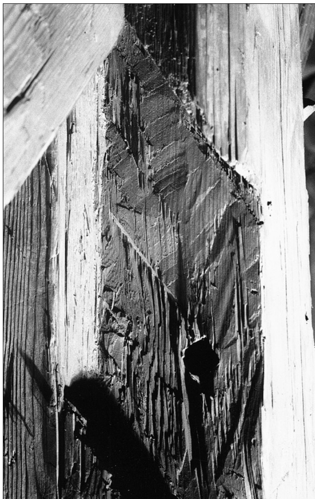
Obr. 29: Česká Lípa, kostel sv. Kříže, krov lodi. Centrální prostorová konstrukce, rám č. 2, sloup č. 14, detail prázdného dlabu v první úrovni s dobře patrnými stopami vytváření velkou sekerou (šikmé hrany uprostřed plochy dlabu), po níž byl povrch částečně srovnán menší hlavičkou, pohled od severovýchodu.
