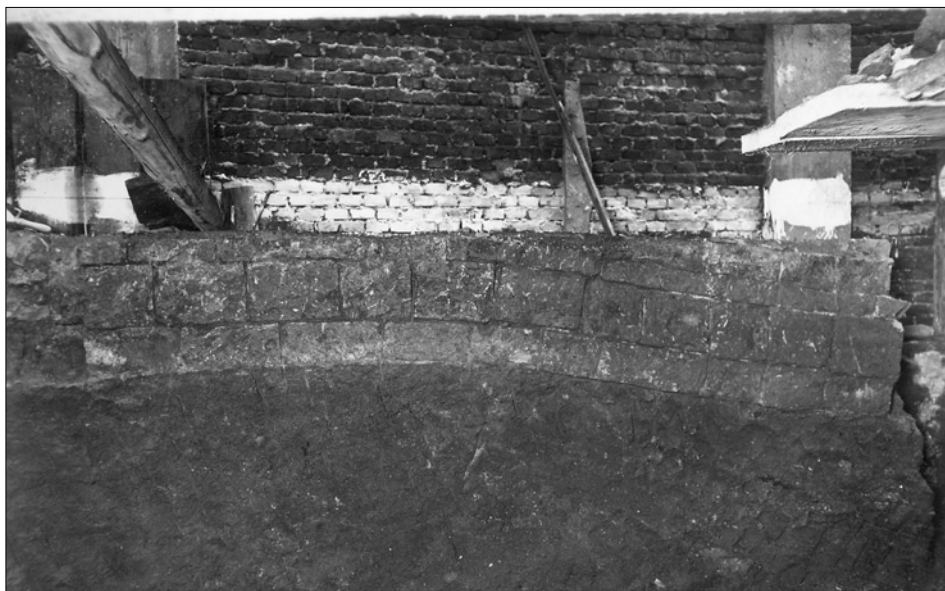
Obr. 5: Praha 1 – Malá Strana, čp. 386/III. Pohled na větší úsek kvádříkového zdiva a strukturu jeho jádra (foto Archiv náleзовých zpráv Archeologického ústavu AV ČR, 1932).
