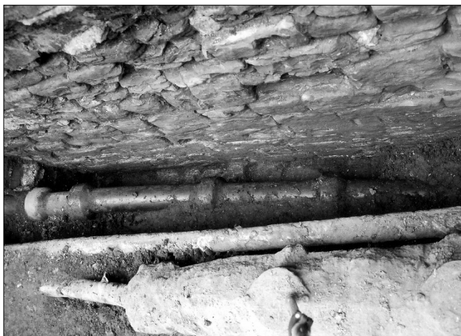
Obr. 7: Praha 1 – Malá Strana, čp. 382/III. Vnější líc kvádrkové zdi, dole pod okapovým svodem opukové kameny dlažby (foto M. Tryml, 2002).
