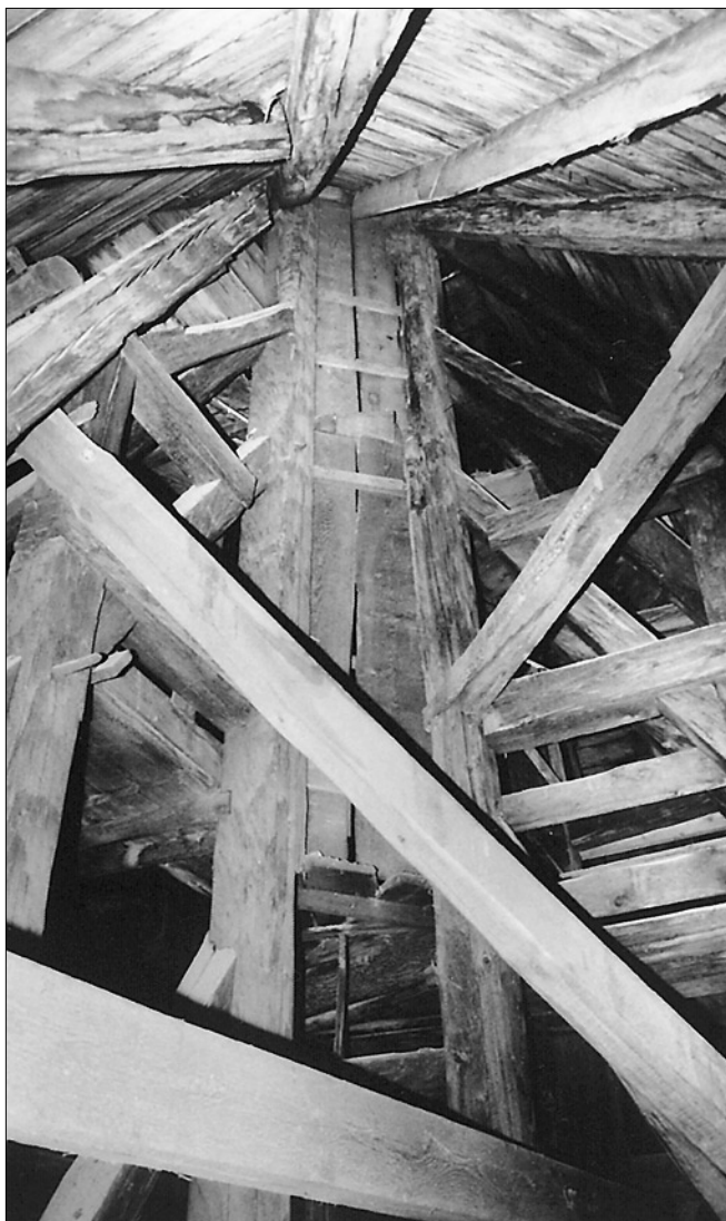
Obr. 6: Litoměřice, dům čp. 15 Kalich. Krov stanové střechy, polygonální stolice věže fixovaná bočními podestovými konstrukcemi, pohled od jihozápadu (foto M. Panáček, 2002).
