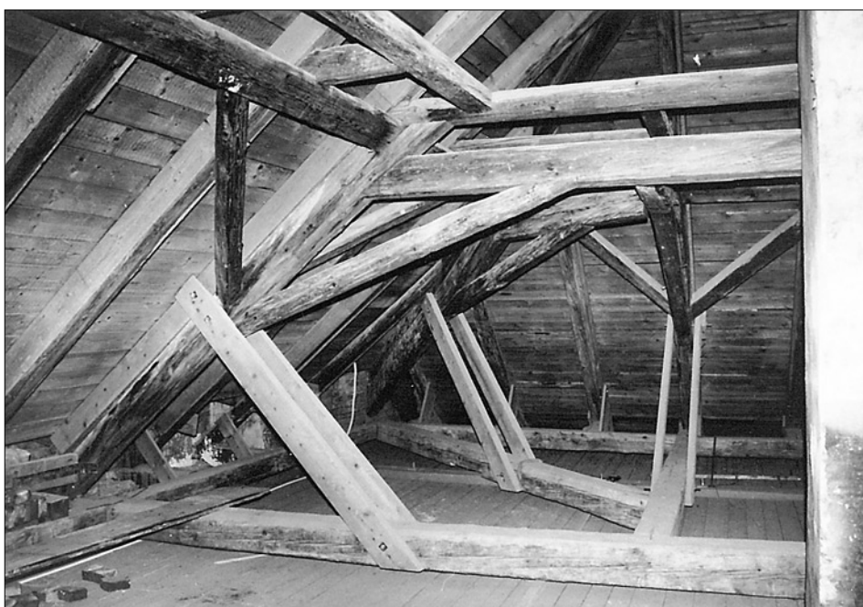
Obr. 11: Litoměřice, dům čp. 15 Kalich. Krov sedlové střechy, východní část šesté plné příčné vazby, pohled od severu (foto M. Panáček, 2002).
