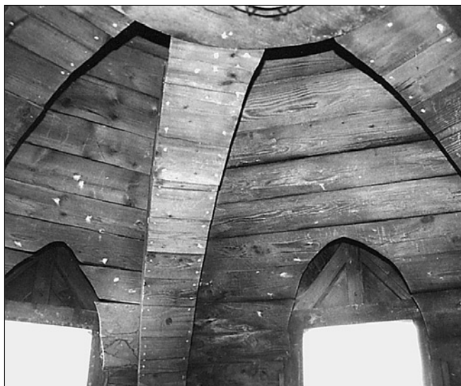
Obr. 12: Litoměřice, dům čp. 15 Kalich. Skružová konstrukce vyhlídkové bány připomínající žebrovou klášterní klenbu s kruhovým svorníkem, pohled od severu (foto M. Panáček, 2001).
