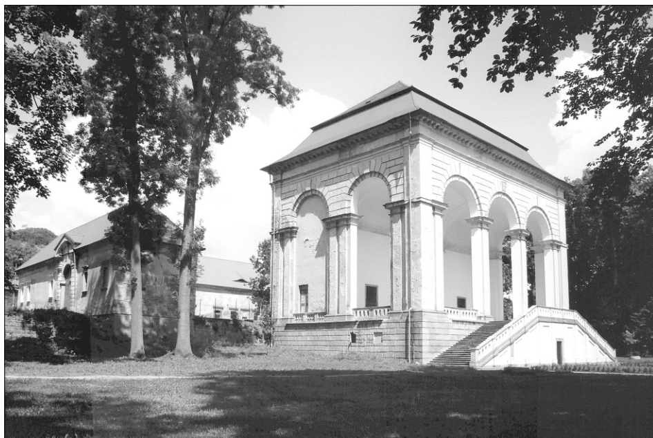
Obr. 1: Celkový pohled na casino a dvůr od jihu (foto P. Uličný, 2002).
