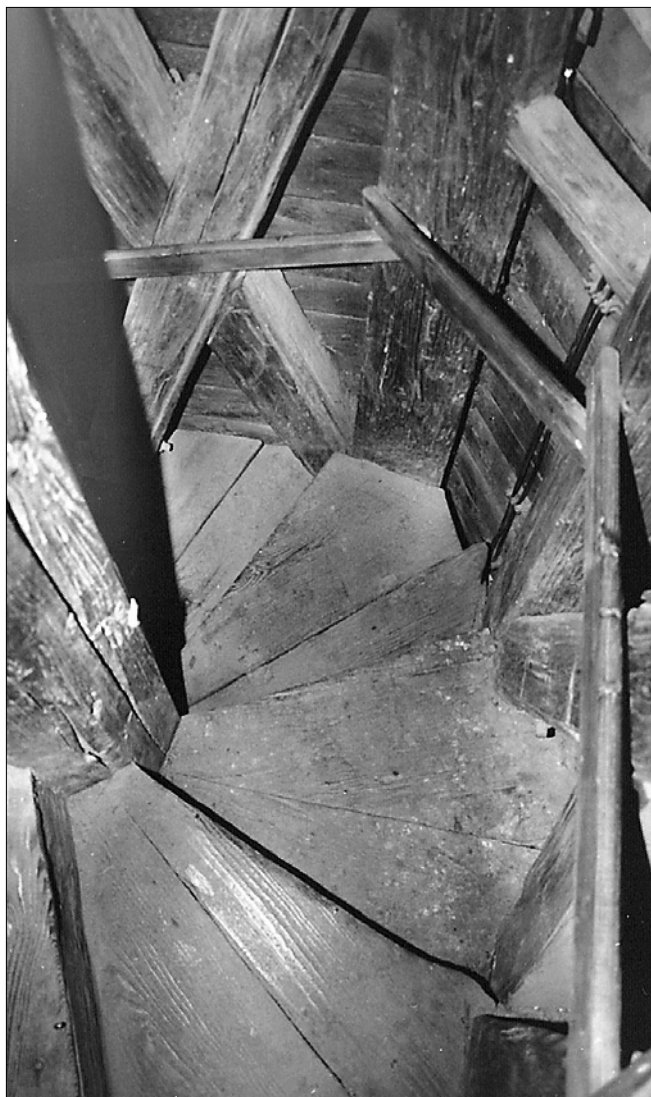
Obr. 7: Litoměřice, dům čp. 15 Kalich. Krov stanové střechy, točité schodiště uvnitř polygonální stolice věže, pohled od jihu (foto M. Panáček, 2001).
