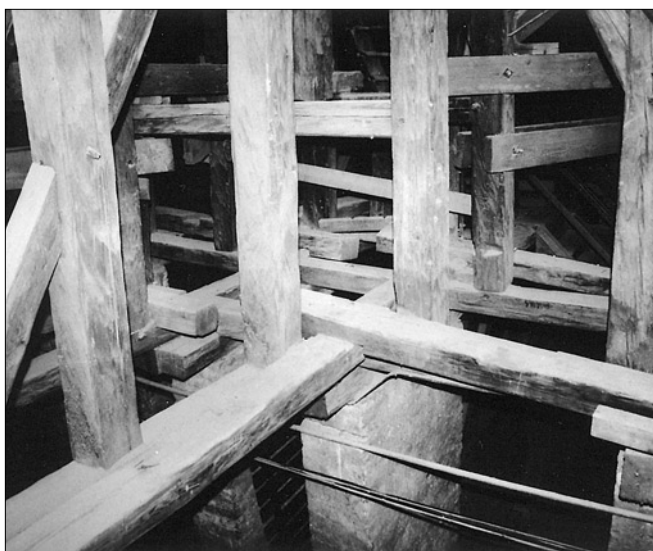
Obr. 3: Litoměřice, dům čp. 15 Kalich. Krov stanové střechy, založení polygonální stolice věže na prahovém roštu, pohled od jihozápadu (foto M. Panáček, 2002).
