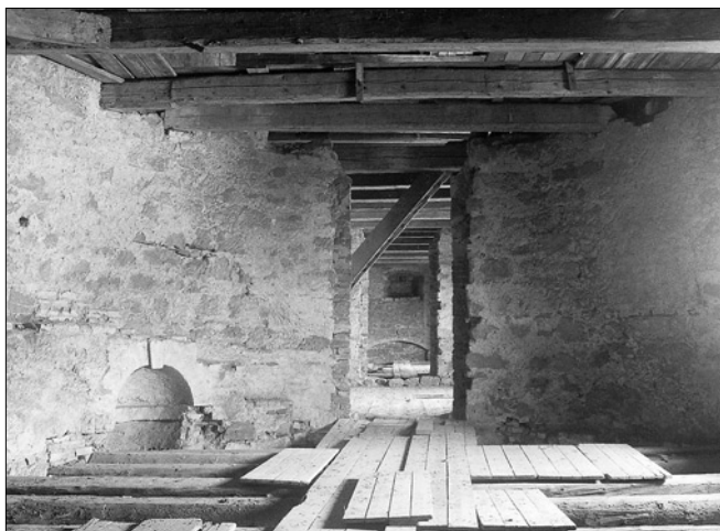
Obr. 26: Průhled z oválu do střední místnosti a polygonu v úrovni 1. patra. Vlevo patrná nika a ústupky pro neprovedené schodiště (foto P. Uličný, 2001).
