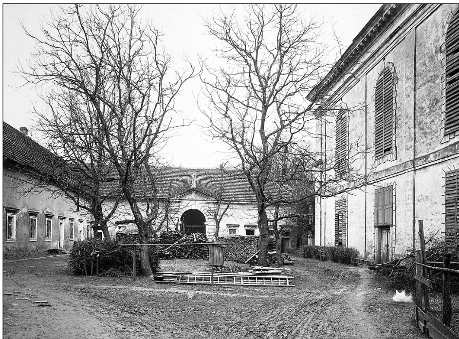
Obr. 10: Celkový pohled na dvorní fasádu casina. (foto J. Štenc, 1934). ÚDU AV ČR, DSF, W-A-230/5, repro Z. Matyáško.
