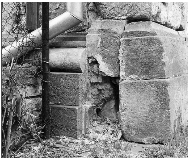
Obr. 22: Detail styku patky nárožního pilíře dvorního křídla a patky pilastru východní boční fasády se stopou po parapetu terasy dvora (foto P. Uličný, 2001).
