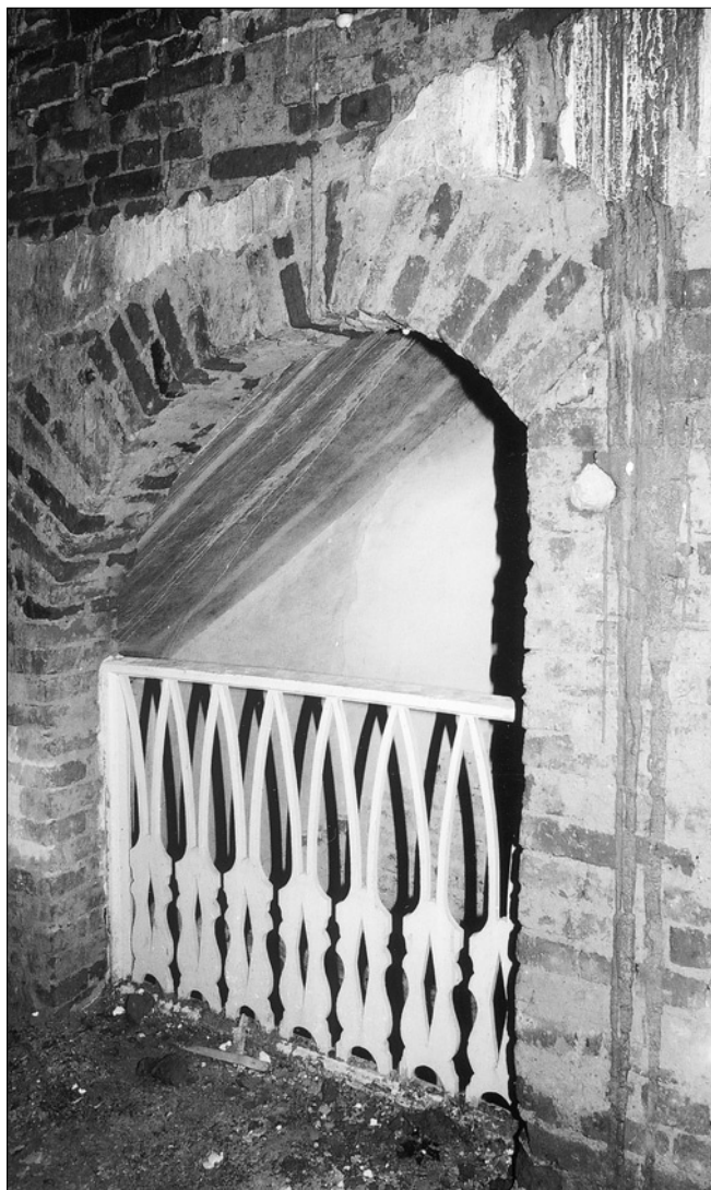
Obr. 10: Oblouk na schodiště do patra s dochovaným empírovým dřevěným zábradlím (všechny snímky autor, není-li uvedeno jinak).
