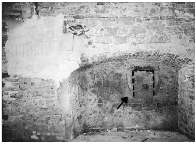
Obr. 8: Topenišťová nika s kamenným příkládacím portálkem v západní stěně chodby č. 103.
