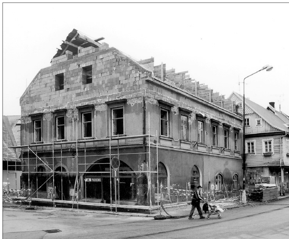
Obr. 6: Celkový pohled na dům od severovýchodu, dnešní stav. Dům má oproti starší fotografii z roku 1895 tradičionalistické průčelí z roku 1925. Štít a veškeré partie stavby nad římsou jsou novodobé, z doby po požáru.
