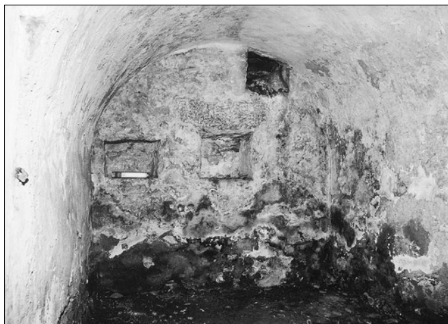
Obr. 9: Sklípek (č. 03) pod někdejší světnicí, se zaslepeným větracím otvorem ústícím do prostoru podloubí.
