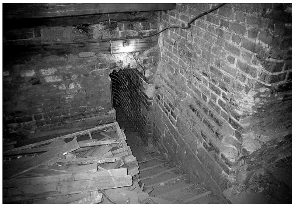
Obr. 34: Hlubčice, městský kostel Panny Marie. Vyústění vřetenového schodiště do podkroví jižní lodi, stav v roce 2003. Vpravo východní zeď jižní věže s dobře patrným střídáním zdiva z cihel a z pískovcových kvádrů.
