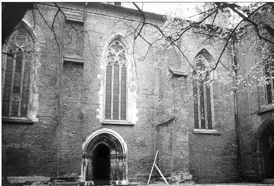
Obr. 4: Hlubčice, městský kostel Panny Marie. Jižní strana trojlodí. Ve středním poli je dobře patrné posunutí portálu z osy k západu, na bočních zdech opěráků pozůstatky středověké předsíně, zbořené počátkem 20. století. Západní a střední pole síně s opěráky je vyzděno na pískovcovém soklu, který ve východním poli chybí. V pseudogotickém jižním rameni transeptu integrován vyspravený raně gotický opěrák bez ústupku, odlišný od zbývajících viditelných opěráků. Jeho kamenný sokl je novogotickým doplňkem. Východní okno má cihlovou špaletu, okna středního a západního pole naopak pískovcová ostění. Kružby středního a západního okna jsou novogotickými doplňky z let 1903–1906.
