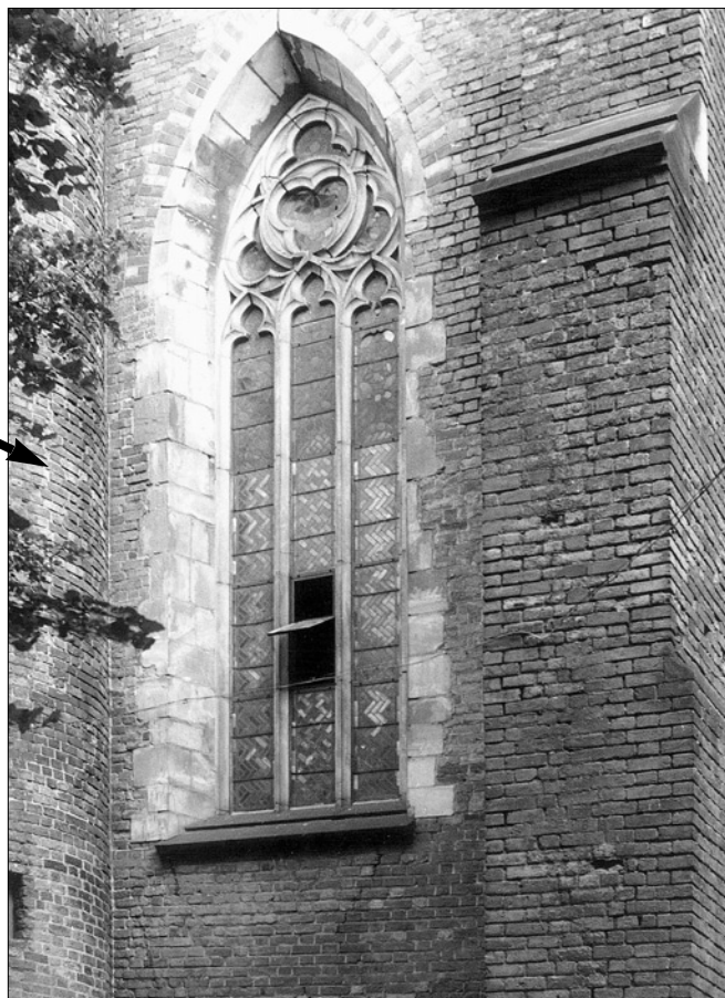
Obr. 12: Hlubčice, městský kostel Panny Marie. Okno v západním poli jižní lodi, stav v roce 1991. Kružba je novotvarem Maxe Hasaka z let 1903 až 1906. Schodišťová věžička je částečně patrná vlevo, včetně původního okénka a v úrovni okna včetně zazdívků výstupu neznámé funkce (viz šipka). Na pravé straně operáku patrný odstupnění po odbourané jižní předsiní.
