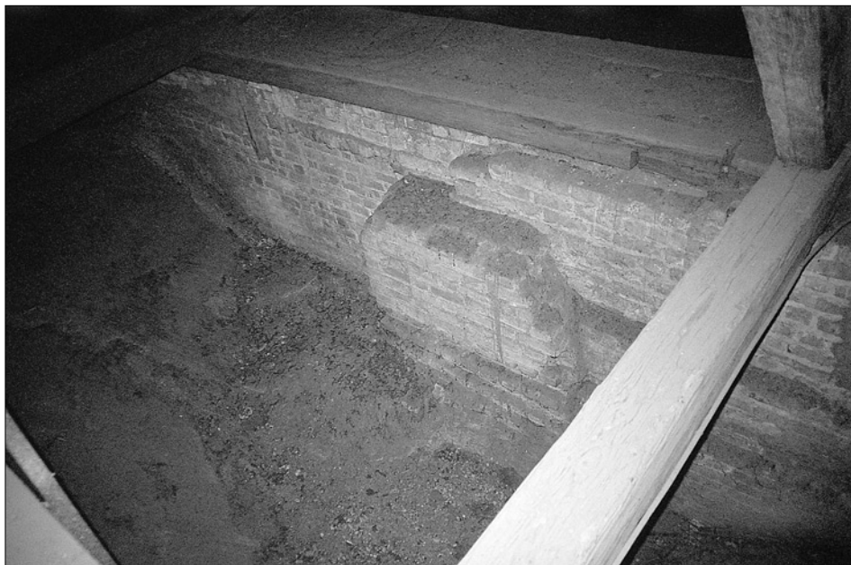
Obr. 24: Hlubčice, městský kostel Panny Marie. Rozhraní východního a středního pole hlavní lodi na jižní straně v pohledu od severozápadu, stav v roce 2003. Patrné torzo kolem roku 1300 odbouraného pasu, který původně rozděloval klenby obou polí. Nad torzem zřejmý odskok mladší západní partie arkádové zdi z doby kolem roku 1300.
