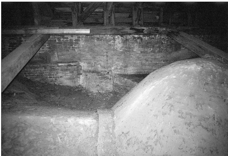
Obr. 18: Hlubčice, městský kostel Panny Marie. Rozhranní středního a východního pole severní lodi v podkroví, stav v roce 2003. Vlevo patrná nižší klenba středního pole z doby kolem roku 1300, vpravo vyšší raně gotická klenba z doby kolem 1250–před 1259. V pozadí na obvodové zdi fragment odbouraného pasu, vpravo s raně gotickou klenbou kolidující vazný trám krovu z roku 1826.
