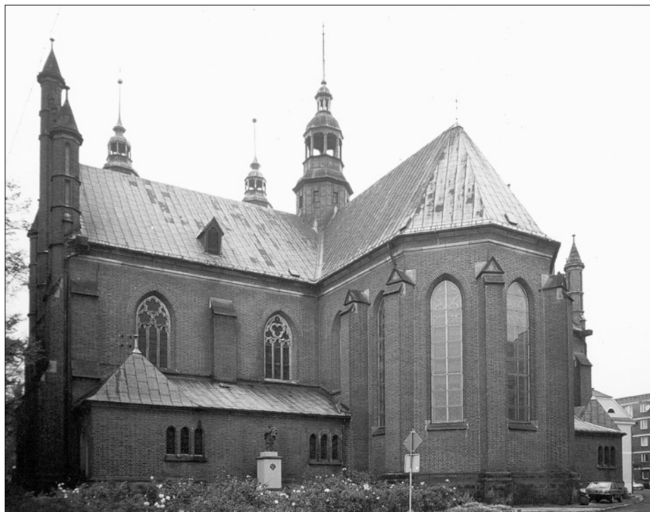
Obr. 6: Hlubčice, městský kostel Panny Marie. Pohled od jihovýchodu na pseudogotický transept a novogotickou repliku presbytáře z let 1903–1907, stav v roce 2000.
