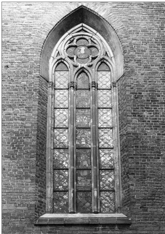
Obr. 7: Hlubčice, městský kostel Panny Marie. Východní okno v jižní zdi trojlodí, kolem 1250 – před 1259, stav z roku 1995. Kružba je rekonstrukcí Maxe Hasaka podle fragmentů okna odhaleného v roce 1903 ve východní zdi jižní lodi, v níž byly osazeny dílce původních raně gotických svislých kruzbových prutů s vegetabilně zdobenými hlavicemi a torza patek.
