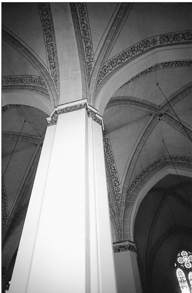
Obr. 19: Hlubčice, městský kostel Panny Marie. Východní pilíř v jižní arkádové řadě trojlodí z doby kolem 1250–před 1259, pohled od jihu, stav v roce 2003. Výzdoba hlavice koutové přípory a hlavice pásu vpravo od ní raně gotická, výzdoba na jižní straně pilíře a vlevo je doplňkem Maxe Hasky z let 1903–1906.
