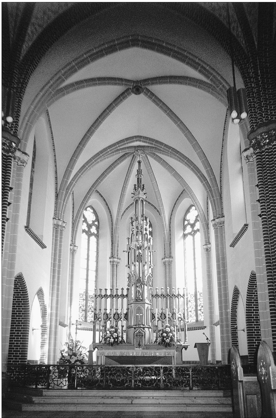
Obr. 30: Hlubčice, městský kostel Panny Marie. Pohled do novogotické repliky presbytáře z let 1903–1906 s původními příporami a klenebními žebry, stav v roce 2003. Kružby jsou replikami Maxe Hasaka podle originální kružby, nalezené v severní zdi původního presbytáře.
