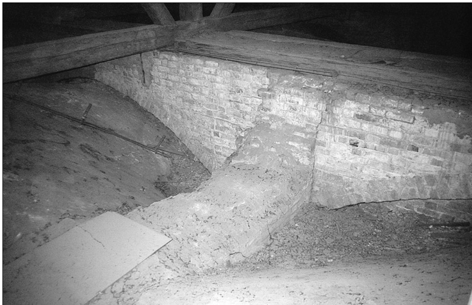
Obr. 21: Hlubčice, městský kostel Panny Marie. Jižní arkádová zeď trojlodí s rozhranním středního a východního pole jižní lodi v pohledu od jihovýchodu, stav v roce 2003. Patrna lůžka pro založení kleneb, tvořící současně vynášecí pasy druhotně snižené arkádové zdi a dále dílem sekundárně snesený rub meziklenbního pasu mezi východním a středním polem klenby.
