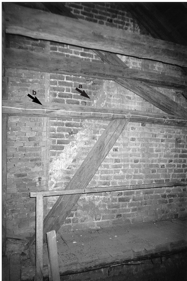
Obr. 39: Hlubčice, městský kostel Panny Marie. Východní zeď severní lodi v podkroví kostela s patrným otiskem starší střechy (šipka a), stav v roce 2003. Vlevo zřejmý náběh arkády štitové zdi, sekundárně v 16. století přizdělý ke starší věži (šipka b).
