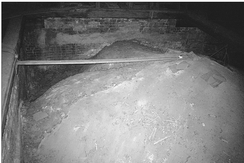
Obr. 23: Hlubčice, městský kostel Panny Marie. Rub klenby východního pole jižní lodi v pohledu od severu, stav v roce 2003. Patrné rozhraní raně gotického jádra klenby z doby kolem 1250–před 1259 a její rekonstruované části z doby kolem roku 1300.
