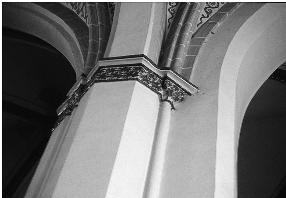
Obr. 16: Hlubčice, městský kostel Panny Marie. Jižní tříčtvrtěpilíř, pohled od jihozápadu, stav v roce 2003. Vpravo patrná okosená arkáda do novogotického transeptu, prolomená teprve Maxem Hasakem v roce 1903.
