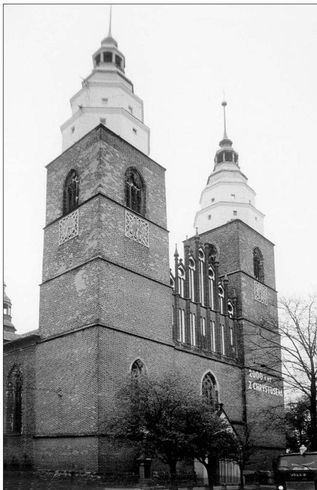
Obr. 1: Hlubčice, městský kostel Panny Marie. Západní průčelí, stav v roce 2000. Štít mezi věžemi z let 1904–1905, oktogonální nástavba jižní (tzv. staré) věže z roku 1579, zvýšení hranolové části severní věže a osmiboká nástavba z roku 1905 (všechny snímky a kresby autor, není-li uvedeno jinak).
