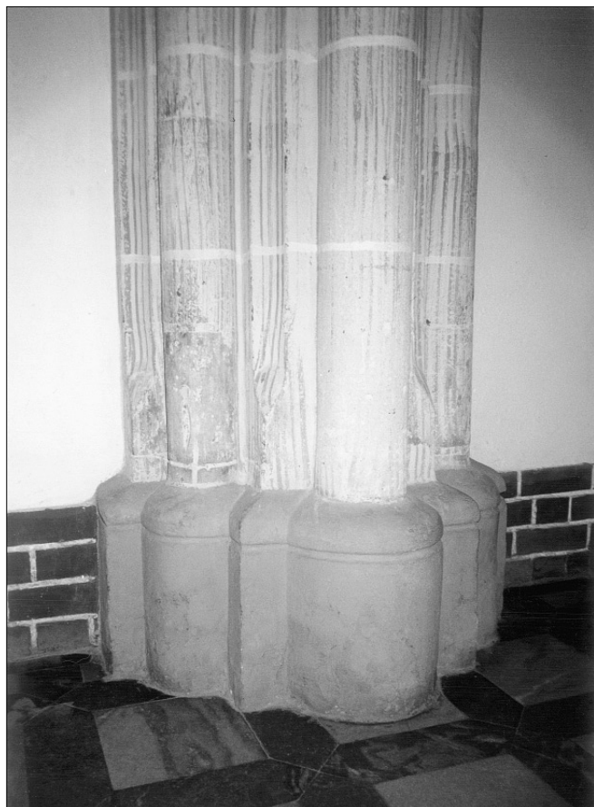
Obr. 28: Hlubčice, městský kostel Panny Marie. Patka svazkové přípory na jižní obvodové zdi trojlodí na rozhraní středního a západního pole z doby kolem roku 1259, stav v roce 1995.
