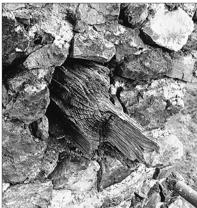
Obr. 19: Žebrák, hrad, dolní palác. Detail konce trámu, který vyčnívá z jižního průčelí (snímek V. Razím, 2000).
