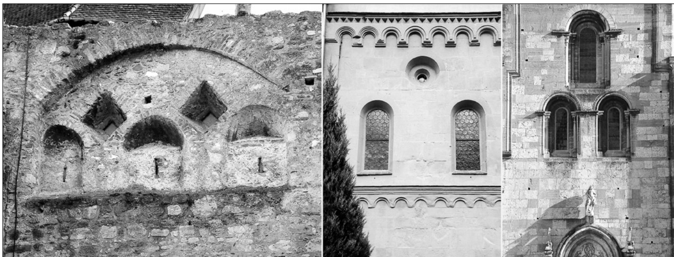
Obr. 43: Příkladů užítí trojúhelního seskupení oken v dřevem zateplené místnosti (A – Perchtoldsdorf u Vídně, hrad) a na stavbách, kde horní okno mělo jednoznačně pouze osvětlovací účel, (B – Schönggrabern, Dolní Rakousko, boční strana chóru románského kostela, C – Heiligenkreuz, Dolní Rakousko, románské západní průčelí klášterního kostela cisterciáků). Snímky V. Razím, 2003.
