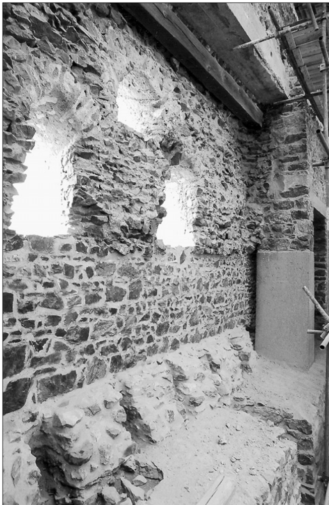
Obr. 34: Radyně, hrad. Otisk čelní stěny dřevem vyložené místnosti v 1. patře paláce se třemi okénky. Po stranách a mezi okénky otisky srubu, pod okénky plochá stěna (snímek V. Razím, 2003).
