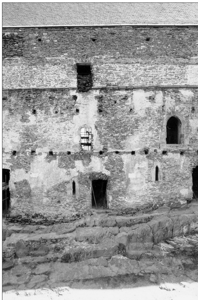
Obr. 39: Bezděz, hrad. Výsek nádvorní fasády tzv. Královského paláce. Nad kapsami trámů zaniklé kryté pavlače 1. patra vpravo vstupní portál sálu a uprostřed otvor topeniště v dřevem vyložené místnosti (snímek M. Míčka, 2003).
