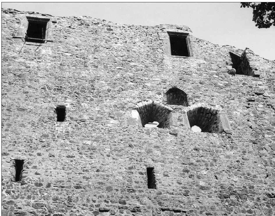
Obr. 35: Radyně, hrad. Průčelí paláce s trojicí okének dřevem vyložené místnosti v 1. patře (snímek V. Razím, 2003).
