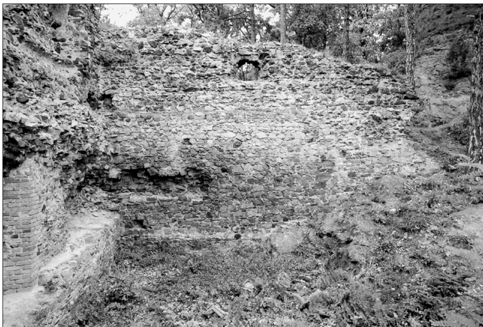
Obr. 20: Žebrák, hrad, dolní palác. Pohled na vnitřní dělicí zeď od jihu. Nahoře příkládací otvor kamen v 1. patře (snímek V. Razím, 2003).
