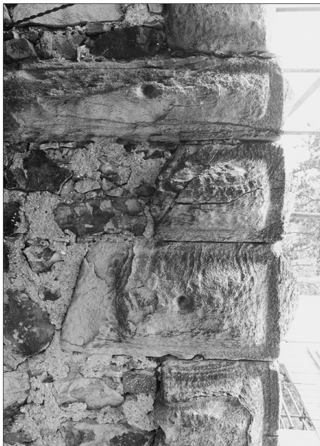
Obr. 13: Žebrák, hrad, dolní palác. Detail bosovaných kvádrů jihozápadního nároží (snímek H. Heckelová, 2000).
