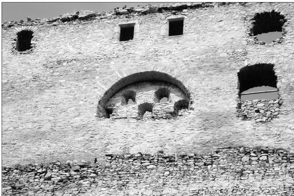
Obr. 32: Kašperk, hrad. Průčelí paláce s nikou obsahující pět okének dřevem vyložené místnosti – srov. obr. 33 (snímek V. Razím, 2003).
