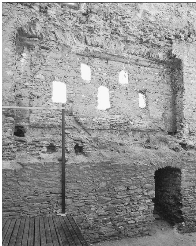
Obr. 33: Kašperk, hrad. Otisk čelní stěny nízké dřevem vyložené plochostropé místnosti paláce s pěti okénky (snímek V. Razím, 2003).
