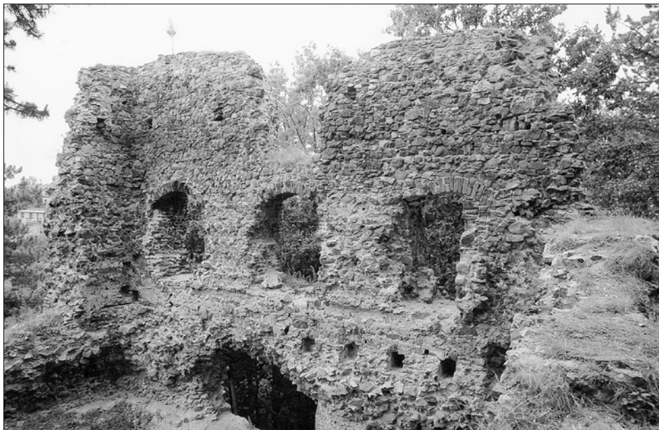
Obr. 12: Žebrák, hrad, dolní palác. Pohled na západní a jižní stěnu hlavní místnosti 1. patra. Pod okny a mezi nimi otisky zaniklého srubu, nad okny hrubě lícovaná stěna s prolukou středního okna a zbytky čtyř trámů (snímek V. Razím, 2003).
