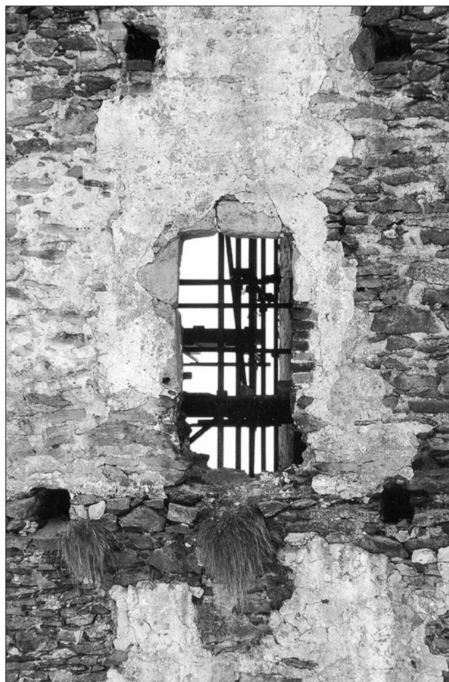
Obr. 40: Bezděz, hrad. Detailní pohled na otvor topeniště dřevem vyložené místnosti (srov. obr. 39). Způsob úprav ostění (vlevo a nahoře) umožňuje uvažovat o jeho raně gotickém původu a příslušnosti k topeništi již z tohoto období (snímek M. Míčka, 2003).
