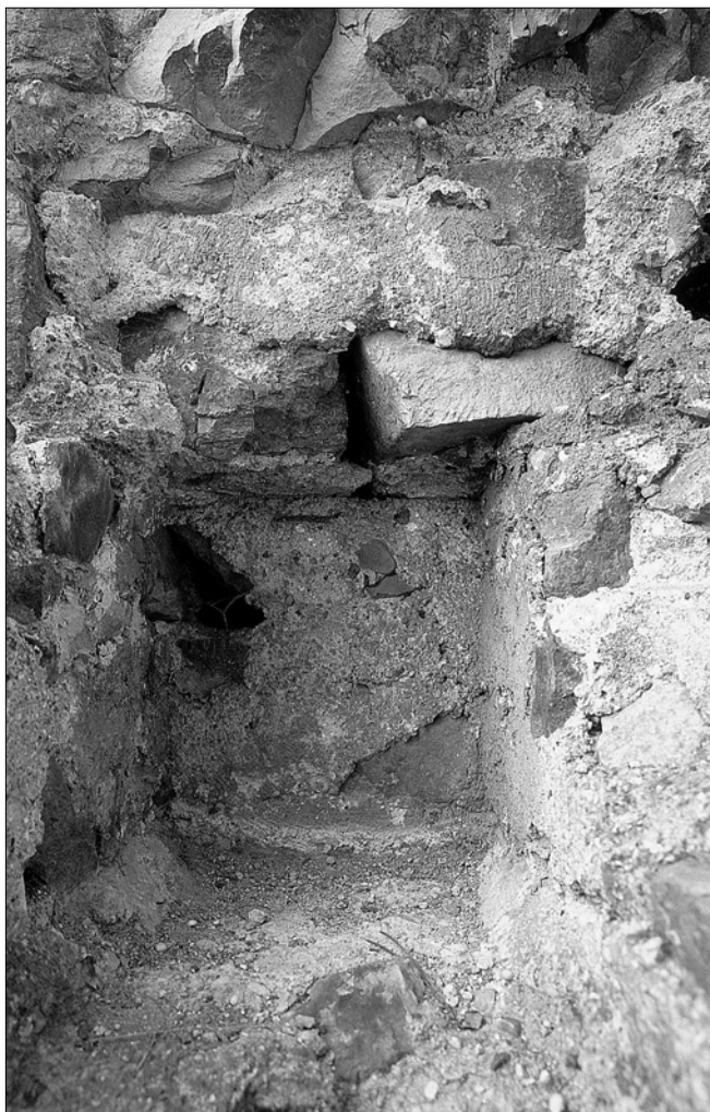
Obr. 16: Žebrák, hrad, dolní palác. Detail otisku čela kolmé fošny nad trámem podlahy – srov. obr. 15 (snímek V. Razím, 2003).
