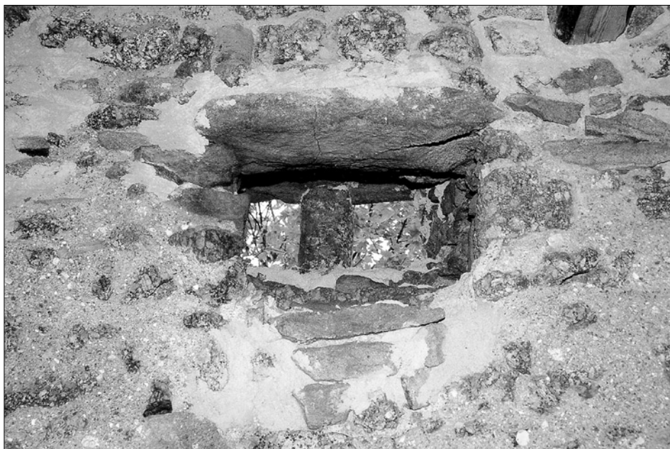
Obr. 27: Ruttenstein, hrad (Horní Rakousko). Detail komínového otvoru v obytné věži – srov. obr. 26 (snímek V. Razím, 2003).
