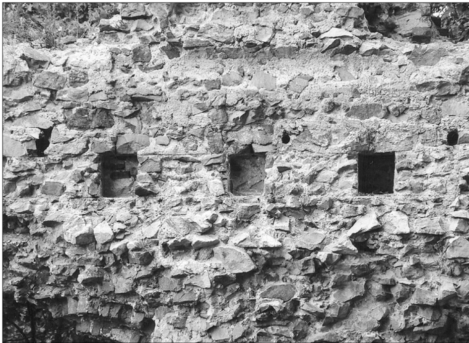
Obr. 15: Žebrák, hrad, dolní palác. Detail západní stěny interiéru hlavní místnosti 1. patra s kapsami trámů podlahy. Pod kapsami odlámaný líc stěny přízemí, nad kapsami otisky srubu. Nad střední kapsou otisk čela kolmé fošny – srov. obr. 16 (snímek V. Razím, 2003).
