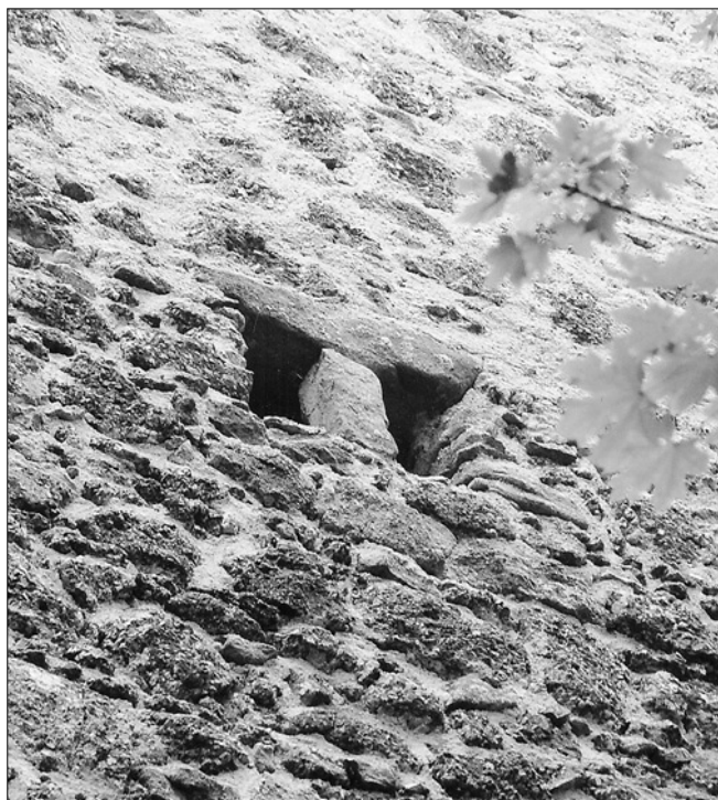
Obr. 28: Ruttenstein, hrad (Horní Rakousko). Detail komínového otvoru na fasádě obytné věže – srov. obr. 27 (snímek V. Razím, 2003).
