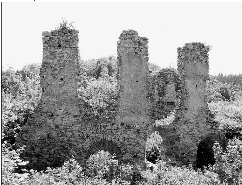
Obr. 42: Templštejn, hrad. Průčelí paláce s trojicí oken v dolním podlaží, patřící roubené místnosti. Střední okno je pouze mírně vyvýšené (snímek V. Razím, 2003).
