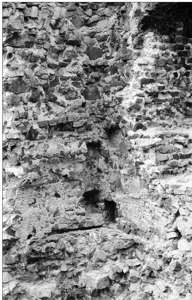
Obr. 17: Žebrák, hrad, dolní palác. Detail jihozápadního koutu interiéru hlavní místnosti 1. patra. Negativ konců prken podlahy (dole) a konců trámů roubené konstrukce. Vlevo otisky kuláčů (snímek V. Razím, 2003).
