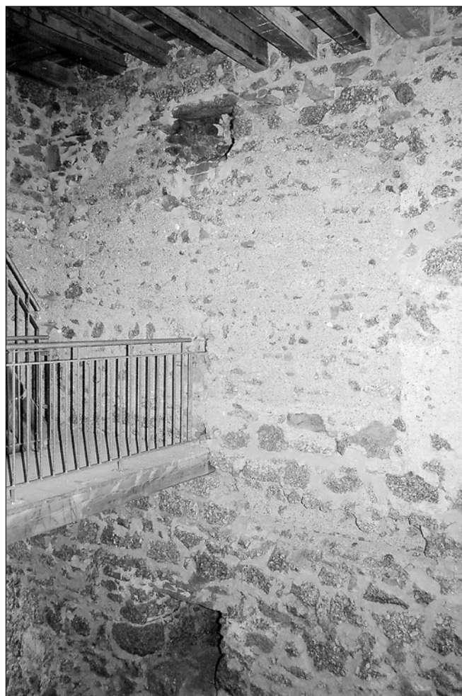
Obr. 26: Rutenstein, hrad (Horní Rakousko). Pohled na protější stěnu (srov. obr. 24) v patře románsko-gotické obytné věže s otisky fošen a klenby, nad ním komínový otvor (snímek V. Razím, 2003).
