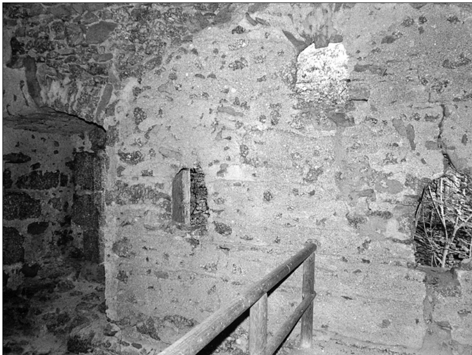
Obr. 24: Rutenstein, hrad (Horní Rakousko). Pohled na stěnu v patře románsko-gotické obytné věže s vodorovnými otisky fošen a třemi okénky. Vlevo u hrany nůky vstupu otisk dřevěné příčky, nad ním šikmý otisk klenby (snímek V. Razím, 1998).
