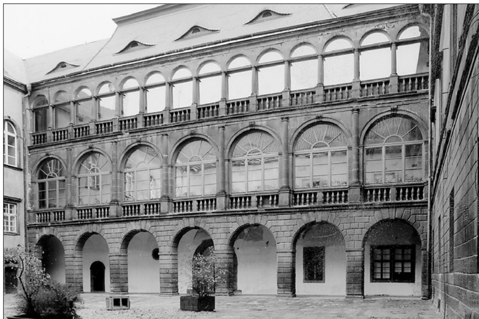
Obr. 7: Kostelec nad Černými lesy, vstupní křídlo vlastního zámku s nádvoří arkádou (foto V. Razím, 2003).
