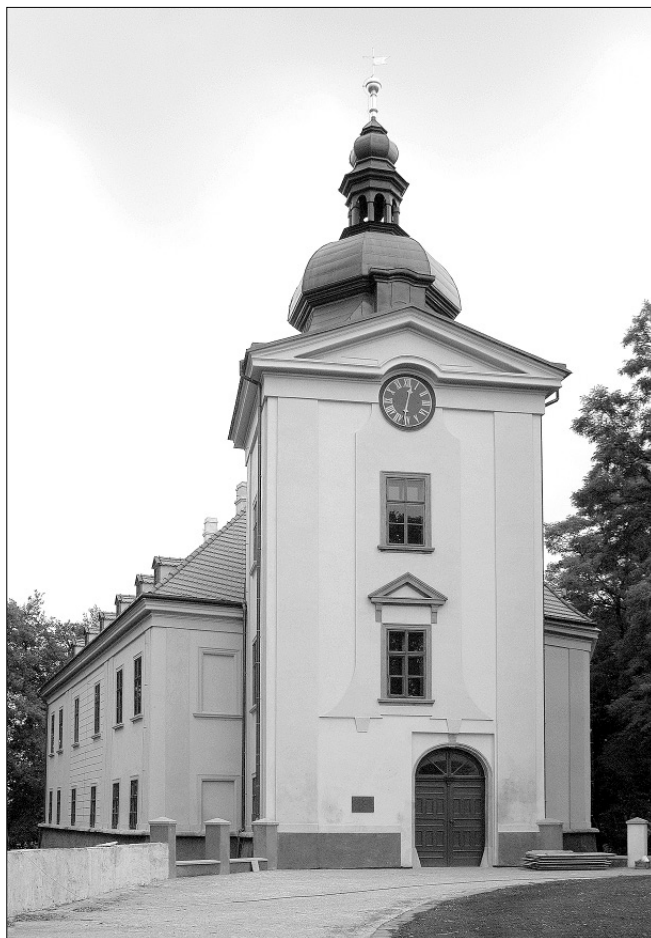
Obr. 49: Ctěnice (Praha-východ), zámecký areál. Vstupní věž zámku.
