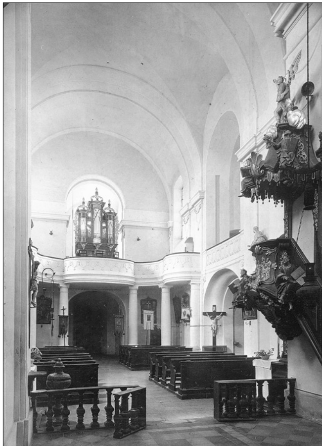
Obr. 32: Chlumín (Mělník) kostel. Pohled k západní kruchtě.
