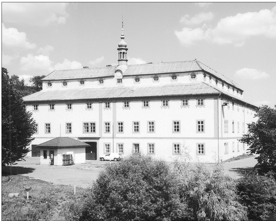
Obr. 40: Horní Police (Česká Lípa), zámek. Celkový pohled od západu.
