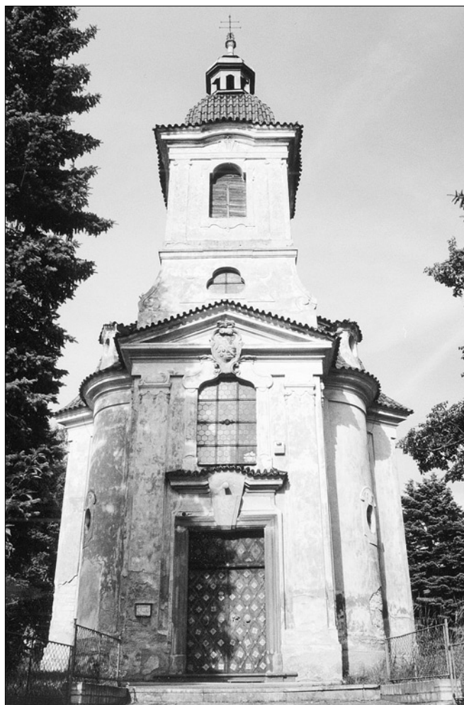
Obr. 55: Hořelice (Praha-západ), kostel. Západní vstupní věž.
