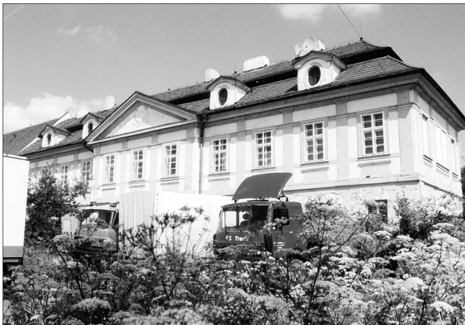
Obr. 57: Hořelice (Praha-západ), zámek. Jižní průčelí.
