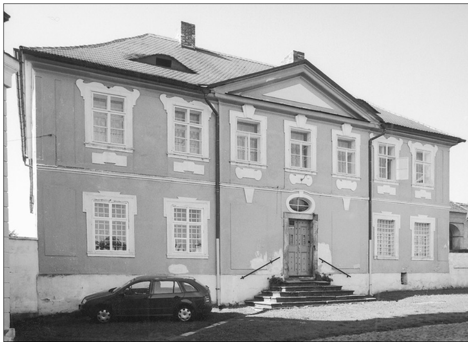
Obr. 11: Horní Police (Česká Lípa), poutní areál. Hlavní průčelí arciděkanství.
