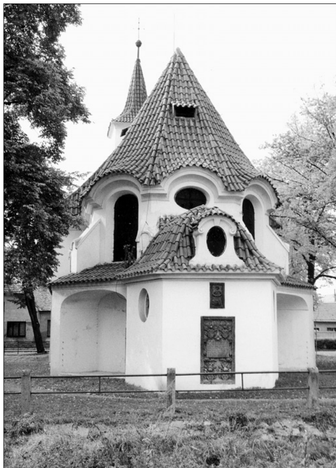
Obr. 50: Sluhy (Praha-východ), kostel. Východní zbarokizovaný závěr se sakristií.
