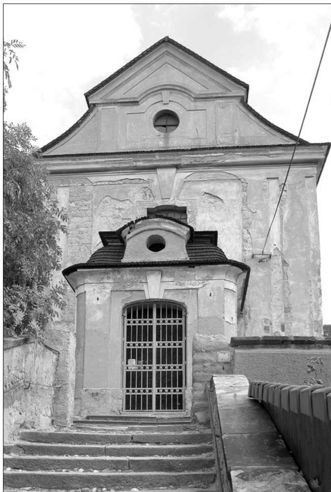
Obr. 23: Zeměchy (Mělník), kostel. Západní průčelí.
