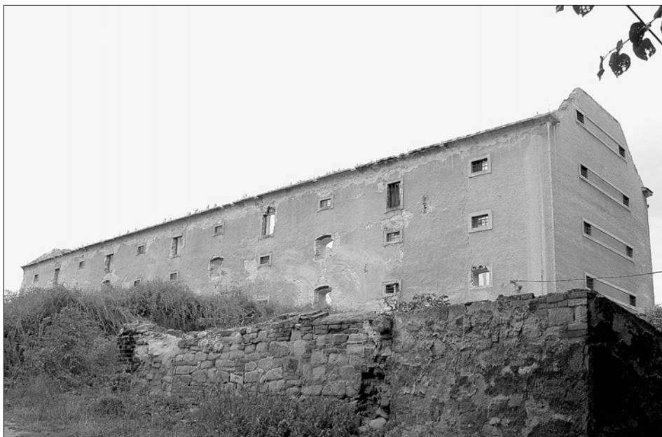
Obr. 12: Olovnice (Kladno), hospodářský dvůr. Torzo mohutné sýpky.
