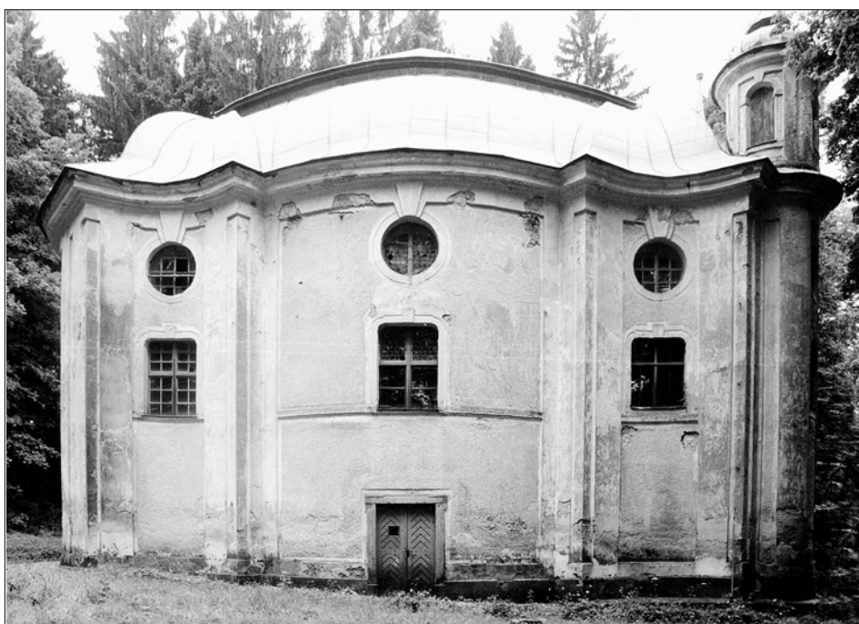
Obr. 19: Počátky - Lázně sv. Kateřiny (Pelhřimov), kostel. Pohled od severu.
