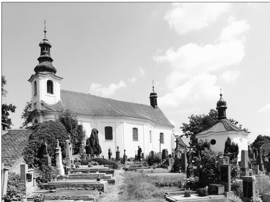
Obr. 52: Tachlovice (Praha-západ), kostel. Celkový pohled od jihozápadu.
