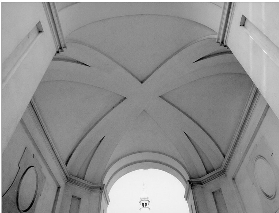
Obr. 59: Horní Police (Česká Lípa). Klenba vstupní věže poutního areálu.
