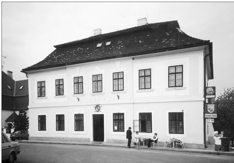
Obr. 30: Svádov (Ústí nad Labem), fara. Hlavní jižní průčelí.
