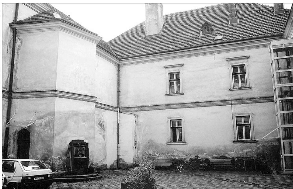
Obr. 4: Žireč, nádvoří zámku – jezuitské rezidence, pohled do jihovýchodního rohu. Vlevo je snižený zbytek šestiboké nárožní věže renesančního zámku.
