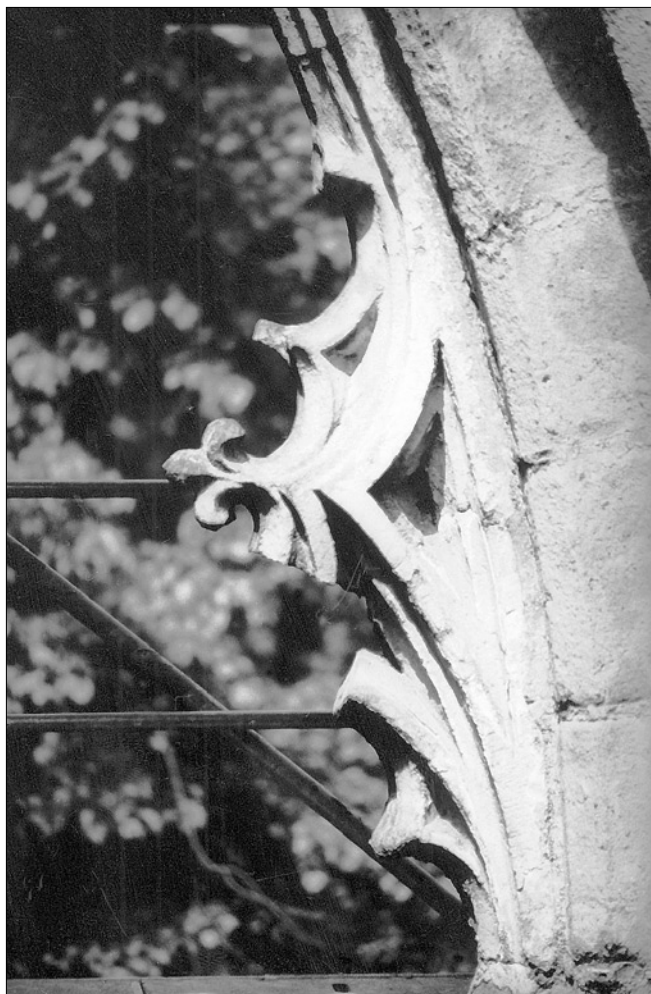
Obr. 45: Ojvín, kostelní ruína. Detail části chórové okenní kružby s nosem a polodrážkou po osazení vitraje [foto R. Němec, 2002].
