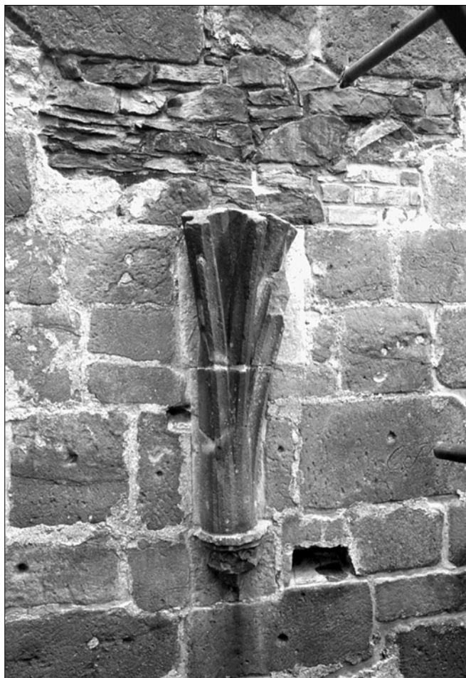
Obr. 49: Ojvíň, kostelní ruína. Východní polygonální kaple, druhotně vložený klenební výběh do severní zdi chóru (foto R. Němec 2004).
