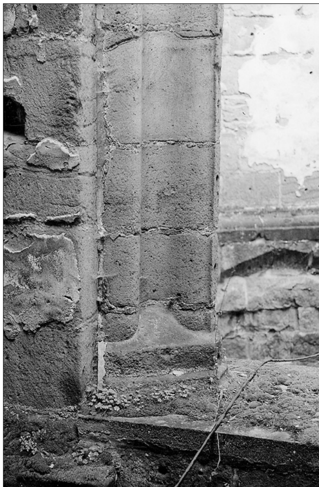
Obr. 52: Ojvín, kostelní ruína. Detail dveřního ostění severních kaplí s ondulovanou profilací (foto R. Němec, 2002).
