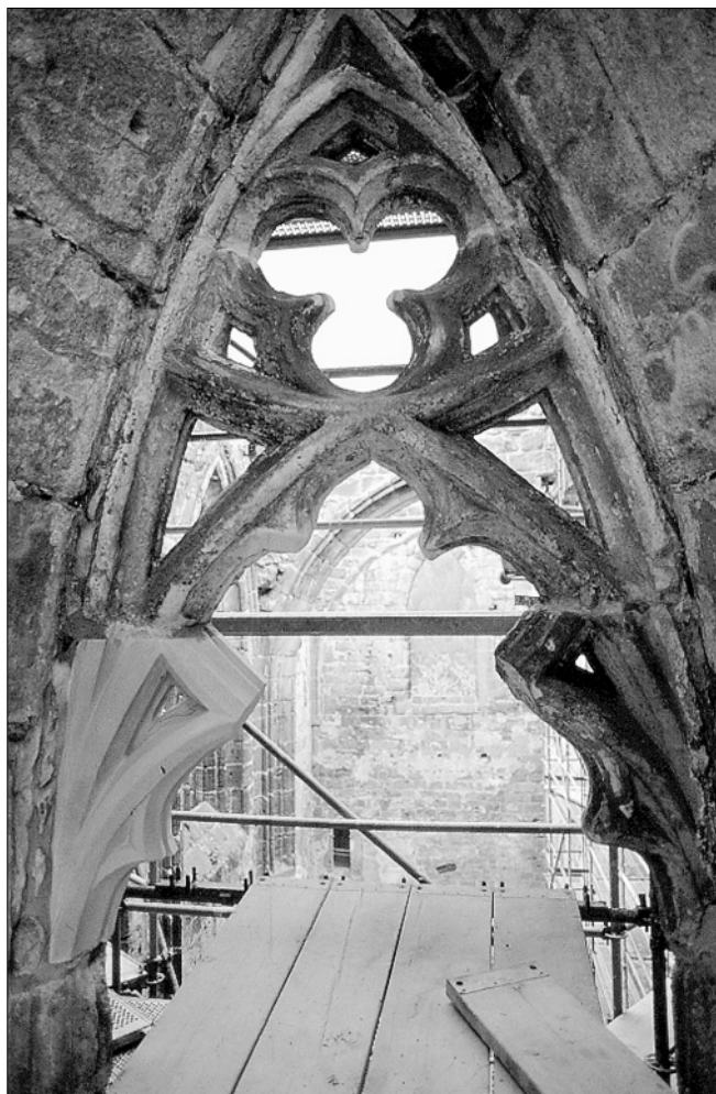
Obr. 47: Ojvíň, kostelní ruína. Detail kružby závěrového chórového okna s doplněným segmentem (foto R. Němec, 2003).
