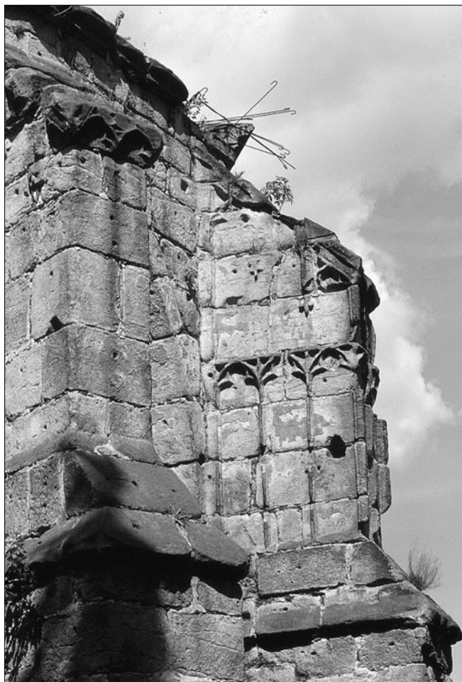
Obr. 34: Ojvín, kostelní ruína. Detail lípané paneláže na čele a bocích vnějšího chórového opěráku (foto R. Němec, 2002).
