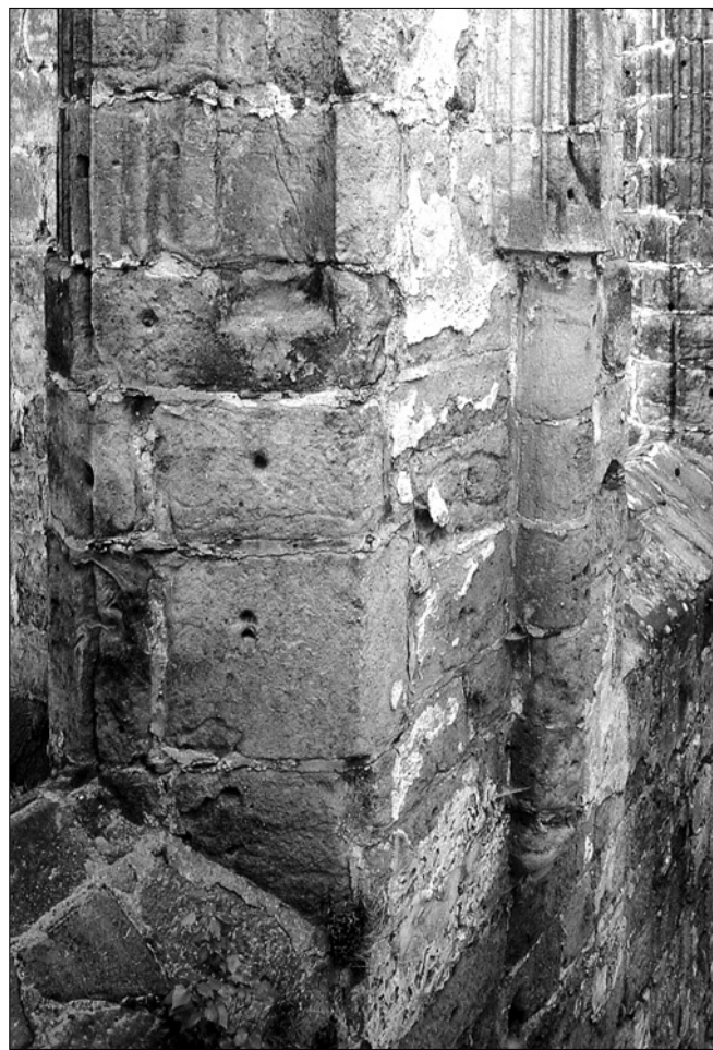
Obr. 43: Ojvín, kostelní ruína. Detail změny profilace okenního ostění severního chórového okna, pohled z lodi (R. Němec, 2002).
