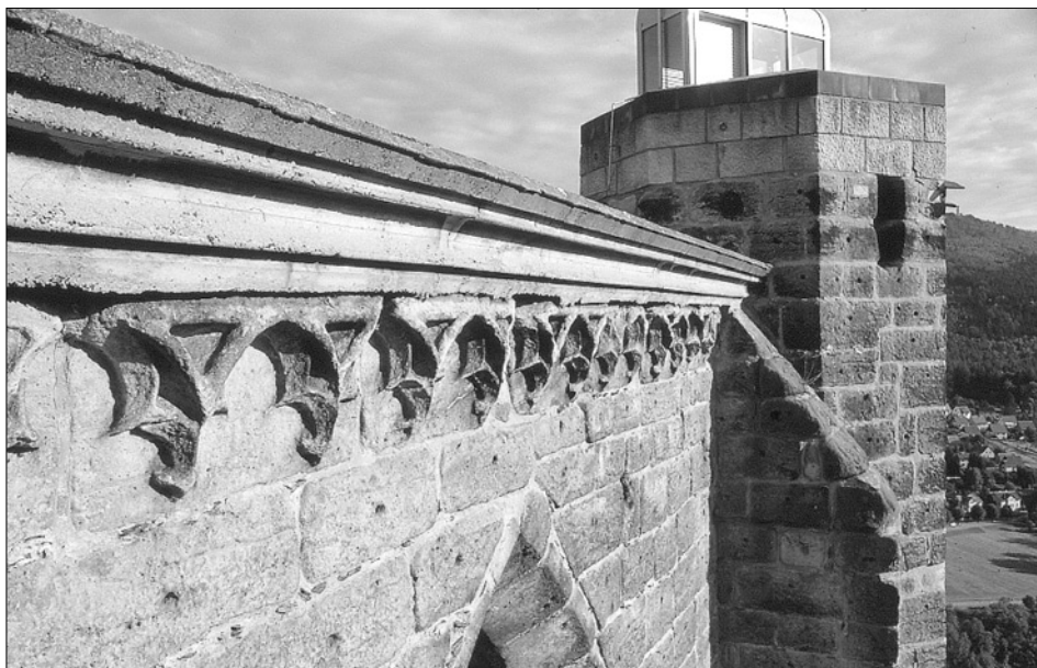
Obr. 31: Ojvír, kostelní ruína. Detail lípaného liliového vlysu západní fasády s věží. Betonová římsa odlita v rámci rekonstrukce v roce 1966 (foto R. Němec, 2002).
