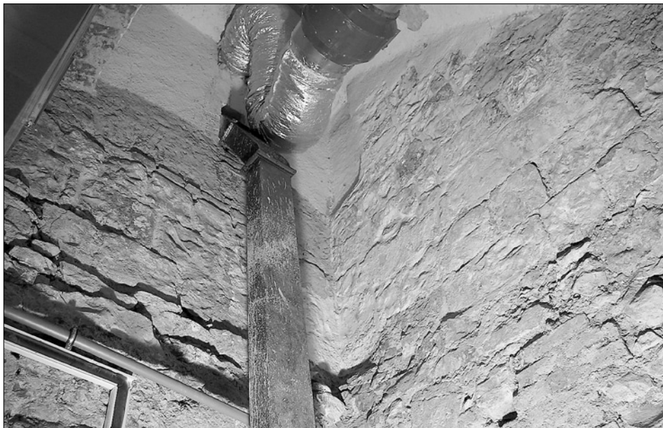
Obr. 3: Severovýchodní nároží nově zjištěné stavby. Pohled od jihozápadu (foto M. Müller).
