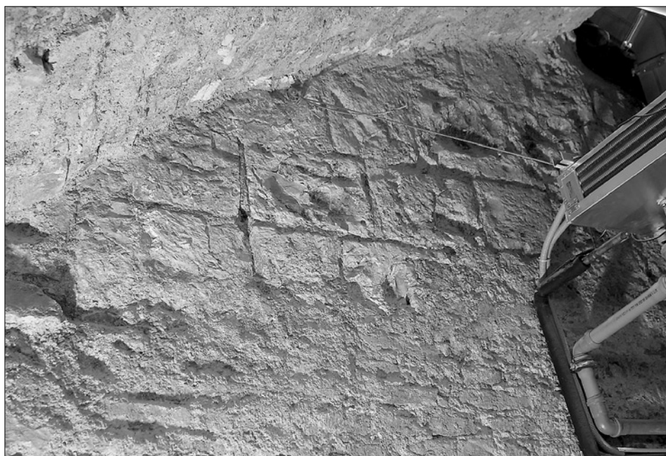
Obr. 2: Kvádříkové zdivo v severní průčelní stěně sklepa domu čp. 479/I. Pohled od jihu (foto M. Müller).
