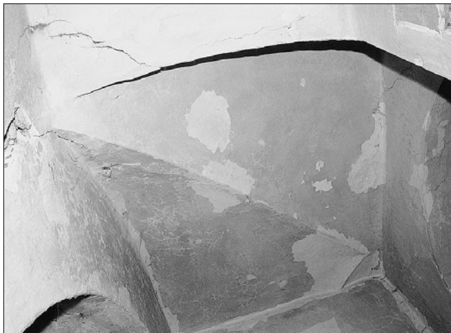
Obr. 18: Zahrádka, klenba v místnosti č. 106. Vlevo dole je vidět pas na severní stěně, v poli klenby pak jemný hřebínek na hranách průniku klenbových ploch. Vpravo je patrná mladší příčka se stlačeným pasem podporující klenbu v místě příčky mezi místnostmi č. 205 a 206 (foto J. Veselý).
