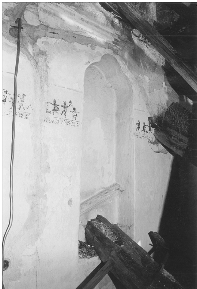
Obr. 11: Zahrádka, místnost č. 209 (snad jídelna), pohled na zazděný otvor schodiště s dřevěným madlem zábradlí ve východní stěně (foto J. Veselý).
