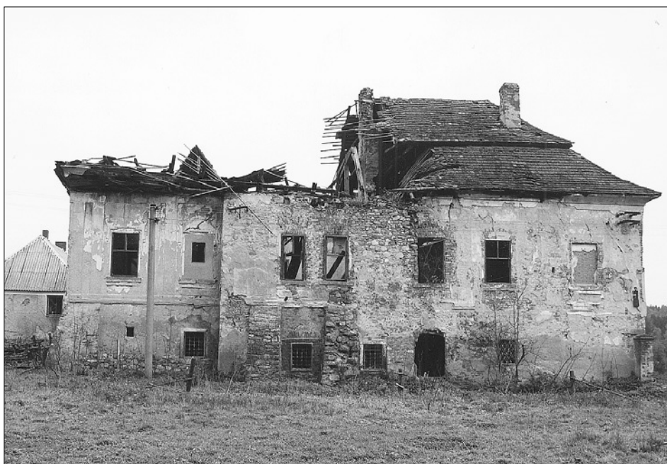
Obr. 9: Zahrádka, západní fasáda zámku. V centrální části je v přízemí, vpravo od opěráků patrná starší opekaná omítka, v patře pak soustava tří záklenků nad těsně sousedícími okny (foto J. Veselý).
