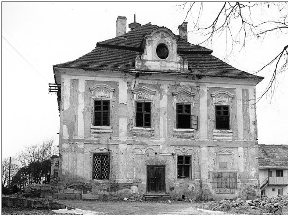
Obr. 12: Zahrádka, jižní průčelí zámku. Stav v šedesátých letech 20. století (originál uložen ve fotoarchivu NPÚ-ÚOPSC).
