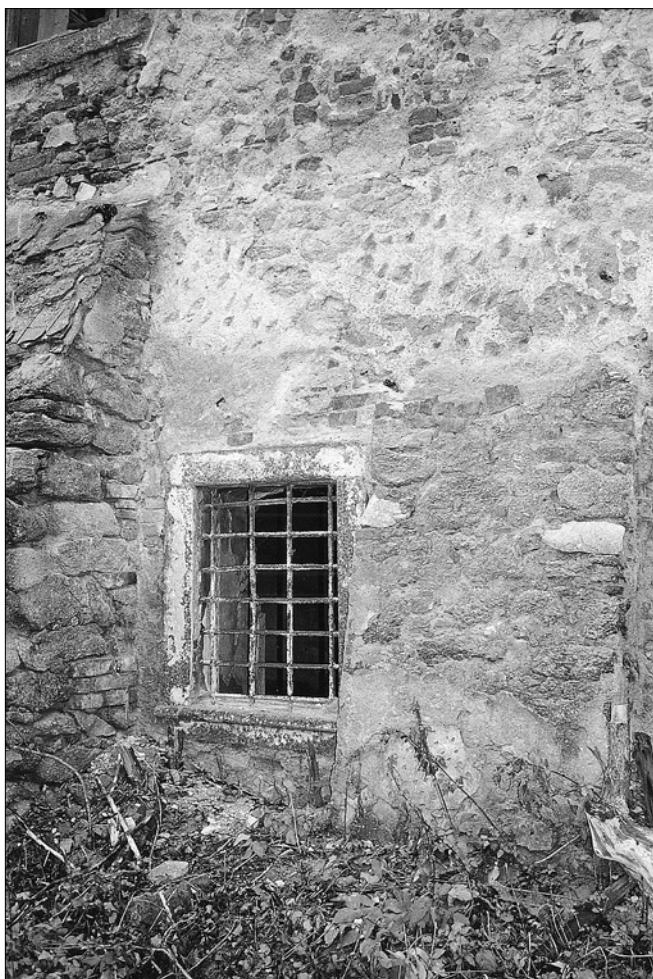
Obr. 13: Zahrádka, detail západní fasády. Na snímku je patrný druhotný vztah opěráků i osazení ostění okna ke starší opekované omítce. Zřetelná je rovněž vodorovná fázová spára u úrovní vrcholu opěráku, totožná s ostřím ohraničením starší omítky (foto J. Veselý).
