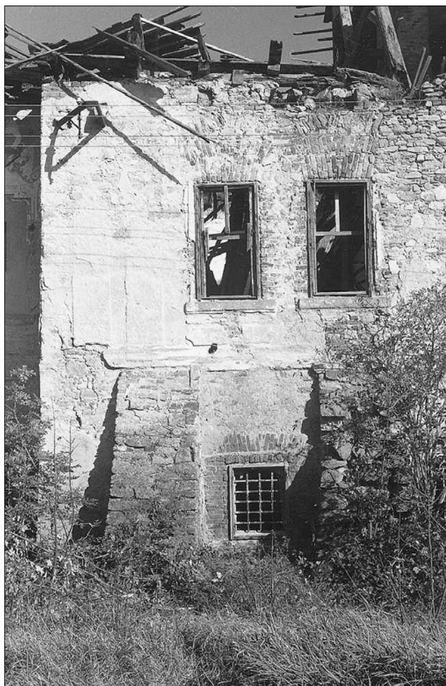
Obr. 15: Zahrádka, detail západní fasády. Pod opadanou omítkou nad dvojicí oken v patře jsou viditelné trojnásobné záklenky – dva cihelné a jeden kamenný nad každým oknem.
