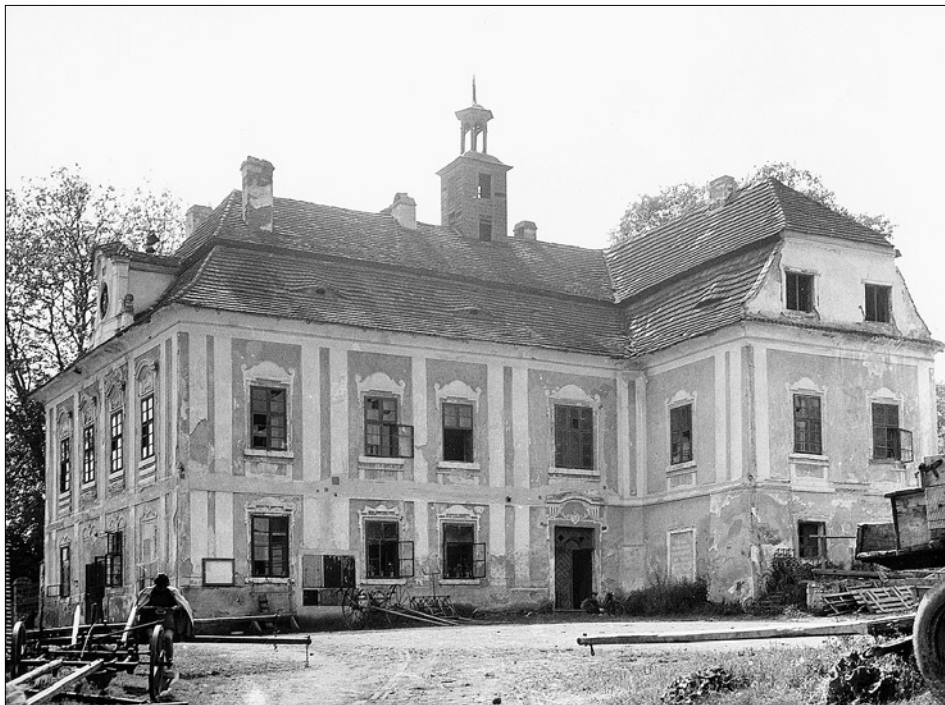
Obr. 1: Zahrádka (okres Příbram), pohled od jihovýchodu z prostoru hospodářského dvora (stav v padesátých letech 20. století, originál uložen ve fotoarchivu NPÚ-ÚOPSC).
