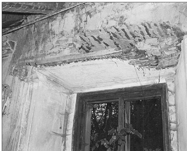
Obr. 20: Zahrádka, místnost č. 210, typická konstrukce falešného rovného záklenku okenní niky v části zámku pocházející nepochybně z dvacátých let 18. století (foto J. Veselý).
