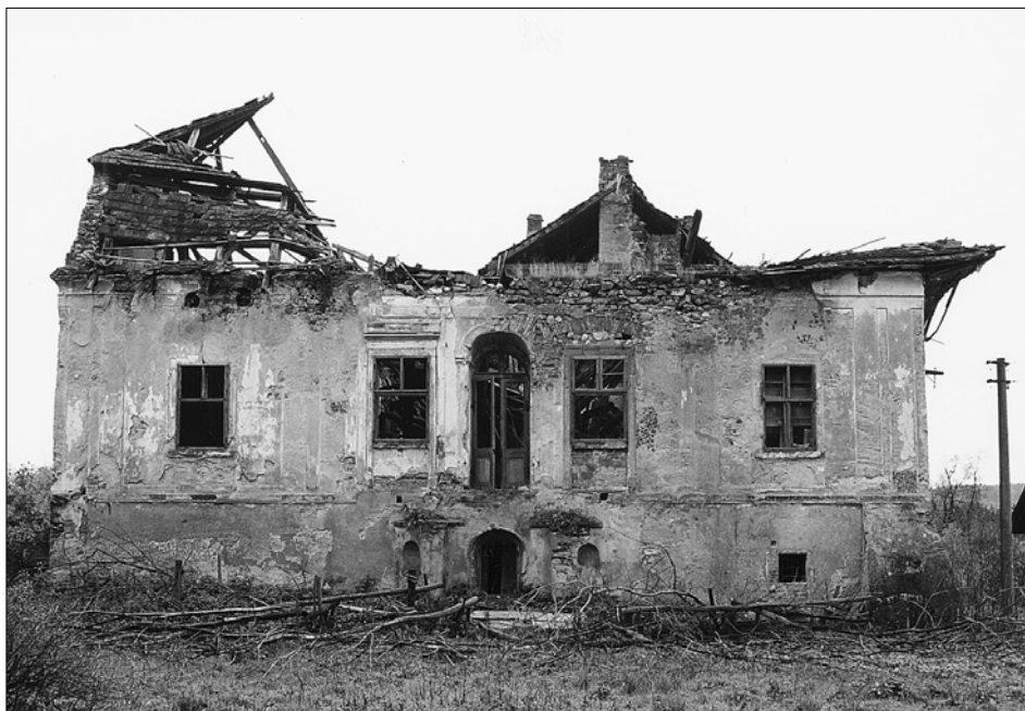
Obr. 8: Zahrádka, severní fasáda zámku. Na snímku jsou čitelné všechny podstatné skutečnosti. Průčelí nemá v přízemí architektonické dělení. V levé části je zřetelná plocha opekané starší omítky. Symetricky, po stranách otvoru na ose vyběhající pilířky s nikami jsou zbytky zaniklé terasy, jejíž rozsah je vymezen přerušením kordonové římsy. V patře jsou dobře patrná částečně zazděná francouzská okna salonu a v pravé části snímku velké plentované plochy fasády (foto J. Veselý).
