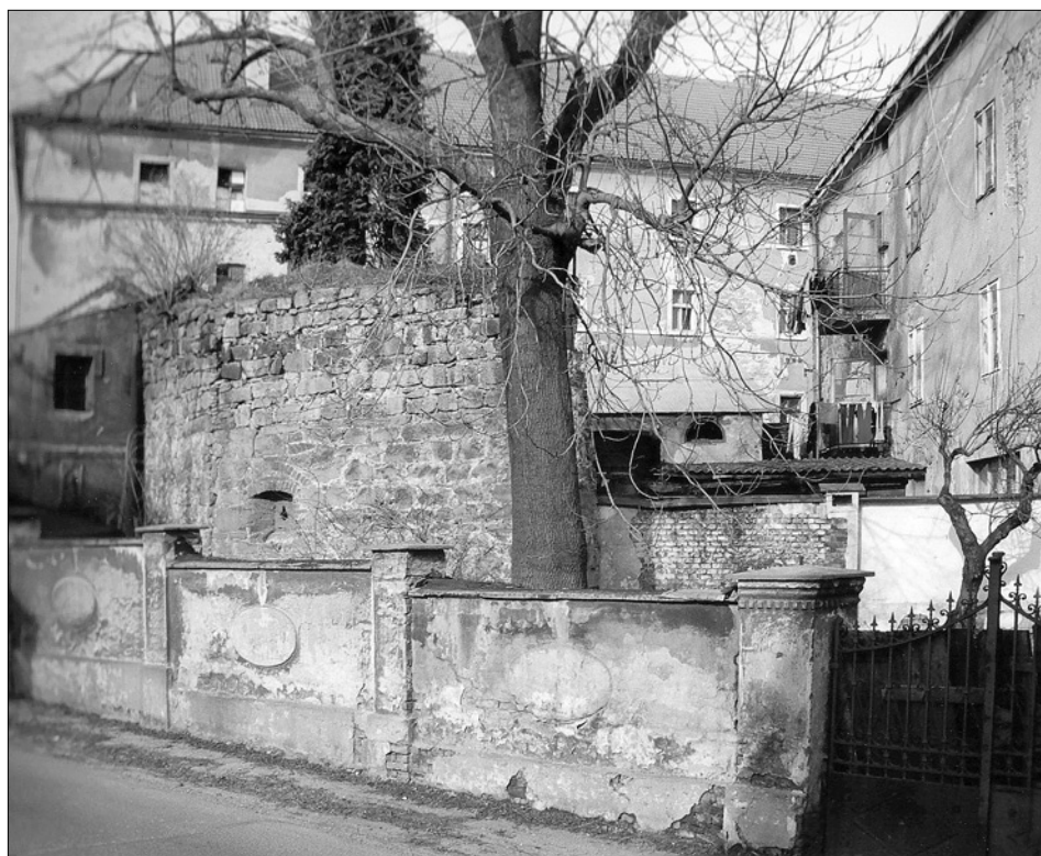
Obr. 17: Jičín. Celkový pohled od jihu na vnější líc části hradby v ulici Na Hrádku (za čp. 21) (foto P. Uličný, 2002).
