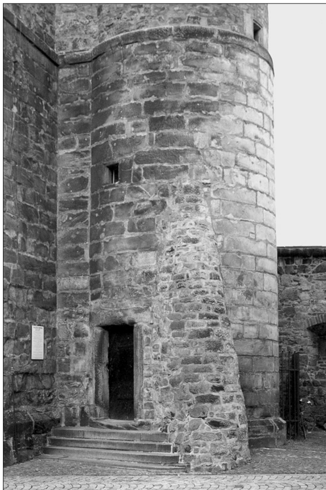
Obr. 10: Jičín. Valdická brána. Stopy po odbourané hradbě na plášti schodiškové věže (foto P. Uličný, 2002).
