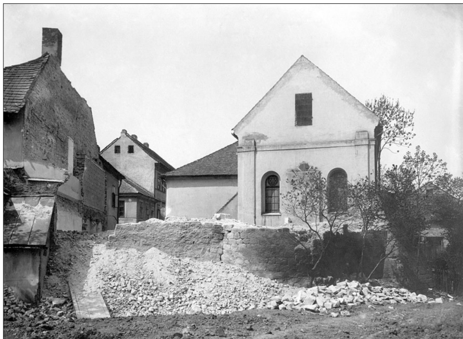
Obr. 28: Jičín. Hradební zeď s půlkruhovou baštou východně od synagogy před zbořením (foto Antonín Brožek. 1907, RMaG Jičín, F 3261).
