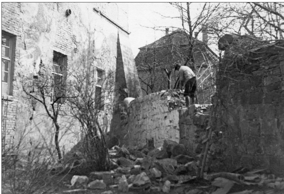
Obr. 12: Jičín. Vnitřní líc původní hradební zeď při jihovýchodním pilíři Valdštejnského paláce při bourání. Kolem 1938 (RMAg Jičín, F 498).
