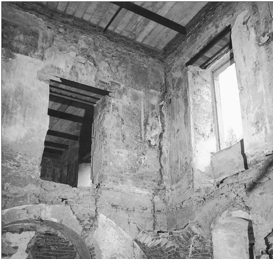
Obr. 12: Linhartovy, interiér v jižním křídle zámku, stav v roce 1970 (foto archiv NPÚ, územní odborné pracoviště v Ostravě).
