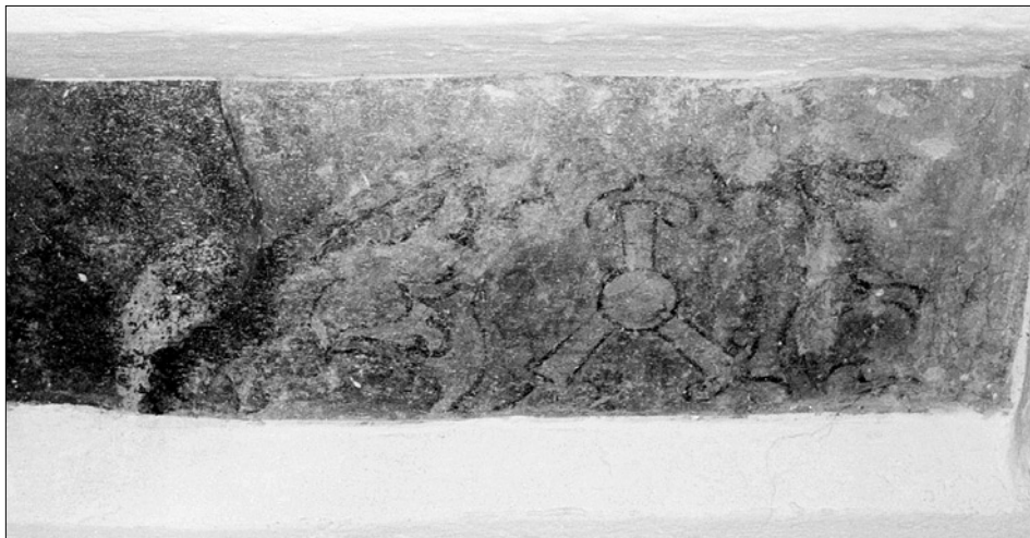
Obr. 14: Linhartovy, erbovní znamení pánů z Fulštejna, odkryto na západní stěně, na arkádách – 3. nadzemní podlaží (foto L. Dědková).
