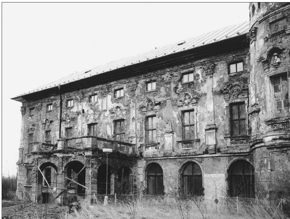
Obr. 7: Linhartovy, severní průčelí, stav kolem roku 1980. Okna v přízemí vpravo byla vsazena do vybraných vynášecích oblouků (foto archiv NPÚ, územní odborné pracoviště v Ostravě).
