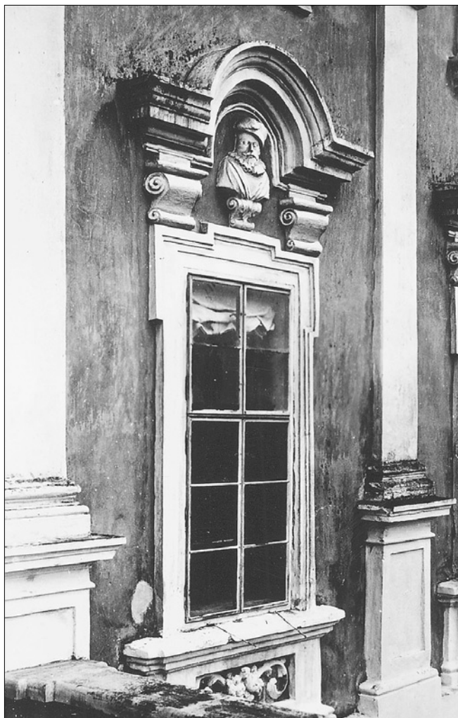
Obr. 6: Linhartovy, severní fasáda, detail před rokem 1943 – záběr na okno napravo od balkónu (archiv NPÚ, územní odborné pracoviště v Ostravě).
