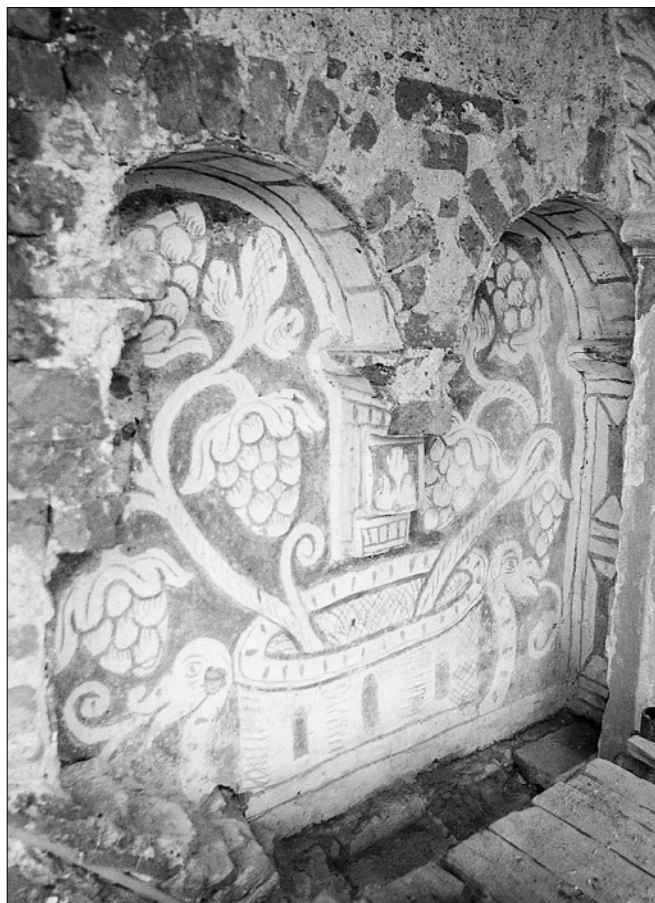
Obr. 18: Linhartovy, sgrafito na severní fasádě, odkryté a zpětně zazděné v roce 2003 (foto G. Čočková).
