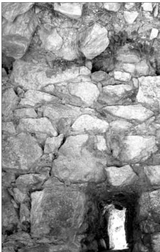
Obr. 33: Rabí, hrad, výklenek jižní střelecké komory polygonální bašty se šterbinovým okénkem směřujícím k východu (foto J. Noll, 2004).
