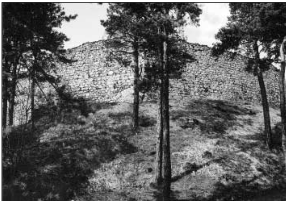
Obr. 48: Rabí, hrad, hradba jižního úseku vnějšího opevnění od jihu s patrnou zazdívkou velkého, segmentově sklenutého otvoru při úpatí (foto J. Varhaník, 2005).
