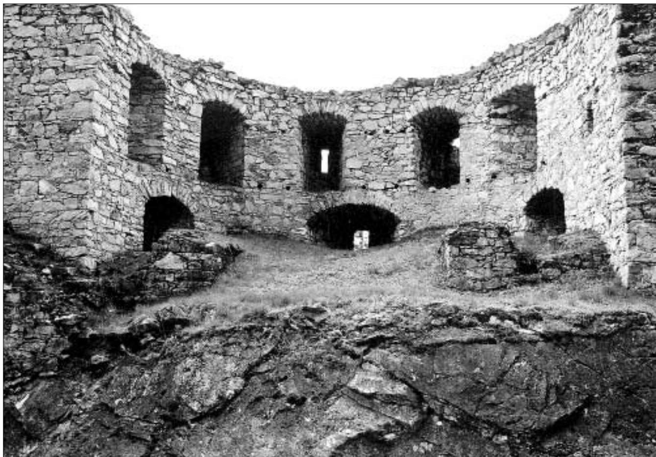
Obr. 45: Rabí, hrad, vnitřek půlválcové bašty se zbytky zdiva bašty a kurtin staršího opevnění. Na krátkém úseku kurtiny vpravo patrná spodní část šterbinové střílny (foto J. Varhaník, 2005).
