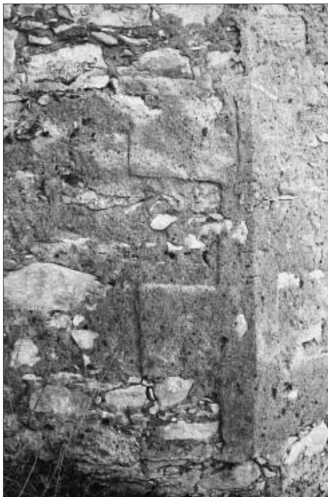
Obr. 29: Rabí, hrad, nároží polygonální bašty s kvádrováním, modelovaným v omítce (foto J. Varhaník, 2005).
