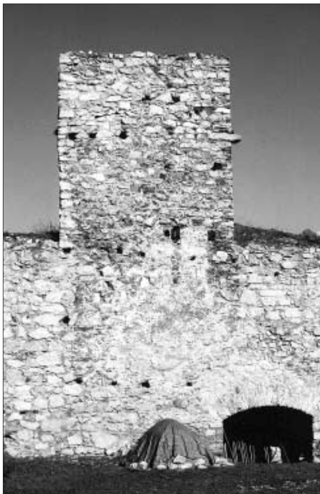
Obr. 22: Rabí, hrad, úsek vnitřního líce zdiva západní kurtiny severního opevnění a jižní průčelí západní vížky s třemi úrovněmi kapes pro konstrukci pavlače a její pultové stříšky. Levá spodní část líce zdiva vížky je částečně přezděna při opravě (foto J. Varhaník, 2005).
