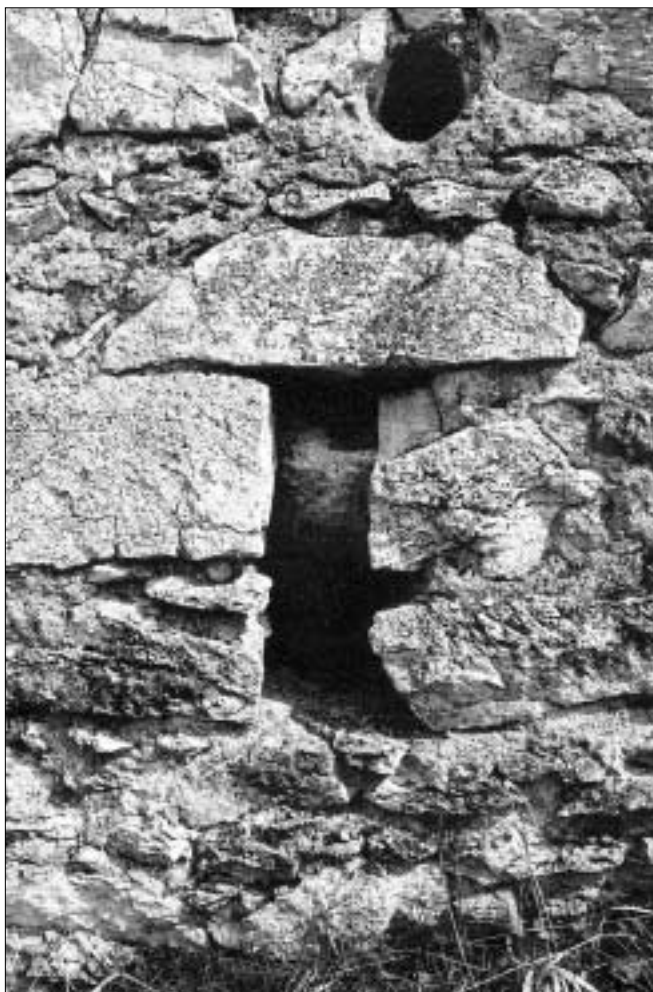
Obr. 27: Rabí, hrad, ústí zazděné severní štěrbínové střelny ze starší fáze vnějšího opevnění v severozápadní kurtině (foto J. Varhaník, 2005).
