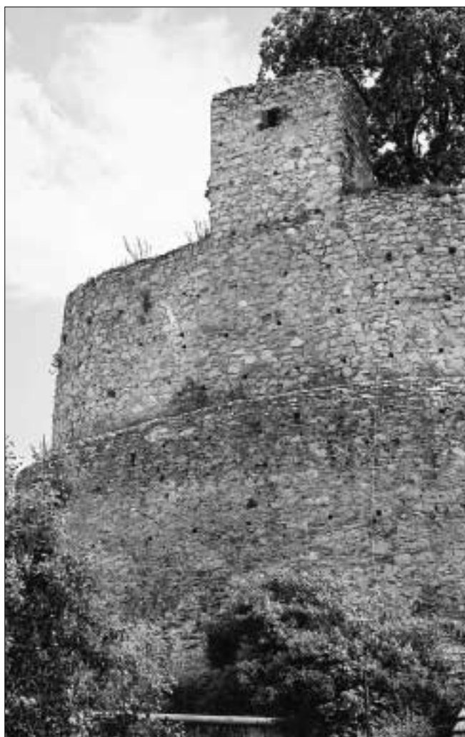
Obr. 12: Rabí, hrad, východní část vnějšího opevnění s hranolovou vížkou na koruně a trojicí střelnových otvorů pod úrovní soklu (foto J. Varhaník, 2004).
