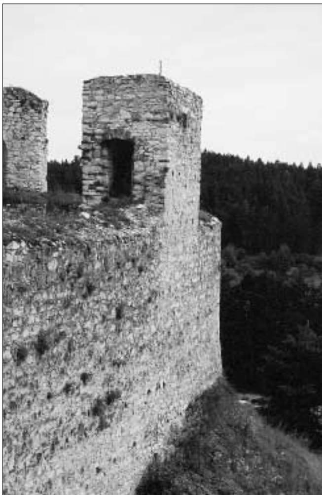
Obr. 21: Rabí, hrad, západní část hradeb severního opevnění s hranolovou vížkou od východu. Na spodní části jejího severního průčelí jsou patrné zbytky omítky (foto J. Varhaník, 2004).
