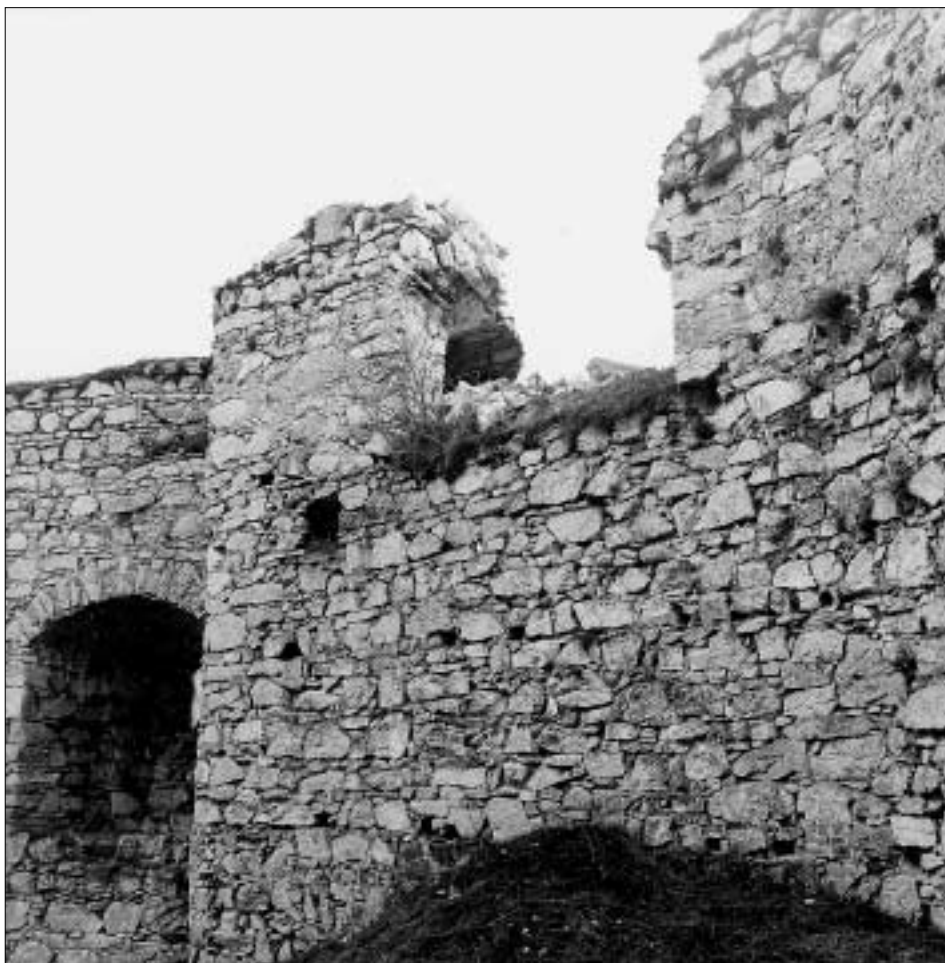
Obr. 32: Rabí, hrad, vnitřek polygonální bašty. Jižní střelecká komora se zříceným záklenkem (foto z fotoarchivu NPÚ ÚOP v Plzni, foto Koděra, 1995).
