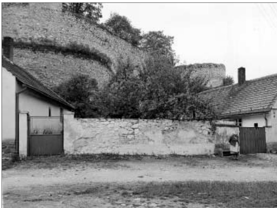
Obr. 13: Rabí, hrad, severní opevnění od severovýchodu se střední baštou v pozadí. Na koruně zdiva jsou patrné pozůstatky předprsní zdi ochozu (snímek z fotoarchivu NPÚ ÚOP v Plzni, foto J. Gryc, 1981).
