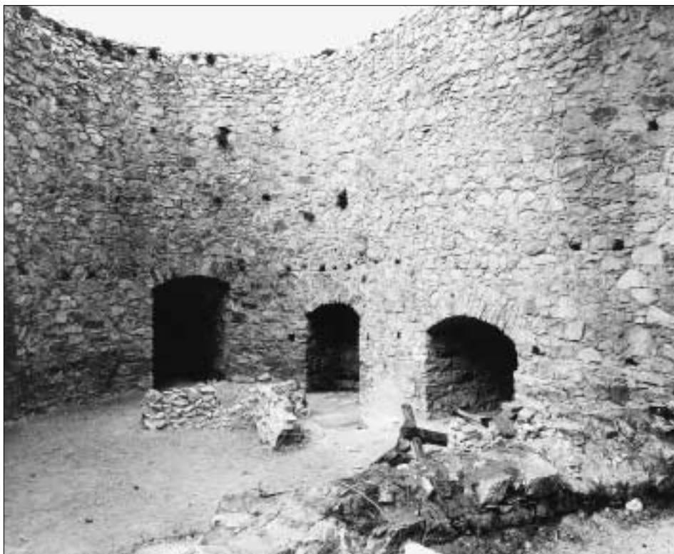
Obr. 18: Rabí, hrad, interiér střední severní bašty během prací. Těsně pod korunou zdiva jsou patrné kapsy po trámech (snímek z fotoarchivu NPÚ ÚOP v Plzni, foto J. Gryc, 1992).
