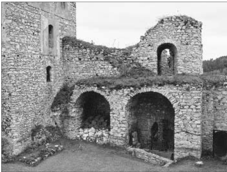
Obr. 25: Rabí, hrad, arkády na západní straně severního nádvoří. Vlevo při průčelí věže zbytky schodiště (foto J. Varhaník, 2004).
