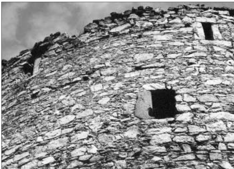
Obr. 40: Rabí, hrad, čelní strana půlválcové bašty s fragmentem ostění klíčové střelny a dvěma štěrbinovými střelnami v horní úrovni (foto J. Varhaník, 2005).
