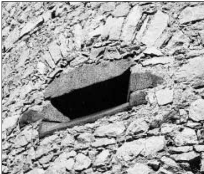
Obr. 43: Rabí, hrad, ostění jižní střelny ve spodní úrovni západní půlválcové bašty (foto J. Varhaník, 2005).
