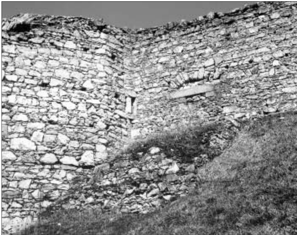
Obr. 35: Rabí, hrad, kout mezi polygonální baštou se šterbinovou střílnou a západní kurtinou se zazděnou obdélnou střílnou, v popředí zdivo hranolové bašty starší fáze vnějšího opevnění (foto J. Varhaník, 2004).
