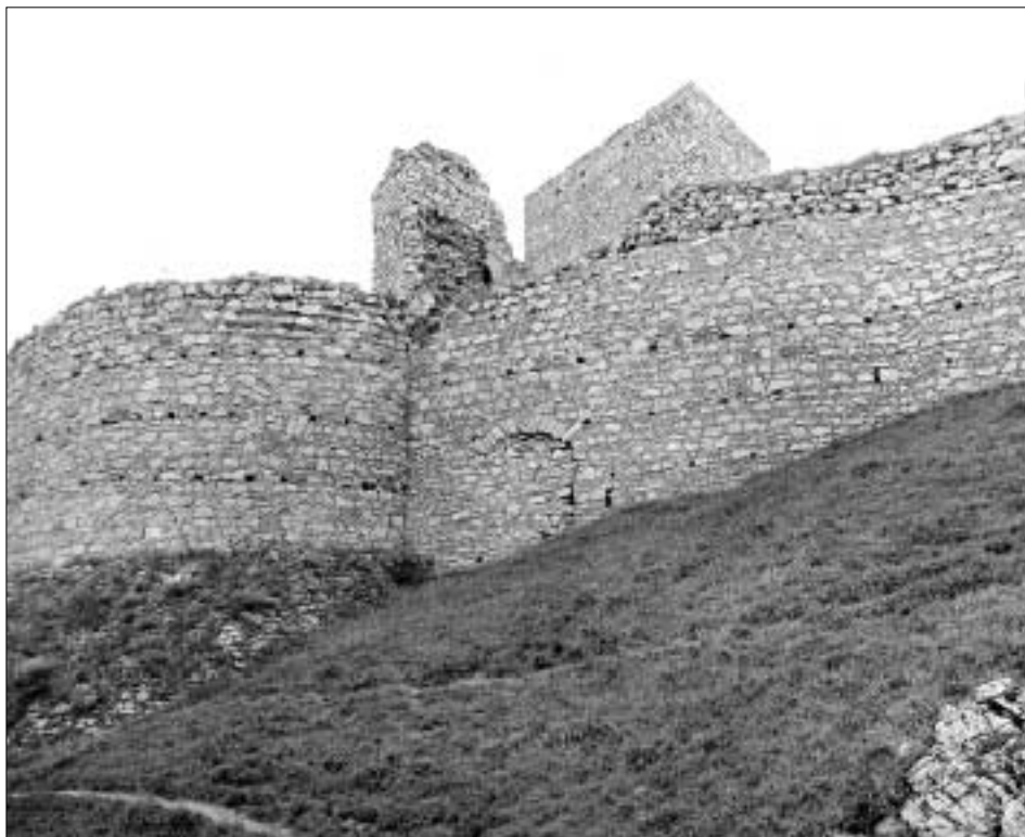
Obr. 26: Rabí, hrad, západní bašta severního opevnění s navazující severozápadní kurtinou, v jejíž spodní části jsou patrné dvě šterbinové střílny, náležející starší fázi vnějšího opevnění. Nad spárou zbytek dělicí zdi nad arkádami, v pozadí vrchol věže při Žižkově bráně (snímek z fotoarchivu NPÚ ÚOP v Plzni, foto J. Gryc, 1981).
