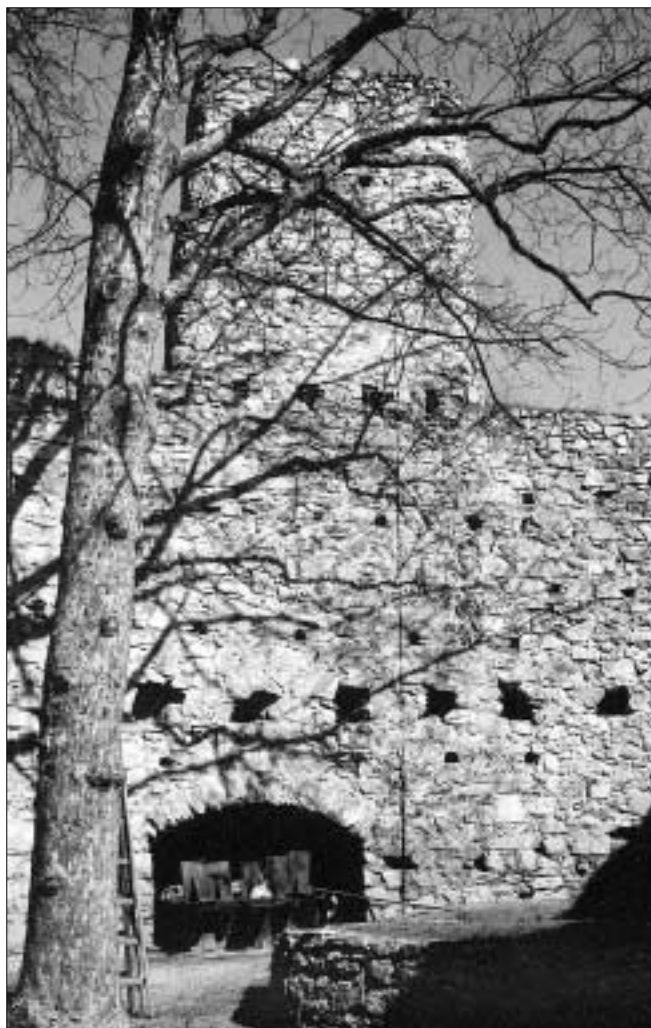
Obr. 15: Rabí, hrad, úsek vnitřního líce východní bašty s odlišnými úrovněmi otvorů po lešení a jižní průčelí východní vížky (foto J. Varhaník, 2005).
