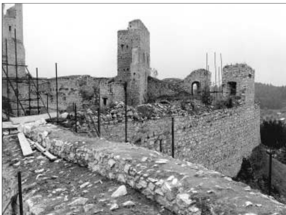
Obr. 16: Rabí, hrad, koruna zdiva střední bašty a západní kurtiny severního opevnění během stavebních prací. V úrovni věže Žižkovy brány je patrný poslední vyšší fragment předprsní zdi ochozu, záhy nato odstraněný (snímek z fotoarchivu NPÚ ÚOP v Plzni, foto J. Gryc, 1990).
