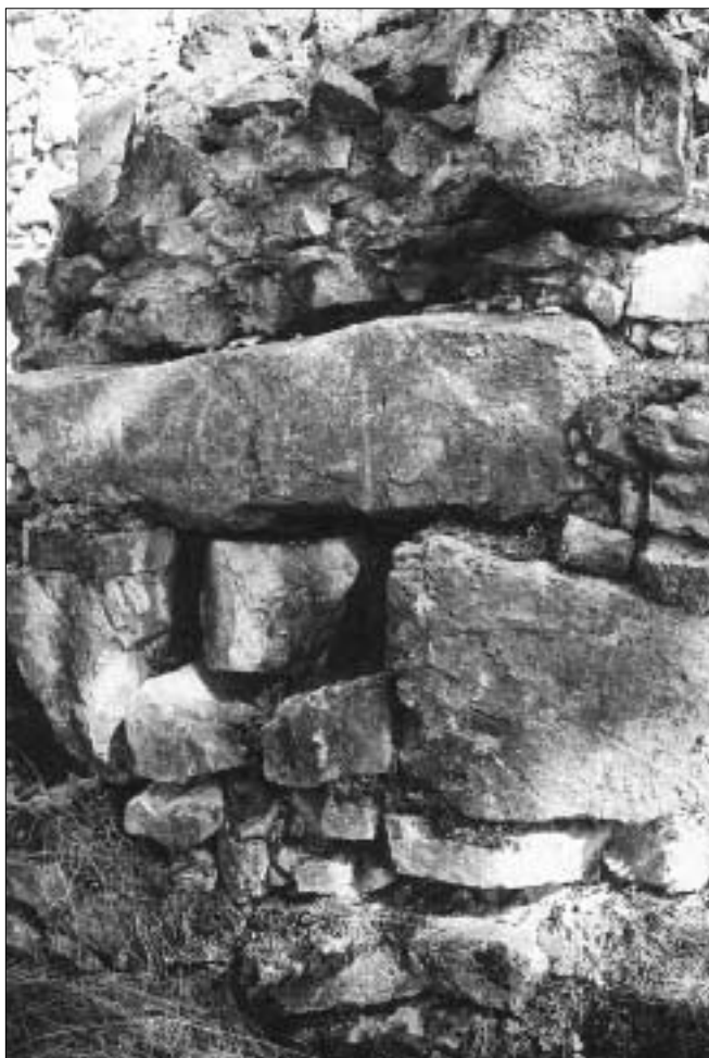
Obr. 46: Rabí, hrad, zazděné ústí střelecké komory v jižní kurtině, otvírající se v bloku nelicovaného zdiva, předstupujícího před vnější líc hradby (foto J. Varhaník, 2005).
