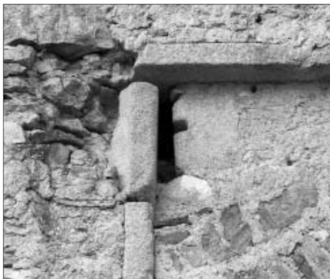
Obr. 37: Kašperk, dolní hrad, brána, detail druhotně použitých kamenických prvků brány vybavené zvedáním padacího mostu přes kladky.
