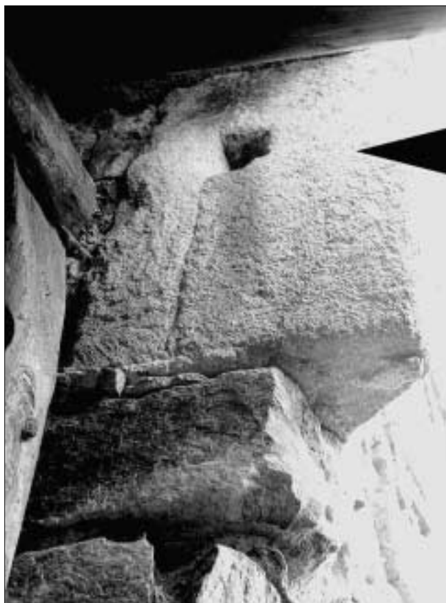
Obr. 6: Kašperk, hrad, vchod do jádra, detail kamenického prvku s otvorem patrně spojeným s funkcí padacího můstku.
