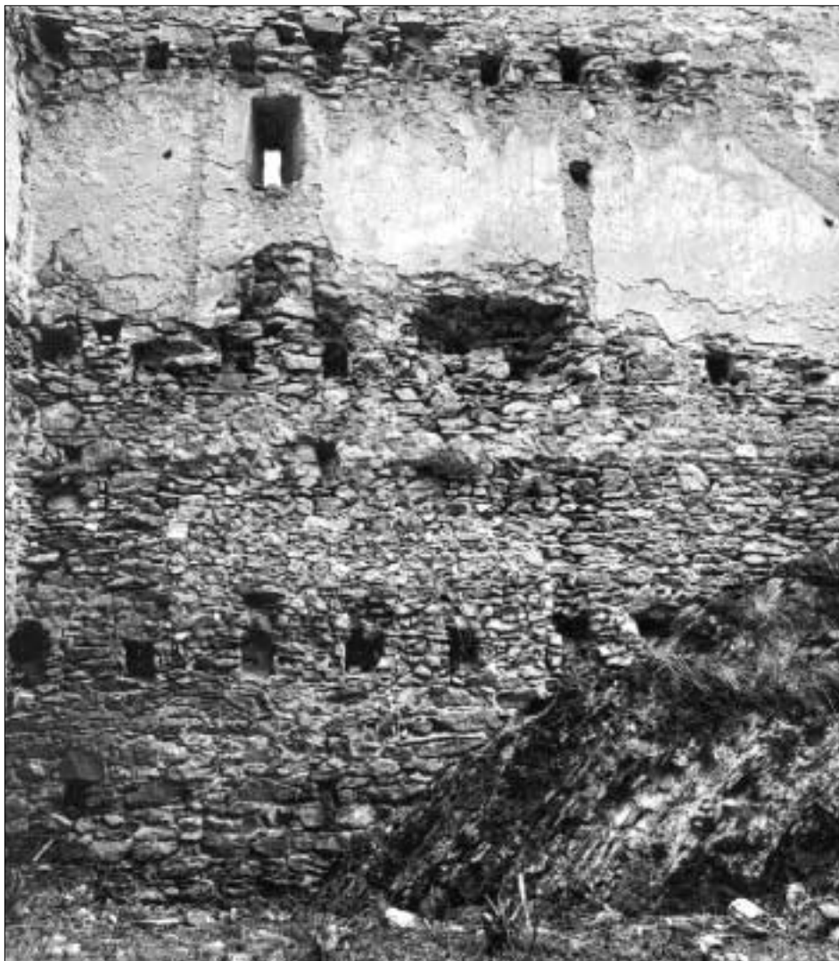
Obr. 33: Kašperk, horní hrad roku 1971, trosky tzv. purkrabství v pohledu do vnitřku od západu; vlevo otisk patrně lehké příčky a domnělého schodiště (foto archiv NPÚ ÚOP v Plzni, č. n. 36191).
