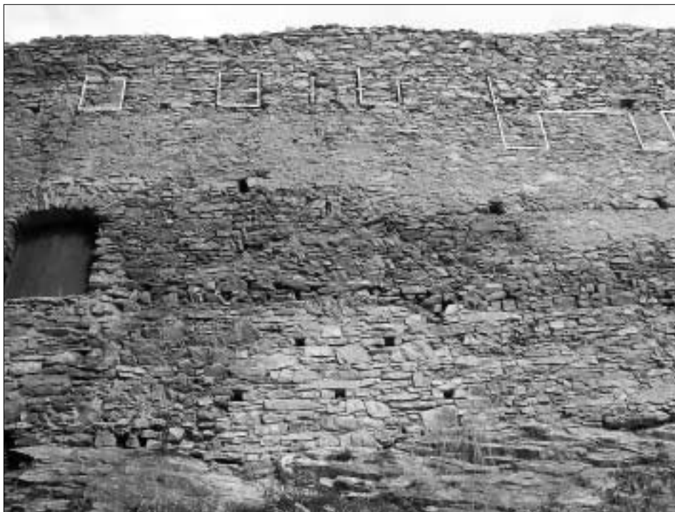
Obr. 35: Kašperk, dolní hrad, jižní hradba s brankou. Zvýrazněno cimbuří 1. stavební fáze. Dole vpravo velká novodobá oprava líce.
