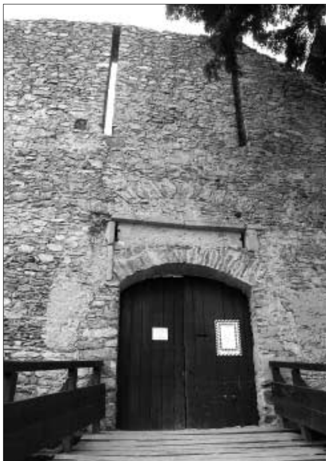
Obr. 36: Kašperk, dolní hrad, brána s pozůstatky stěžejkového mechanismu.
