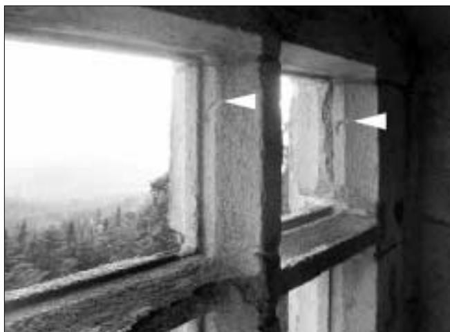
Obr. 8: Kašperk, hrad, jádro, východní věž, 4. podlaží jižního průčelí, ostění okna vložené dřevěné světnice, následně kaple, stopy po osazení výztuže okenní výplně (patrně vitrail).
