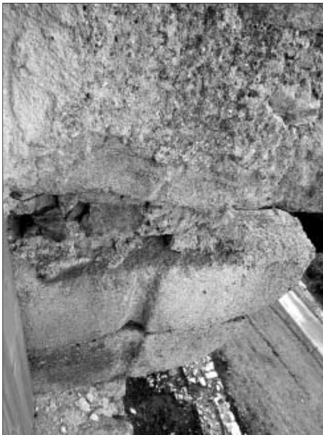
Obr. 11: Kašperk, hrad, jádro, západní věž, 3. podlaží severního průčelí, konzola prevetu se svislou drážkou pro dřevěnou stěnu pod sedátkem záchodu.
