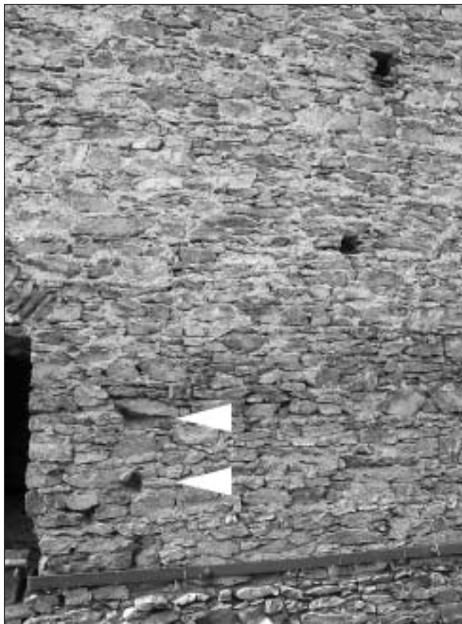
Obr. 12: Kašperk, hrad, jádro, východní věž, 1. podlaží východního průčelí, otvory v lici vedle bývalé stavební díry. Zvýrazněné dolní otvory mají protěžsky v sousední hradbě a ve dvou etapách v nich byla kotvena jakási dřeva (obširnější popis v textu).
