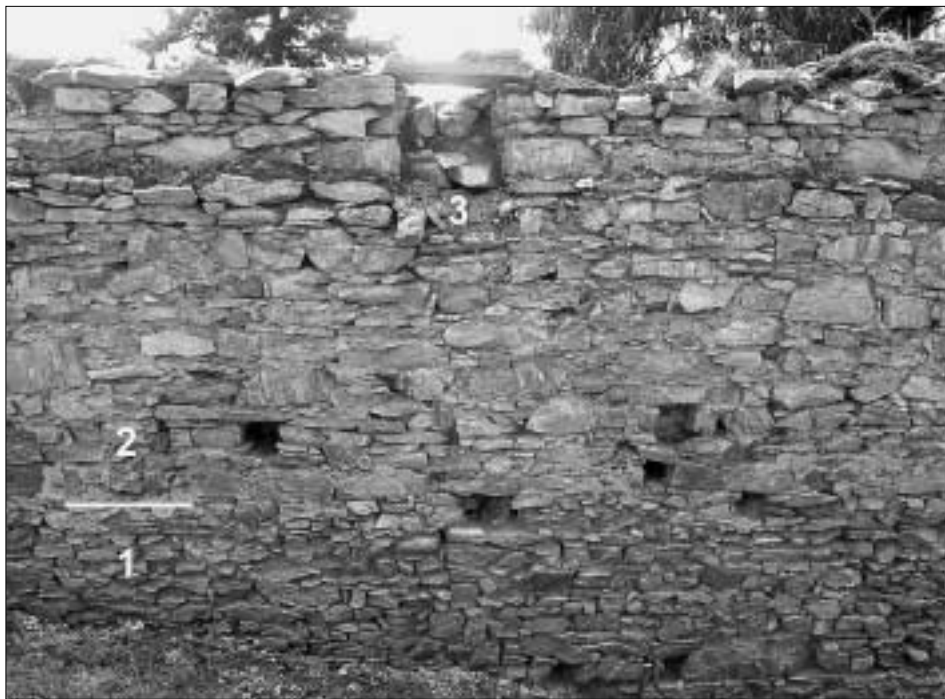
Obr. 23: Kašperk, horní hrad, jižní hradba, vnitřní líc. 1 – zdivo 1. fáze, 2 – pozdně gotické dozdnění nad úrovní bývalého ochozu (po konstrukci nového ochozu mělké trámové kapsy), 3 – pozdně gotická střílna dodatečně vyplněná zazdívkou.
