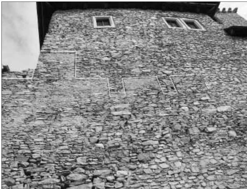
Obr. 25: Kašperk, horní hrad, jižní bok u napojení západního čela, vlevo pokračování do dolního hradu. Zvýrazněno cimbuří z 1. stavební fáze.
