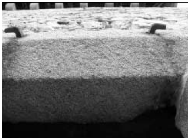
Obr. 9: Kašperk, hrad, jádro, východní věž, 4. podlaží severního průčelí, okno šířky, háčky pro zavěšení vyklápěcí okenice.
