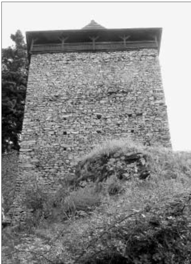
Obr. 38: Kašperk, dolní hrad, západní stavení od západu a středověké stavební pozůstatky před ním (patrný líc reliktu zdi).
