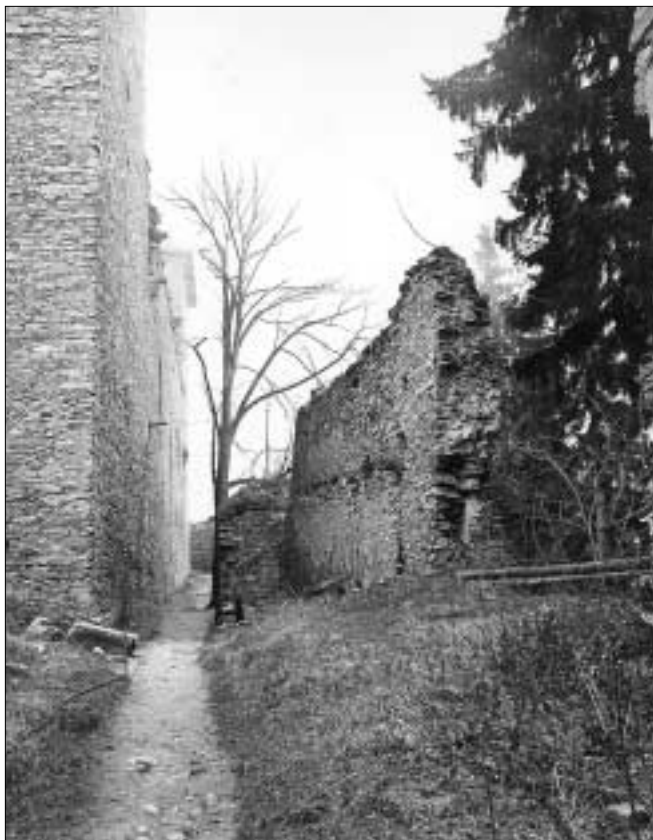
Obr. 29: Kašperk, horní hrad roku 1971, pohled od tzv. purkrabství k jádru (vlevo). Vlevo u západní věže kamenné díly okapního žlabu, vpravo v narušení patrný vývoj jižní hradby (foto archiv NPÚ ÚOP v Plzni, č. n. 36196).
