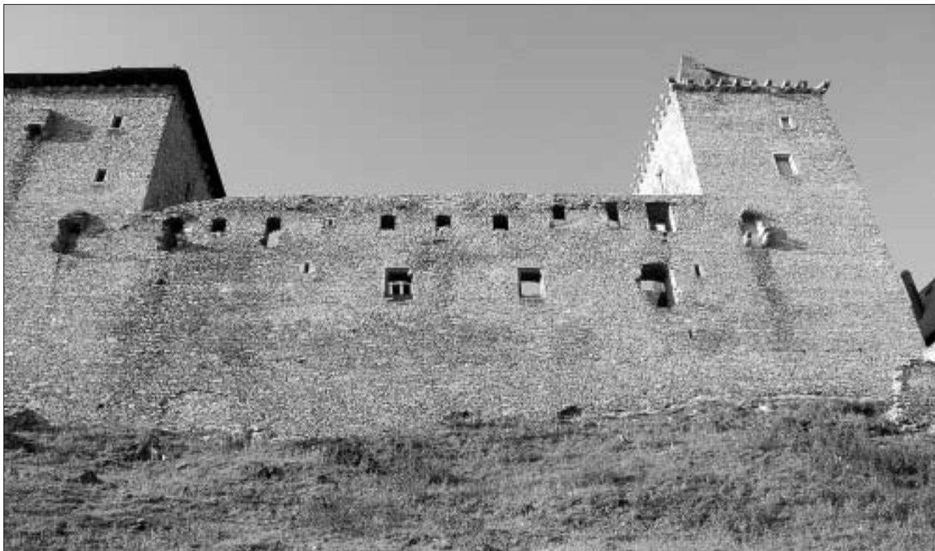
Obr. 4: Kašperk, hrad, severní bok jádra.
