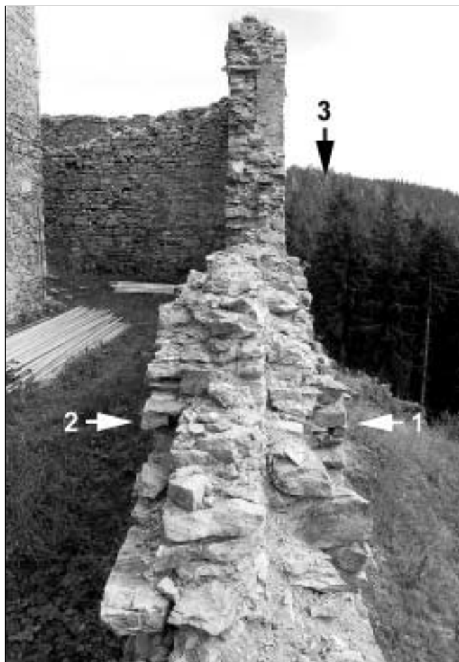
Obr. 22: Kašperk, horní hrad, jižní hradba. 1 – cimbuří z 1. stavební fáze, 2 – pozdně gotické zvýšení, 3 – poloha tzv. Pustého hrádku.
