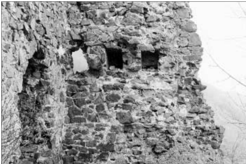
Obr. 15: Týřov, hrad. Věžový palác horního hradu, pohled na jihozápadní stěnu interiéru, detail. Srov. obr. 13/5 (foto V. Razím, 2002).
