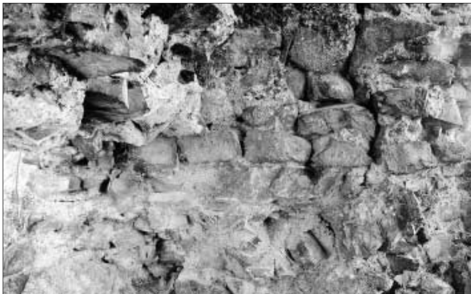
Obr. 16: Týřov, hrad. Věžový palác horního hradu, detail jihozápadní špalety většího z přízemních okenních otvorů jihovýchodní zdi. Líc zdiva zanikl, tvar a rozmístění kamenů nenasvědčují existenci dosud předpokládané desky sedátka (foto V. Razím, 2005).
