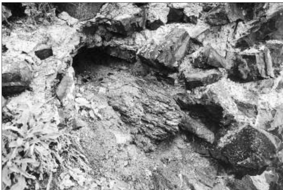
Obr. 11: Týřov, hrad. Válcová věž horního hradu, dochovaná část pravého dubového nosníku podesty před vstupem do 1. patra. Dendrochronologicky datováno po 1260 (foto V. Razím, 2004).
