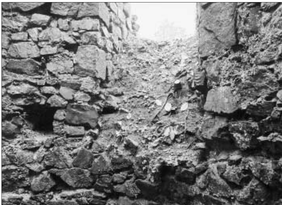
Obr. 10: Týřov, hrad. Válcová věž horního hradu, interiér na předělu přízemí a 1. patra. Uprostřed spodní část vstupu do 1. patra, vlevo jeden z otvorů zaniklých stropních trámů přízemí (foto V. Razím, 2004).
