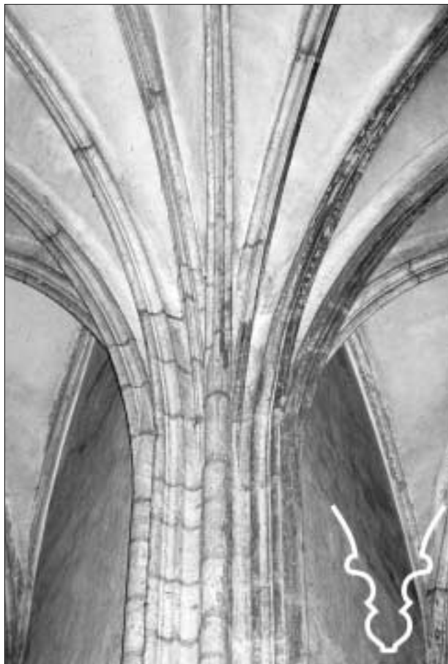
Obr. 5: Kutná Hora, chrám sv. Barbory. Detail výběhu žeber kleneb ze svazkové přípory mezi kaplemi v ose chrámu (upravená profilace žebra podle V. Mencla, foto autor, 2005).
