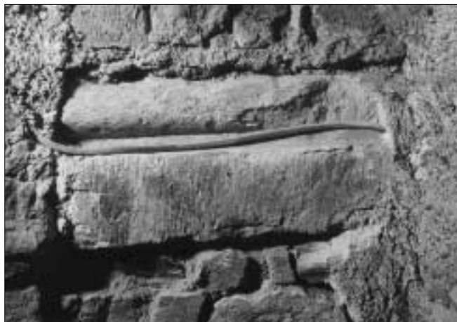
Obr. 2: Divišov, kostel sv. Bartoloměje. Díl záklenku na severní straně severního schodiště (foto J. Sommer, 2005).
