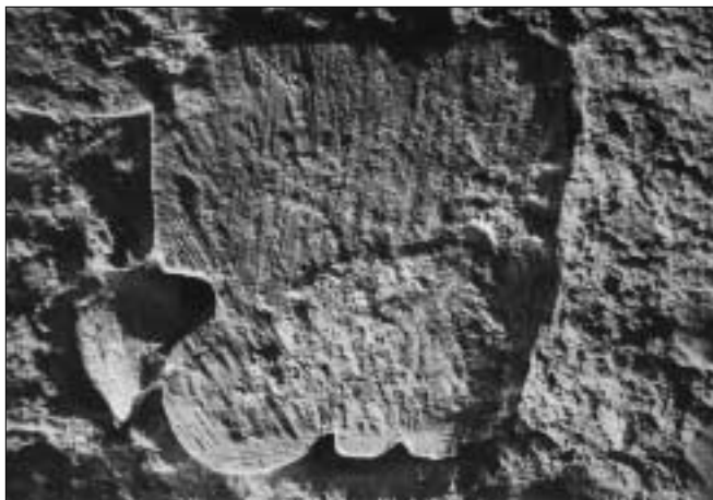
Obr. 3: Divišov, kostel sv. Bartoloměje. Ložná plocha dílu uloženého do zdi- va na severozápadní straně severního schodiště (foto J. Sommer, 2005).
