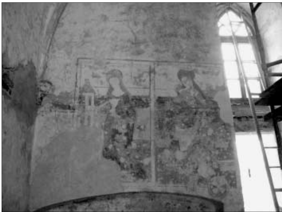
Obr. 2: Švihov, kostelík sv. Jana, freska sv. Barbory a Madony s dítětem nad postranním oltářem u jižní stěny lodi. Stav po vytmelení trhlin a dutin (foto L. Foster, únor 2005).
