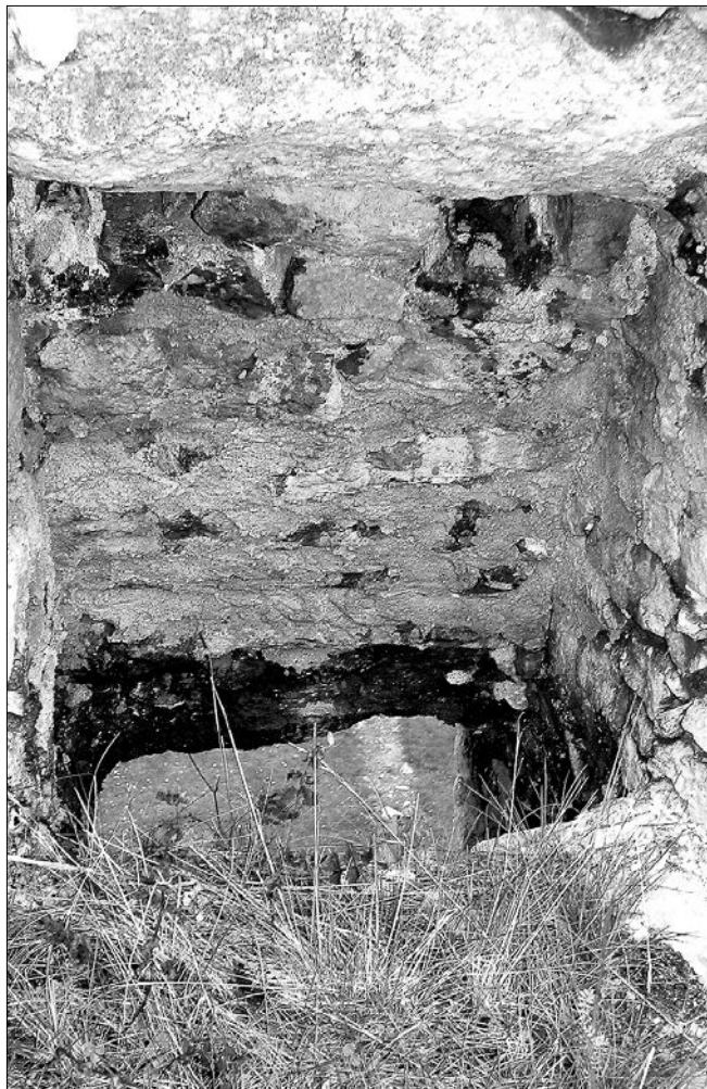
Obr. 23: Rabí, hrad, pohled shora do otvoru smolného nosu při Žižkově bráně (foto J. Varhaník, 2005).
