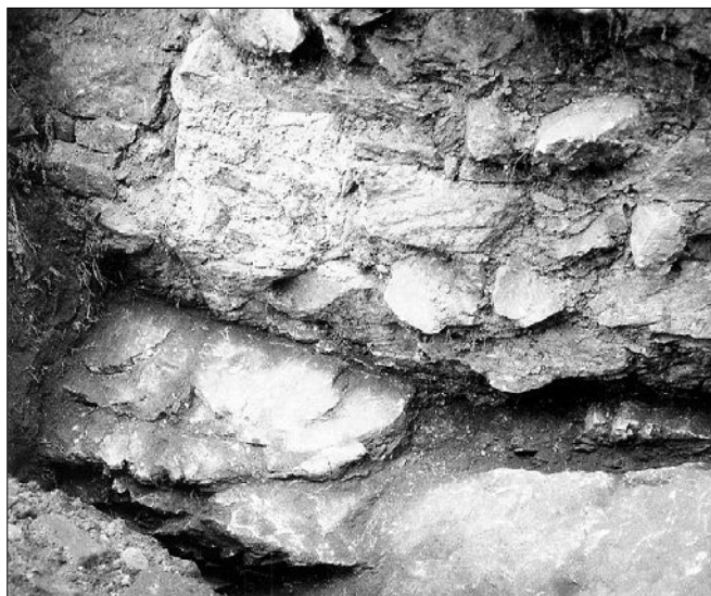
Obr. 57: Rabí, hrad, detailní záběr na základovou spáru zdi hradby u 3. brány založené na skalním podloží v sondě č. 34 (kreslila L. Krušinová).
