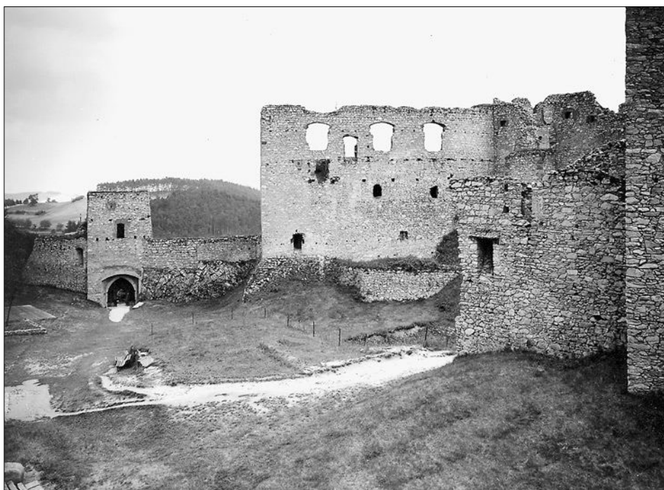
Obr. 26: Rábí, hrad, velké nádvoří od západu. Vpravo smolný nos krytý zděnou stříškou vystupující z úrovně líce zdiva v sousedství fragmentu Žižkovy brány, v pozadí vlevo ve spodní úrovni nádvořího průčelí severovýchodního křídla paláce obdobně utvářený, ale slepý útvar (snímek z fotoarchivu NPÚ ÚOP v Plzni, foto J. Gryc, 1973).
