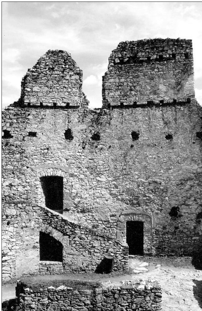
Obr. 21: Rabí, hrad, nádvorní průčelí válcové věže, tvořené ve spodní části starší hradbou. V omítce jsou patrné otisky svislých nosníků kryté pavlače v úrovni 3. podlaží (foto J. Varhaník, 2005).
