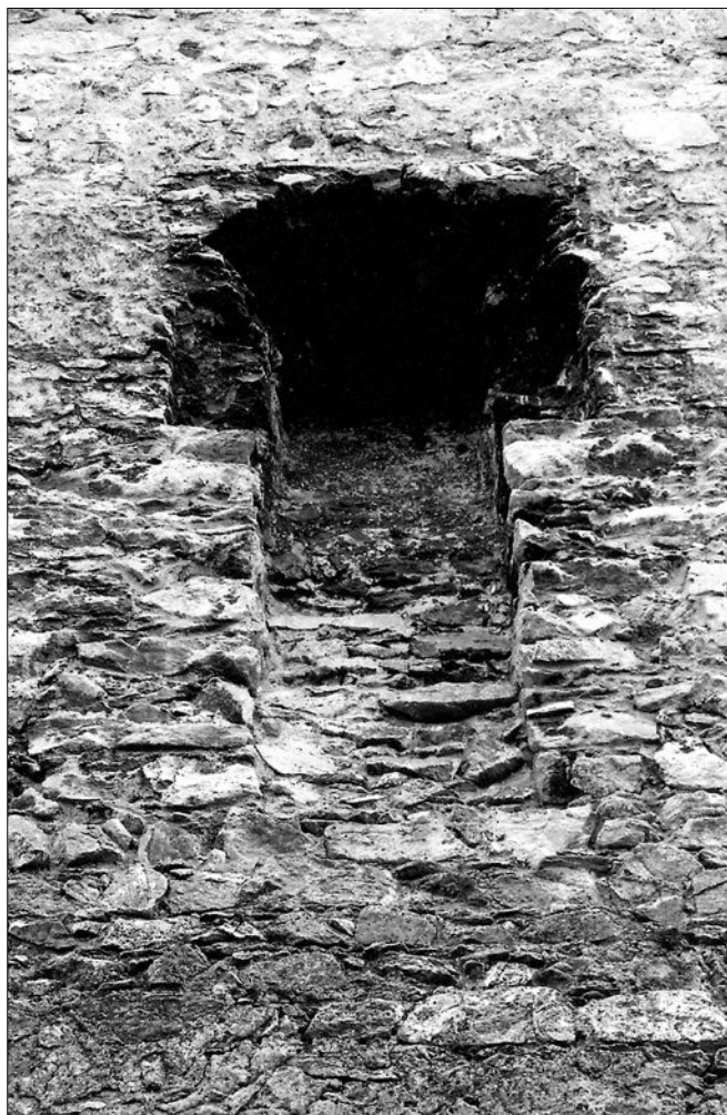
Obr. 24: Rábí, hrad, slepý smolný nos na severním průčelí severovýchodního paláce (foto J. Varhaník, 2005).
