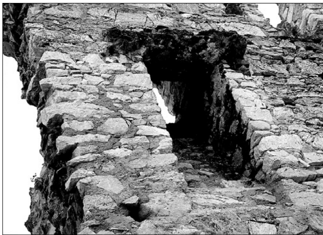
Obr. 22: Rabí, hrad, smolný nos při Žižkově bráně (foto J. Varhaník, 2005).
