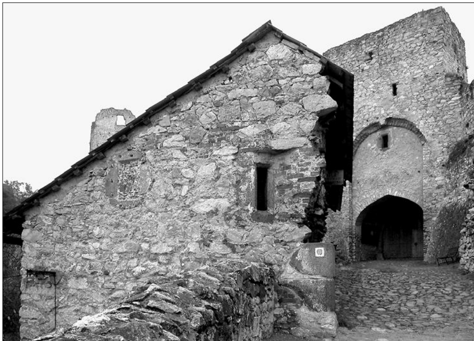
Obr. 10: Rabí, hrad, pozůstatek severovýchodního průčelí 2. brány se štěrbinovým okénkem a zazděným gotickým obdélným oknem (foto J. Varhaník, 2005).
