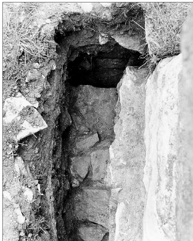
Obr. 52: Rabí, hrad, pohled shora na odhalenou korunu a vnější líc vnějšího základového pasu 2. brány v sondě č. 28. Vpravo předzáklad z cementu, kamenů a zlomků cihel (na obr. 51, profilu AC označen č. 2) pod dvěma žulovými články ostění, z nichž spodní je na obr. 51 označen č. 1 (foto L. Krušinová, 1985, č. neg. 171 827 v NPÚ ÚOP v Plzni).
