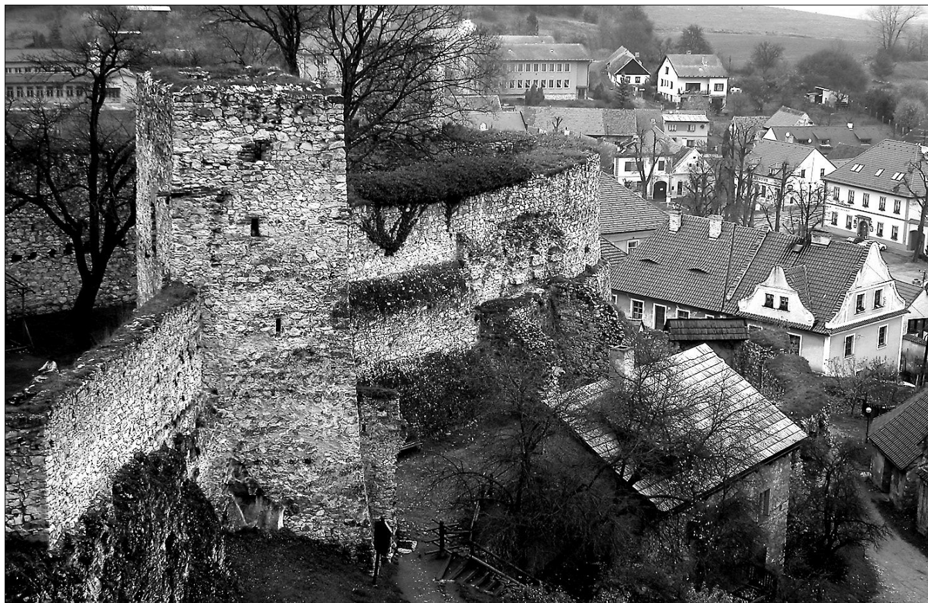
Obr. 65: Rabí, hrad, věž třetí brány a východní bašta od jihu. Vpravo domek čp. 54 s pozůstatky budovy 2. brány ve svém stavebním organismu (foto J. Varhaník, 2005).
