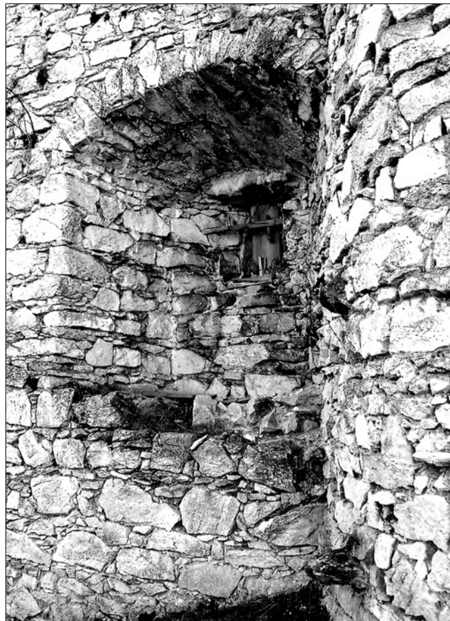
Obr. 30: Rabí, hrad, špaleta menší střelny při polygonální baště, napravo šmorce, nevyužitě při napojení kurtiny (foto J. Varhaník, 2004).
