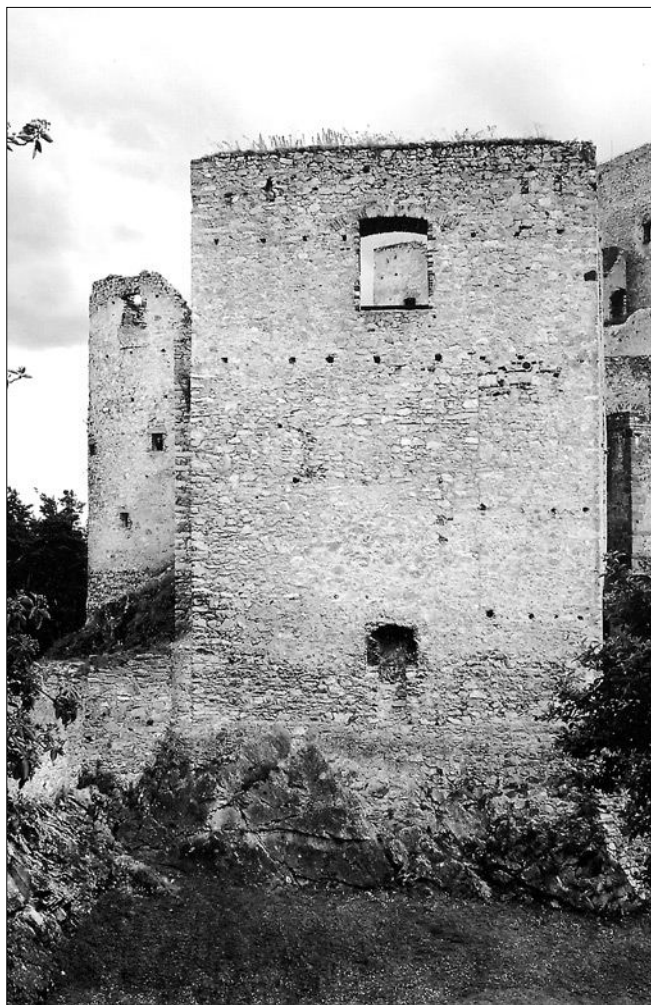
Obr. 25: Rábí, hrad, severní průčelí severovýchodního paláce se slepým smolným nosem v ose, vylámaným ve zdivu starší věže (foto J. Varhaník, 2005).
