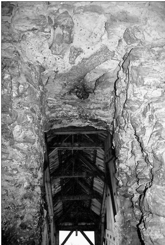
Obr. 27: Rabí, hrad, původně slepý smolný nos v západní zdi severovýchodního paláce, upravený na průchod pro návštěvníky (foto J. Varhaník, 2005).
