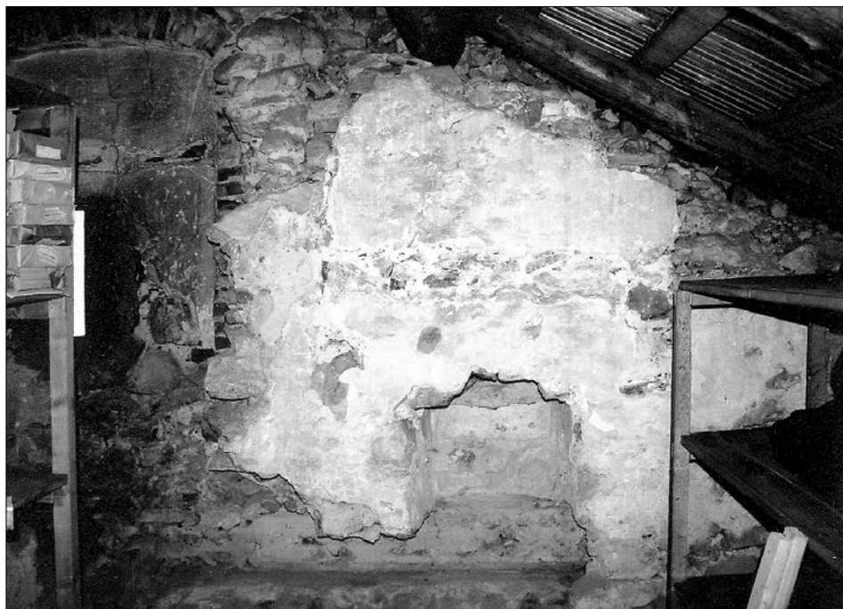
Obr. 12: Rabí, hrad, dochovaný úsek vnitřního líce průčelní zdi 2. brány se zazděným oknem a nikou vloženou na místě jeho špalety, dole negativ pouzdra závory (foto J. Varhaník 2005).
