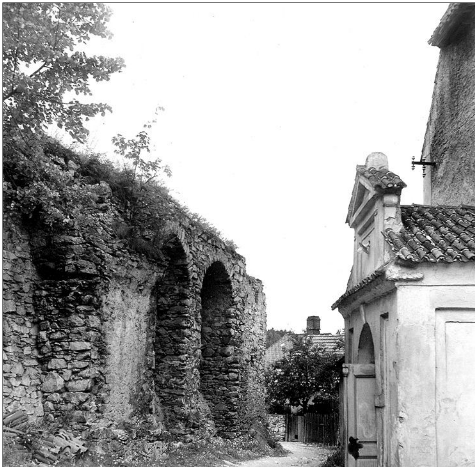
Obr. 6: Rabí, hrad, opěráky připojené k hradbě přihrádku od jihu. První z nich s omítkou na čelní stěně sloužil jako pilíř mostu, vedoucího do podkrovního kostela (snímek z fotoarchivu NPÚ ÚOP v Plzni, foto Tůma, 1963).
