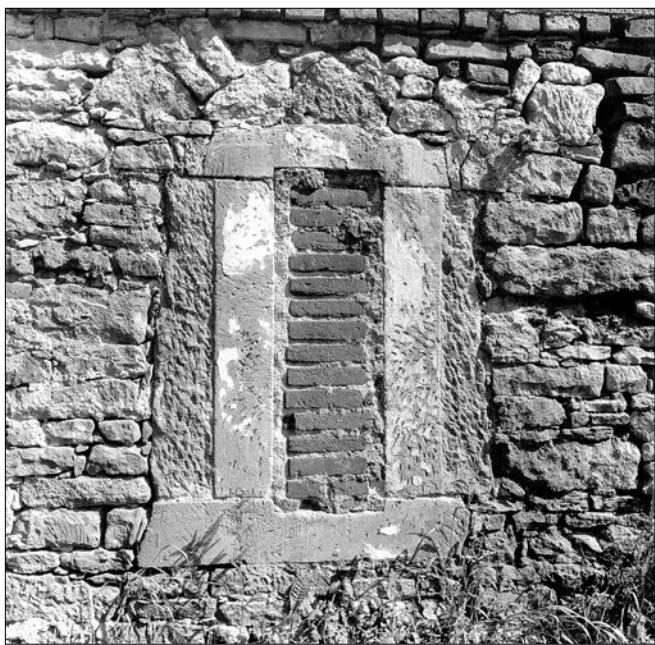
Obr. 33: Černíky, čp. 2. Detail zazděného okenního otvoru v jižním průčelí zadního dílu obytného domu. Srov. obr. 32 (foto P. Dostál, 1988).
