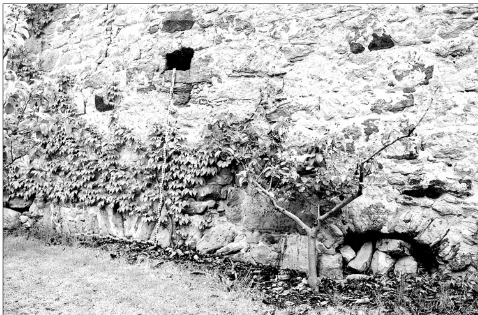
Obr. 30: Černíky, čp. 1. Severní část západního průčelí hospodářského objektu ve dvoře usedlosti. V bázi zdiva je patrný široký vynášecí pas a ústí větracího průduchu severního dílu sklepa (foto J. Veselý, 2005).
