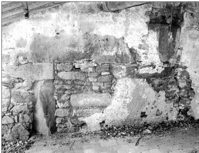
Obr. 24: Černůky, čp. 1. Severní část východního průčelí hospodářského objektu ve dvoře usedlosti. Do zazdívky portálu byl vsazen druhotně užitý tesaný kvádr (foto J. Šulc, 2004).
