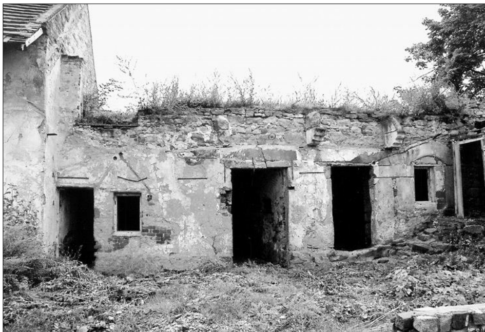
Obr. 19: Černíky, čp. 1. Dvorní průčelí hospodářského objektu ve dvoře usedlosti (foto J. Kypta, 2005).
