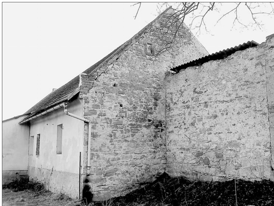
Obr. 17: Černíky, čp. 1. Pohled na západní průčelí obytného domu. Ve štítě je patrné ostění zaslepeného okénka, vytesané z jednoho bloku pískovce (foto J. Šulc, 2004).
