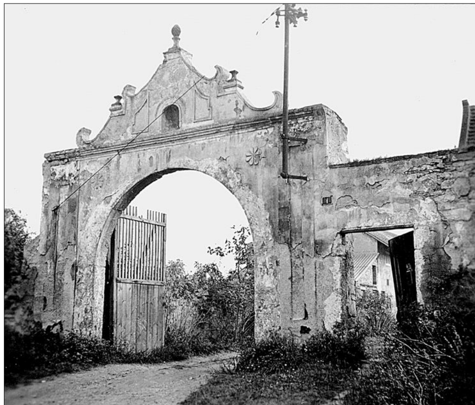
Obr. 14: Černíky, čp. 1. Pozdně gotická brána s dodatečným štítovým nástavcem. Na hraně ostění levého náběhu záklenku je dobře patrný okos (foto F. Sebek, 1969).
