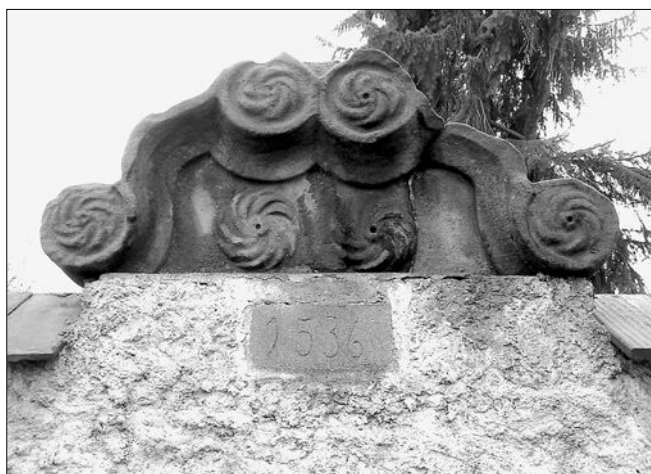
Obr. 8: Vykáň, čp. 5. Druhotně užitý fronton štítového nástavce brány, která původně prolamovala ohradní zeď zahrady (srov. obr. 3). Po tomto prvku je osazena destička s novodobě vyrytým vročením 1536 (foto J. Šulc, 2004).
