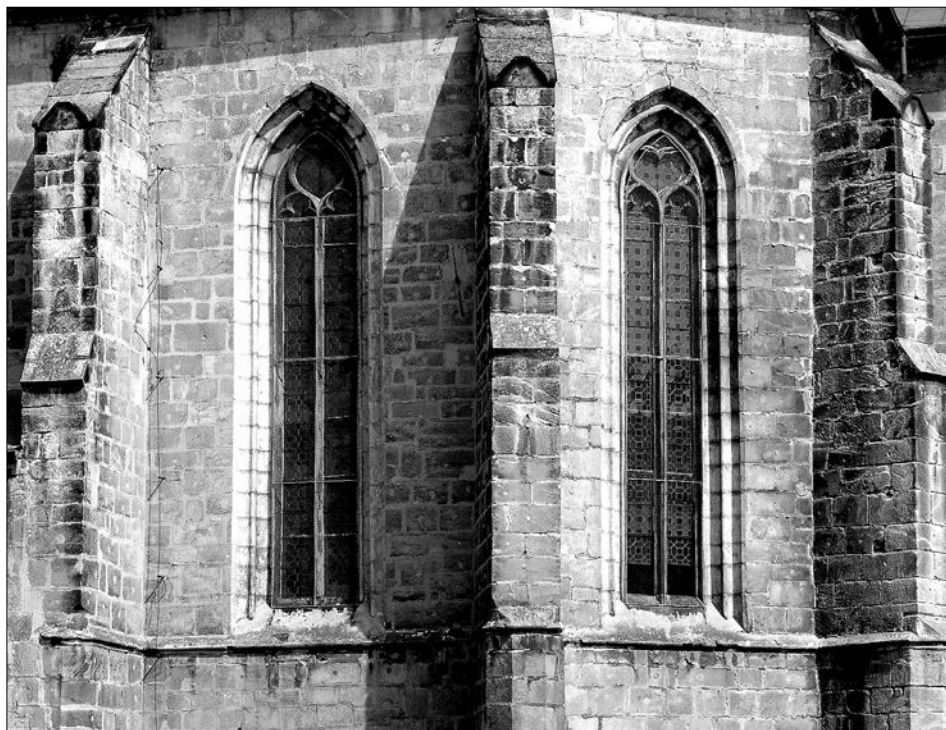
Obr. 11: Jičín, kostel sv. Ignáce (pův. sv. Jakuba), pohled na okna závěru jižní lodě (foto T. Rasl, 2004).
