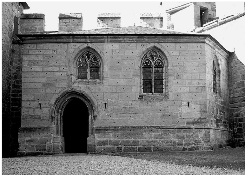
Obr. 22: Kost, hradní kaple, celkový pohled od jihu (foto P. Uličný, 2005).
