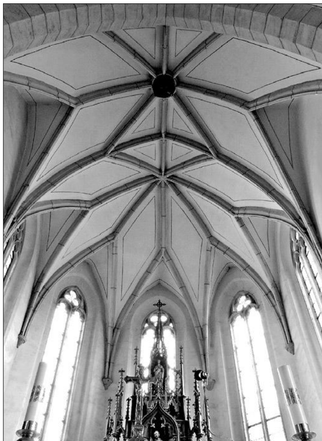
Obr. 18: Jičín, kostel sv. Ignáce (pův. sv. Jakuba), pohled na klenbu presbytáře. Podle projektu z posledního desetiletí 15. století do připravených výběhů vyklenul v roce 1436 Petr z Kolína (foto T. Rasl, 2004).
