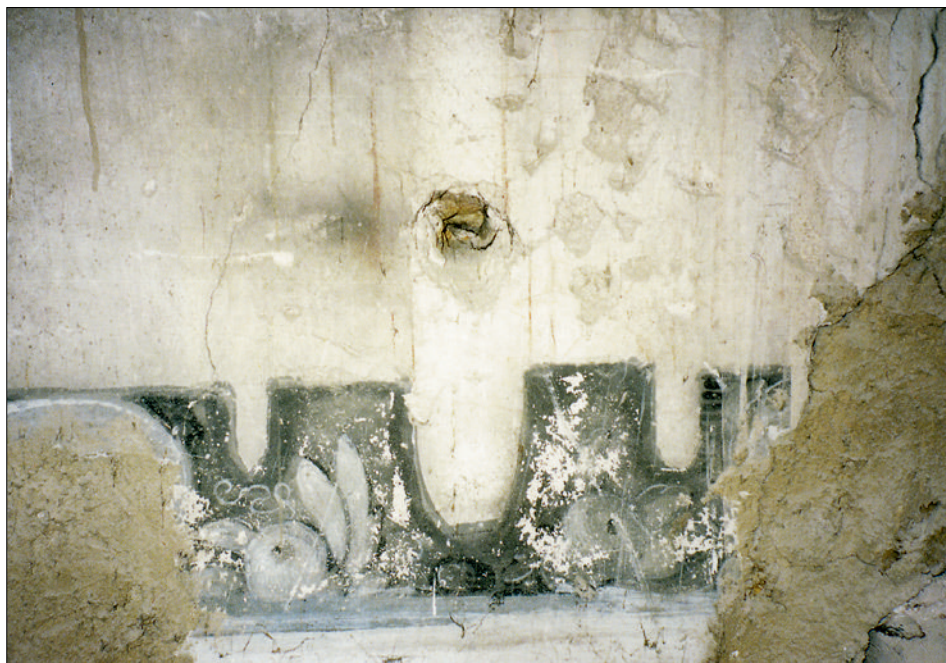
Obr. 10: Kostelec nad Černými lesy, zámek, nepřístupný prostor mezi prvním a druhým patrem západního křídla, motiv ovocného zátiší podstropní výmalby s vynechanou plochou pro předpokládanou konzolu stropního podhledu (foto autorka).
