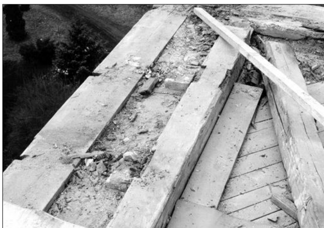
Obr. 9: Liblice, zámek, pohled na část horního líce vysazení římsy s pozednicí po částečném rozkrytí krovu. Mezi pozednicí a římsovým prknem jsou zbytky dvou sloupků atikové balustrády.
