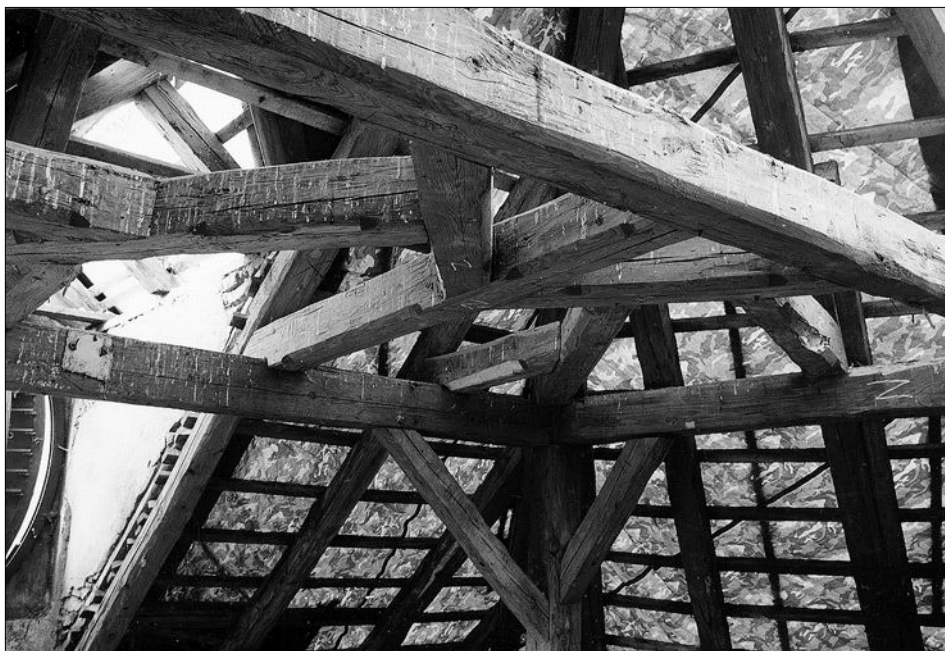
Obr. 5: Liblice, zámek, část krovové konstrukce nad jihozápadní částí zámku (všechny snímky autor, není-li uvedeno jinak).
