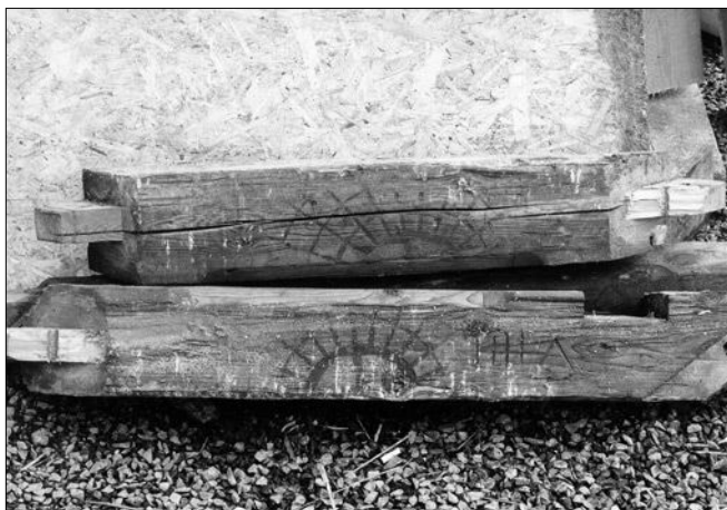
Obr. 8: Liblice, zámek, detail vyjmutých hambalkových výměn. Na bocích vyryto úhlové schéma rozvrhu krovové konstrukce v oblasti západní vykrojené části.
