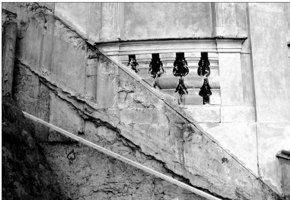
Obr. 7: Liblice, zámek, detail otisku starší a stávající střechy na západním boku oválné hmoty horního sálu. Dobře je patrná starší úprava parapetu okna a nasazení balustrády, která souvisí až s vyšší úrovní střechy.
