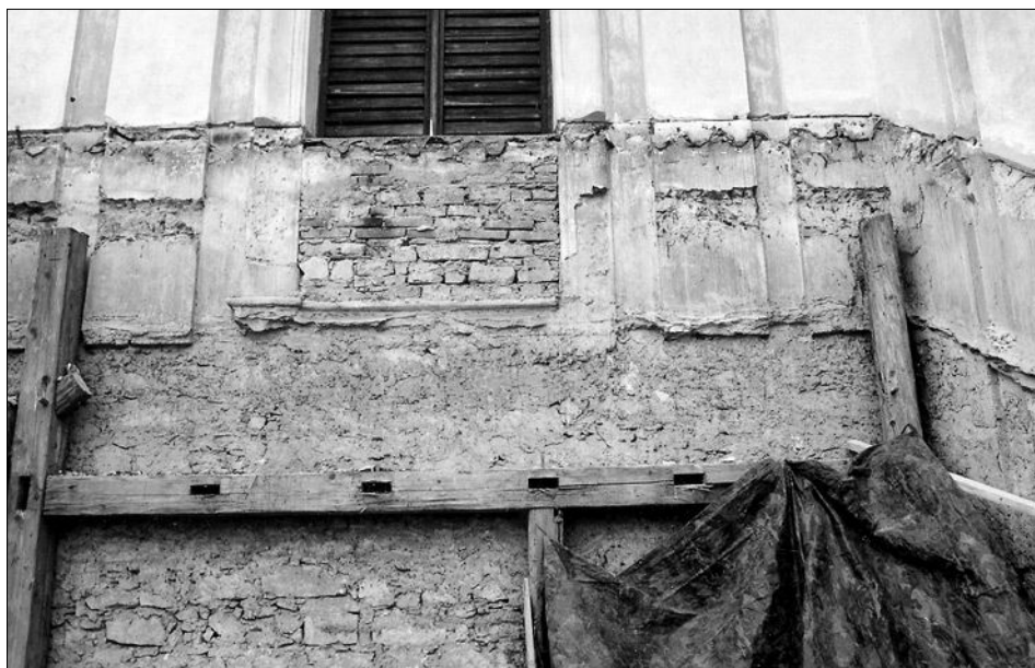
Obr. 6: Liblice, zámek, pohled na jižní stěnu komunikačního křídla po částečném rozebrání krovu. Dobře je viditelná úroveň nasazení stávající a starší střechy s lizénami a šambránou okna s parapetní římsou, opatřenými červeným nátěrem v mezilehlém pásu.
