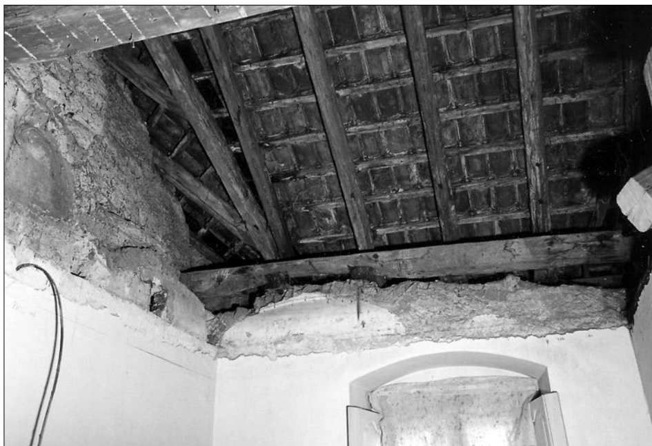
Obr. 11: Liblice, zámek, pohled na zbytky kleneb nad podestou a schodišťovými rameny výstupního schodiště do podstřeší, odstraněného v 70. letech 19. století.
