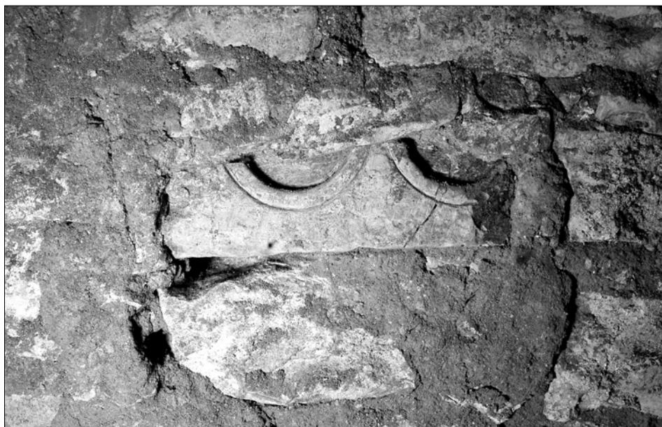
Obr. 3: SMP, dům čp. 234/I. Fragment ohořelého obloučkového vlysu, druhotně použitý v podezdívce jihovýchodní zdi sklepa (013).
