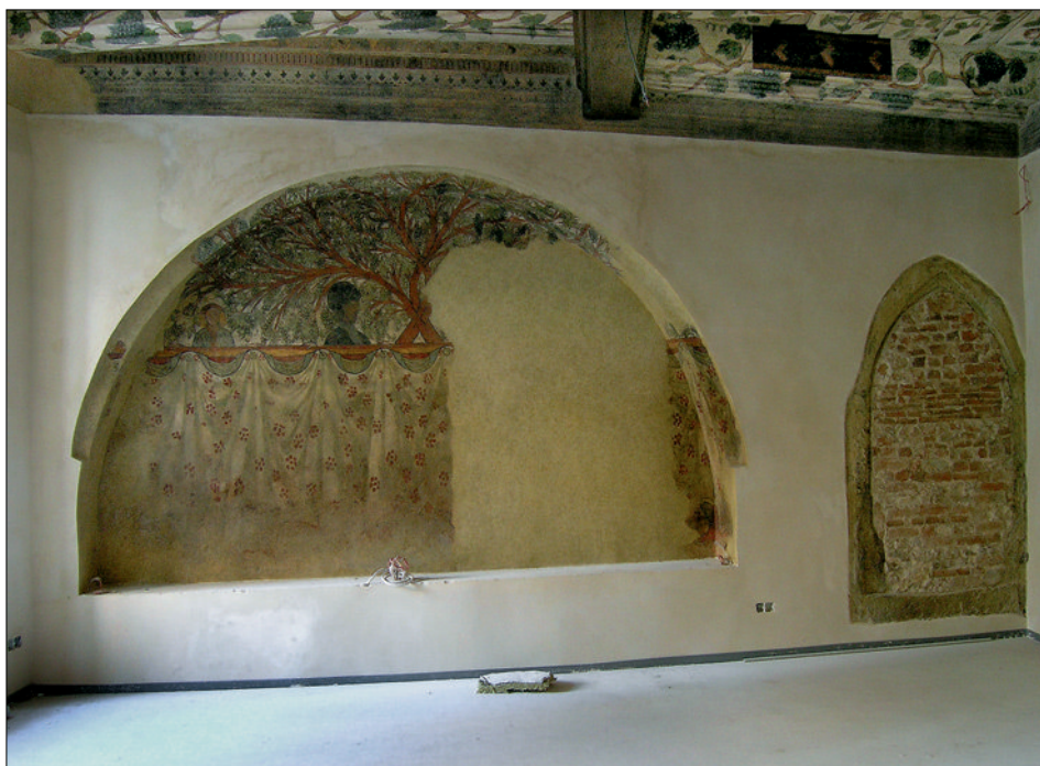
Obr. 23: SMP, dům čp. 234/I. Pohled na východní stěnu sálu, dnes místnosti (316). Stav po restaurování (akad. mal. K. Kubátová). Vlevo obnovená nika sedle z fáze gotika II s pozdně středověkou nástěnnou malbou, v pravé části porušenou barokním vstupem. Vpravo hrotitý opukový portál z fáze gotika II do nárožní obytné „komory“ (314).
