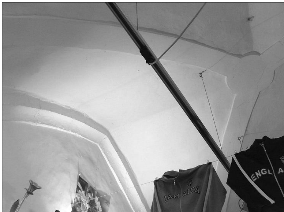
Obr. 21: SMP, dům čp. 234/I. Pohled na část obkročné klenby v prostoru (115) v přízemí domu, vložené ve fázi gotika III. Profilace žebér byla odsekána v 19. století.
