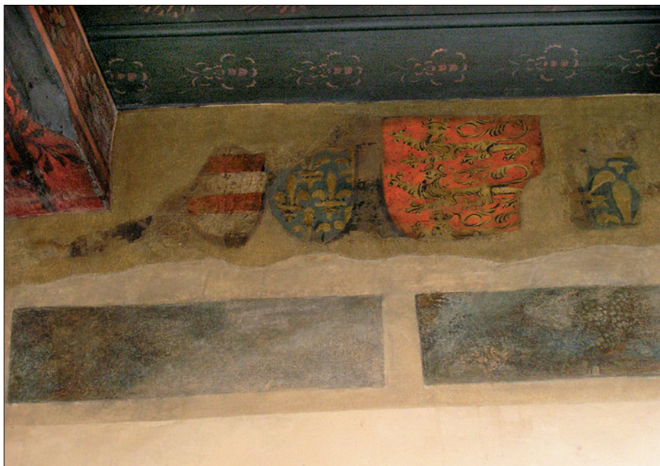
Obr. 22: SMP, dům čp. 234/I. Pohled na čelní severovýchodní stěnu sálu, dnes v místnosti (317). Mezi trámy gotického stropu se nachází torzo znakové galerie panovnických erbů. Mladší horizont výmalby představují obdélná pole (na snímku dole) s fantastickými krajinami, které pocházejí z přestavby domu kolem roku 1600. Pruh nad obdélníky polí je negativem bývalé přední renesanční dubové kleštiny.
