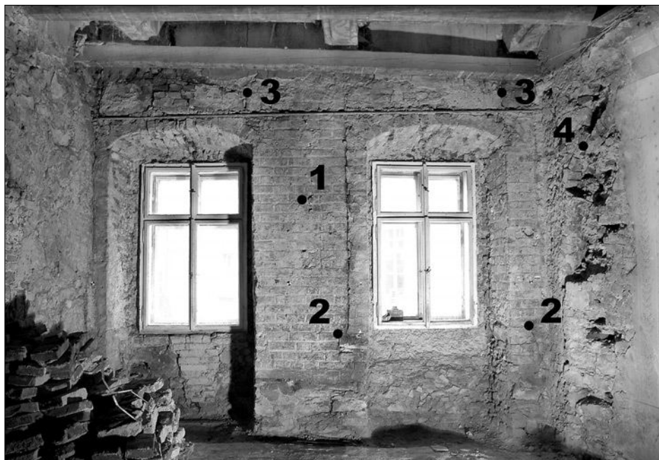
Obr. 10: SMP, dům čp. 234/I. Bývalý sál v 1. patře, severovýchodní stěna dnešní místnosti (316), v čele domu. 1 – meziokenní pilíř ze spárovaného zdiva fáze gotika II; 2 – fragmenty opukových sedátek v nikách oken; 3 – pátý segmentových záklenků gotických nik; 4 – vyžlabená hrana cihelného oblouku sedile východní stěny sálu.
