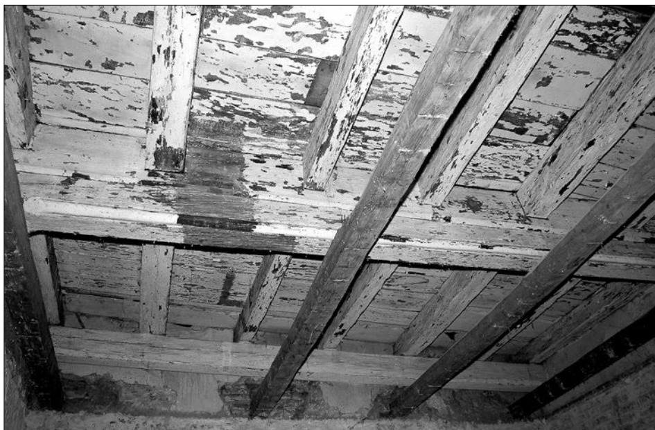
Obr. 16: SMP, dům čp. 234/I. Pohled na gotický strop v místnosti (321), datovaný k roku 1335. Spodní trámy náležejí pohledu ze 20. let 19. století.
