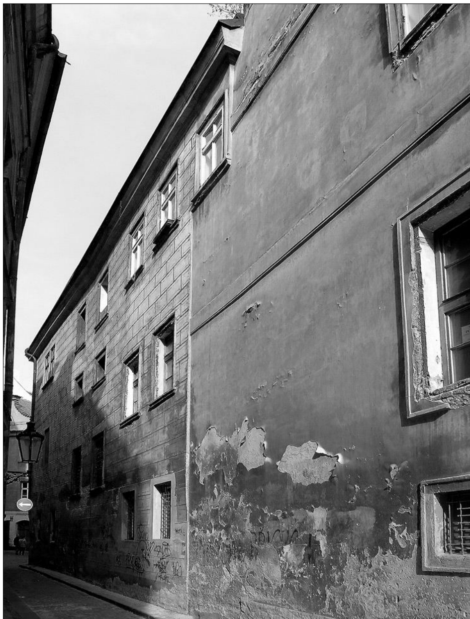
Obr. 27: SMP, dům čp. 234/I. Průhled Jalovcovou ulicí směrem k severu. Zjevný kontrast mezi středověkým domem a raně barokním západním křídlem dominikánského kláštera u sv. Jiljí.
