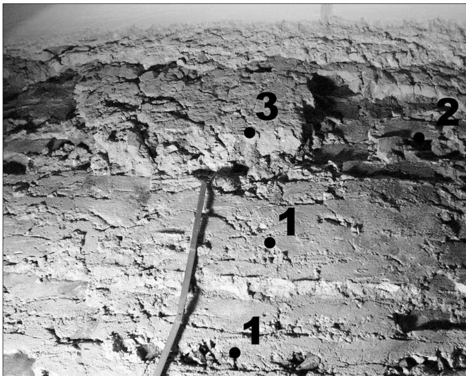
Obr. 12: SMP, dům čp. 234/I. Bývalá světnice v 1. patře, dnes severní stěna místnosti (305). Detail otisků výdřevy z fáze gotika II v horní části stěny. 1 – zřetelné otisky fošen výdřevy; 2 – otisk přízedního průvlaku; 3 – zbytek mohutné vrstvy renesanční jádrové omítky, nanesený přes otisky po výdřevě při přestavbě kolem roku 1600.
