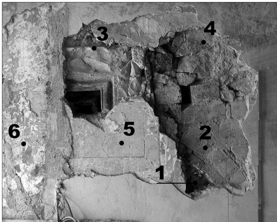
Obr. 20: SMP, dům čp. 234/I. Detail nálezové situace na jižní dvorní stěně 1. patra, dnes v interiéru schodišťové přístavby z roku 2005. 1 – oblouk vpadlého pole z vyžlabených spárovaných tvarovek z fáze gotika II; 2 – doprovodný oblouk z cihel kladených naplocho; 3 – opukové ostění okna z fáze gotika III, s odsekanou římsou; 4 – přezděné zdivo při osazování opukového ostění (gotika III), s druhotným použitím několika starších cihel; 5 – renesanční sgrafito; 6 – omítka barokní opravy s barokními a klasicistními nátery; na rozhraní se sondou byl povrch narušen zasekáním elektroinstalace.
