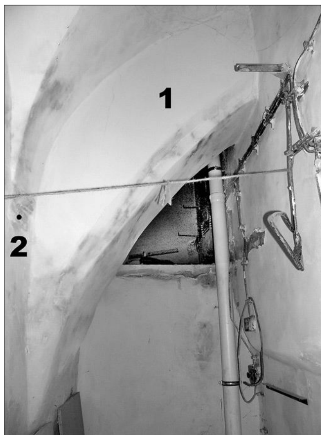
Obr. 6: SMP, dům čp. 234/I. Pas v průjezdu. 1 – pas z gotických cihelných tvarovek, na hraně vyžlabených (fáze gotika II); 2 – profilovaná pateční římsa druhotně přiložená renesanční klenby s výsečemi.
