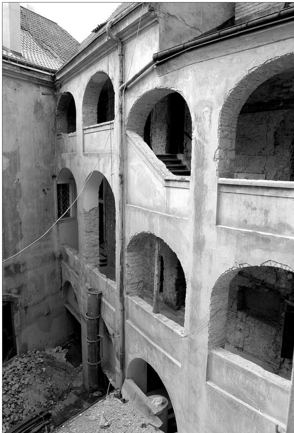
Obr. 29: SMP, dům čp. 234/I. Dvorní průčelí západního křídla. Dvě odlišné úrovně klasicistních pavlačí reagují na odlišnou podlažnost raně barokního křídla (vlevo) a středověkého domu (vpravo).
