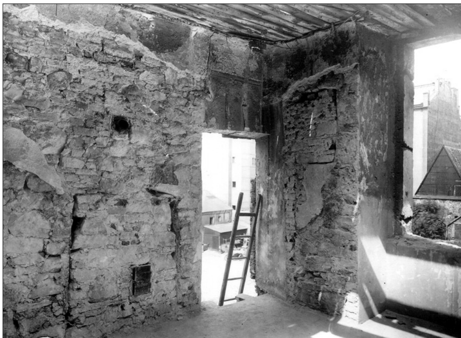
Obr. 31: SMP, věž za čp. 310-I. Interiér 2. patra s pohledem k severovýchodu, snímek z roku 1936 (srov. pozn. 34). Mezi novodobými otvory jedna ze zazděných střel východní strany.
