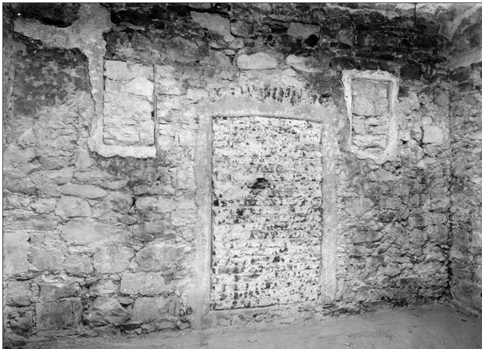
Obr. 29: SMP, věž za čp. 310-I. Interiér 2. patra s pohledem na jižní stěnu, snímek z roku 1936 (srov. pozn. 34). Uprostřed novodobý vstup, po jeho stranách zazděné niky střelů.
