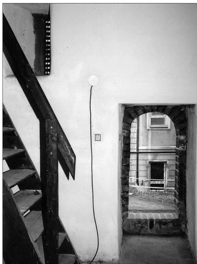
Obr. 39: SMP, věž za čp. 310-I. Interiér 1. patra s pohledem na západní stěnu, vpravo vstup, vlevo nahoře střelna (srov. obr. 27; foto V. Razím, 2003).
