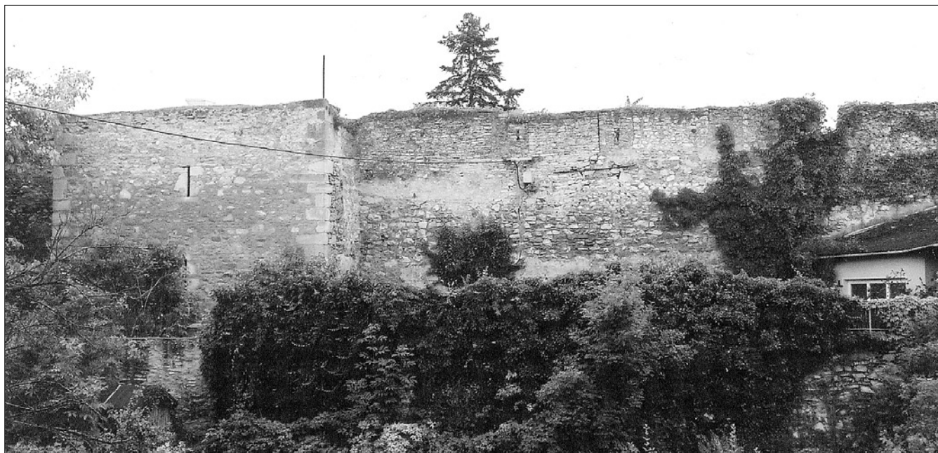
Obr. 49: Bruck a. d. Leitha (Dolní Rakousko), úsek hradební zdi s hranolovou věží, v jejímž hlavním průčelí se uplatňují šterbinové střílny (foto V. Razím, 2003).
