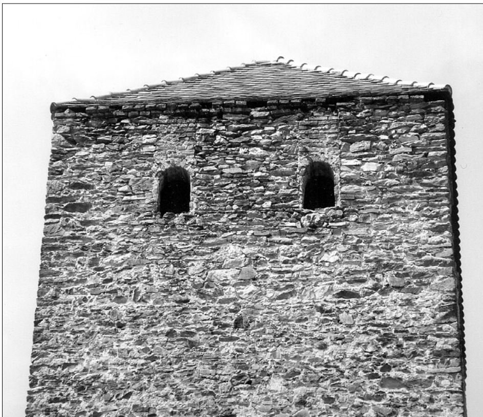
Obr. 45: Cheb, tzv. Teuflova věž na jižní straně města, detail horní části s vysokými prolukami, do nichž byly vloženy cihelné zazdívkys okénky (foto V. Razím, 2003).
