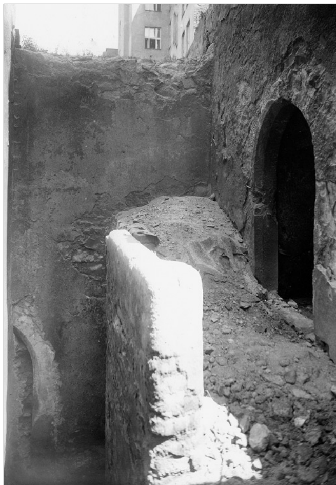
Obr. 26: SMP, věž za čp. 310-I. Detail dolní části severního průčelí, snímek z roku 1936 (srov. pozn. 34). Vpravo gotický portál vstupu do přízemí věže. Vlevo dole vstup do sklepa domu, před nímž schodiště odbočovalo doprava ke vstupu do suterénu věže.
