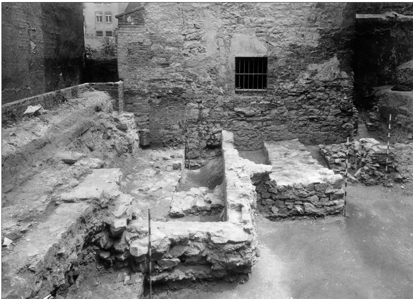
Obr. 20: SMP, věž za čp. 310-I. Dolní část západního průčelí, snímek z roku 1936 (srov. pozn. 34). Zřetelná je struktura zdiva, odbouraná hradba a její dochovaná spodní část s horní plochou základového stupně, předzáklad věže.
