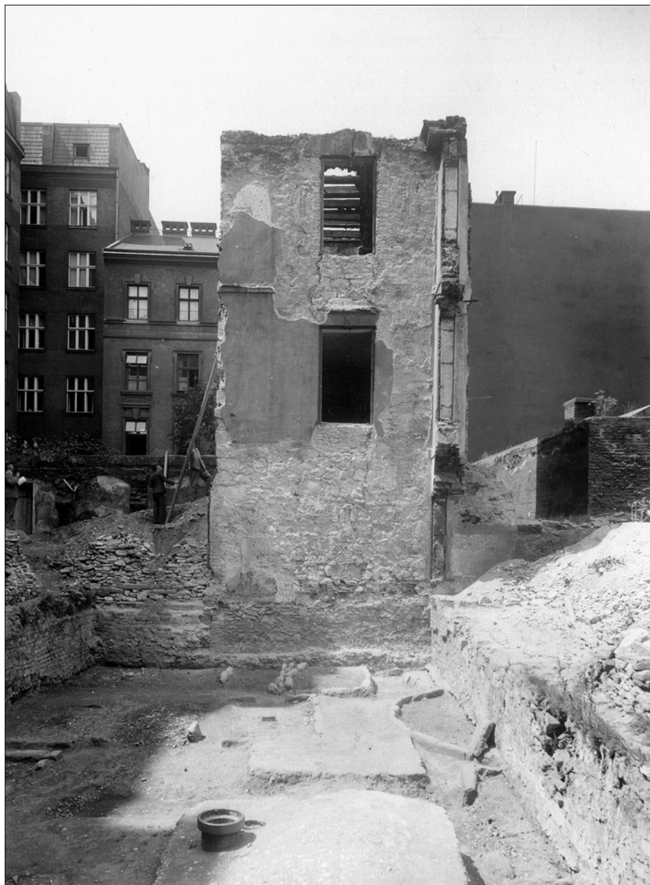
Obr. 24: SMP, věž za čp. 310-I. Celkový pohled na východní průčelí, snímek z roku 1936 (srov. pozn. 34). Vpravo v popředí zbytek hlavní hradby s patrným základovým stupněm, v parkánu archeologický výzkum pohřebiště. V dolní části průčelí věže drobná zazděná střílna, dole předzáklad, po stranách horního novodobého okna dvě zazděné šterbinové střílny.
