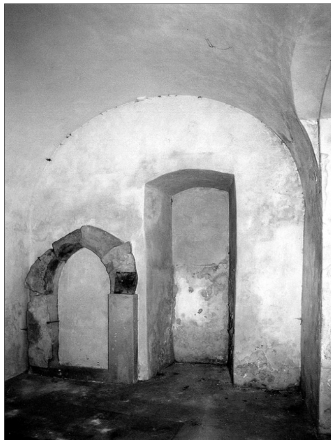
Obr. 38: SMP, věž za čp. 310-I. Interiér přízemí s pohledem na jižní stěnu (foto V. Razím, 2003).
