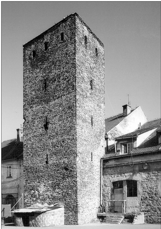
Obr. 44: Cheb, tzv. Teuflova věž na jižní straně města, celkový pohled z parkánu (foto V. Razím, 2003).
