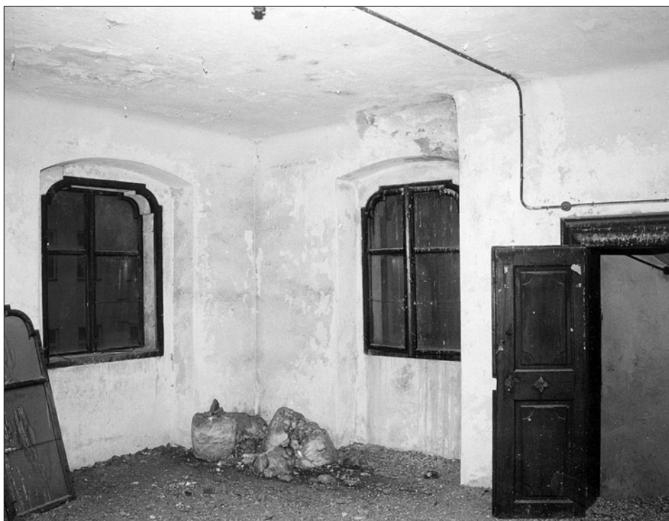
Obr. 15: SMP, věž za čp. 314-I. Detail barokního interiéru 4. patra (foto V. Razím, 2000).
