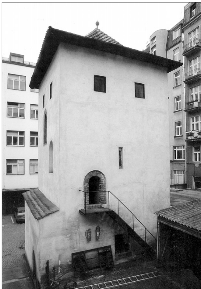
Obr. 35: SMP, věž za čp. 310-I. Celkový pohled od západu (srov. obr. 19; foto V. Razím, 2003).
