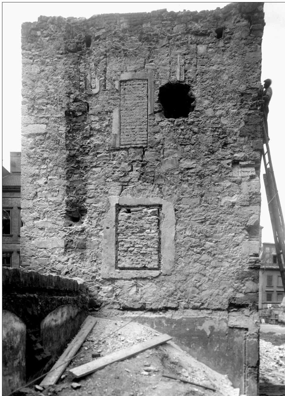
Obr. 22: SMP, věž za čp. 310-I. Horní část jižního průčelí, snímek z roku 1936 (srov. pozn. 34). Na ose dodatečné okno a vstup, nahoře zazděné otvory (patrně proluky cimbuří s vloženými šterbinovými střelnami). Kvádrová armatura obou nároží ve vrchní části chybí.
