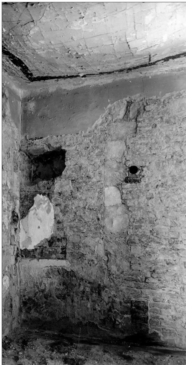
Obr. 28: SMP, věž za čp. 310-I. Interiér 1. patra s pohledem k severozápadu, snímek z roku 1936 (srov. pozn. 34). Uprostřed zazděná nika vstupu od severu se svíslou řadou opukových kvádrů na pravé hraně (srov. obr. 27).
