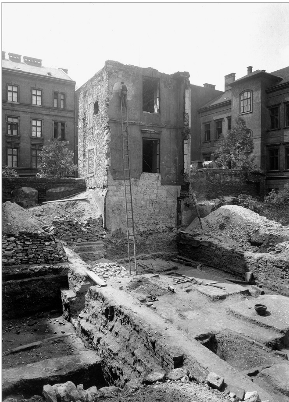
Obr. 23: SMP, věž za čp. 310-I. Celkový pohled od jihovýchodu, snímek z roku 1936 (srov. pozn. 34). V dolní části východního průčelí drobná zazděná střílna, vpravo od věže vnější líc dochované části hlavní hradby.
