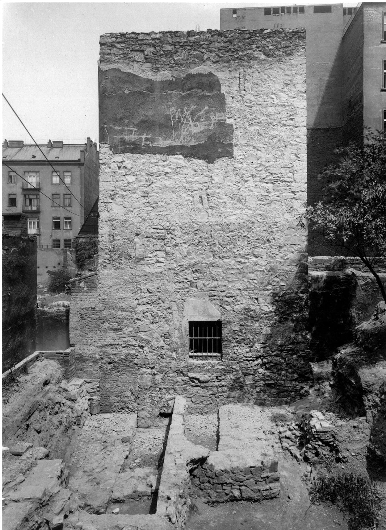
Obr. 19: SMP, věž za čp. 310-I. Celkový pohled na západní průčelí, snímek z roku 1936 (srov. pozn. 34). Zřetelný je zazděný vchod do 1. patra, střílna 1. patra a pravá střílna 2. patra.
