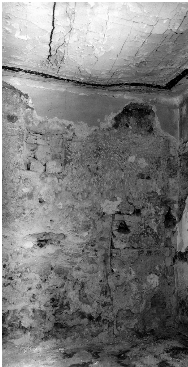
Obr. 27: SMP, věž za čp. 310-I. Interiér 1. patra s pohledem k severozápadu, snímek z roku 1936 (srov. pozn. 34). Vpravo zazděná nika vchodu od západu, vlevo nahoře zazděná nika střílny.
