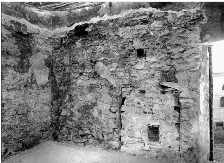
Obr. 30: SMP, věž za čp. 310-I. Interiér 2. patra s pohledem k severozápadu, snímek z roku 1936 (srov. pozn. 34). Uprostřed zazděná nika druhotného vstupu od severu.
