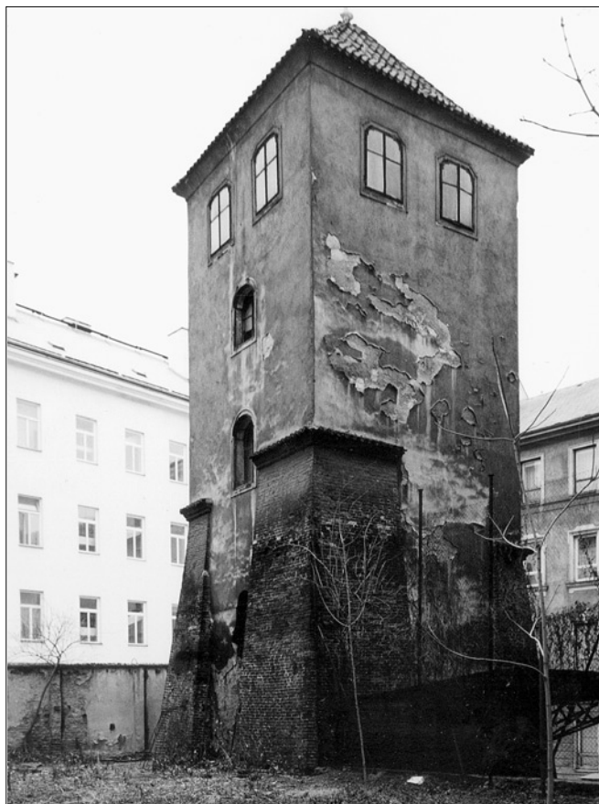
Obr. 13: SMP, věž za čp. 314-I. Celkový pohled od jihovýchodu (foto V. Razím, 2000).
