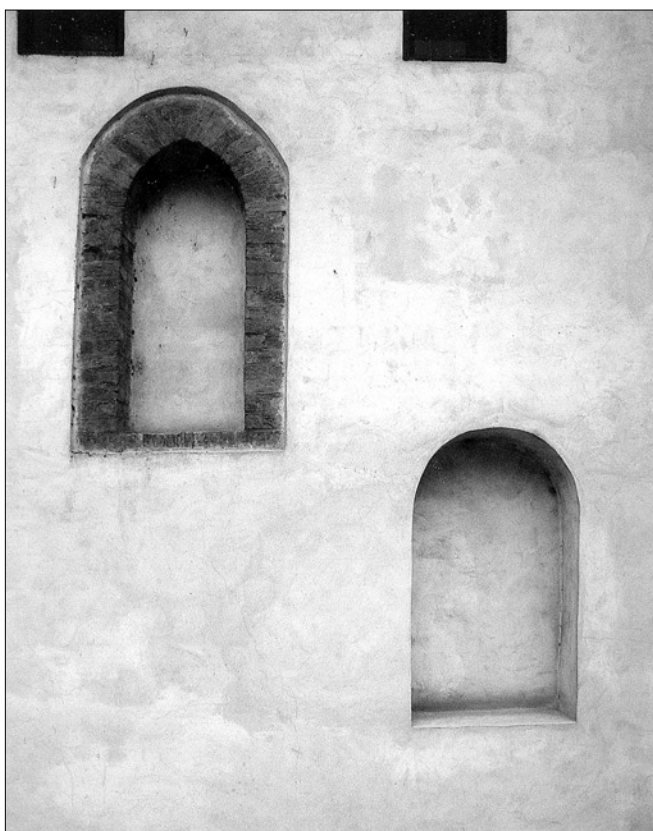
Obr. 34: SMP, věž za čp. 310-I. Detail severního průčelí se dvěma portálky (foto V. Razím, 2003).
