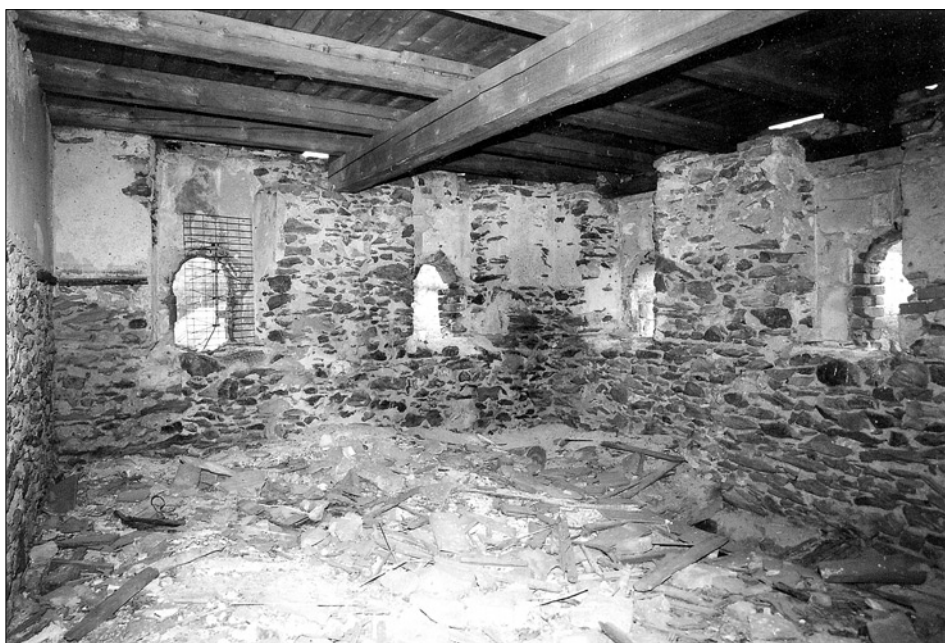
Obr. 47: Cheb, tzv. Teuflova věž na jižní straně města, detail interiéru horního patra s vysokými prolukami, do nichž byly vloženy cihelné zazdívkky s okénky – srov. obr. 45 (foto V. Razím, 2003).
