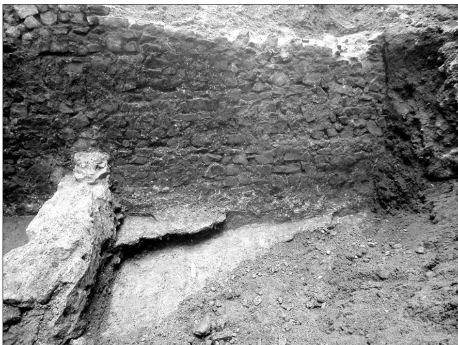
Obr. 6: SMP, detail vyzdívky vnitřní stěny příkopu na parcele domu čp. 313/I na Národní třídě s vylitými maltovými úrovněmi dna příkopu a částí dodatečně vloženého sklípku. Pohled od jihu (foto J. Hlavatý).
