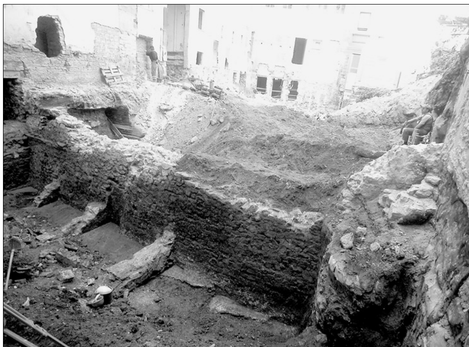
Obr. 4: SMP, odkrytý průběh vyzdívky vnitřní stěny hradebního příkopu na parcele domu čp. 313/I na Národní třídě. Pohled od jihovýchodu.
