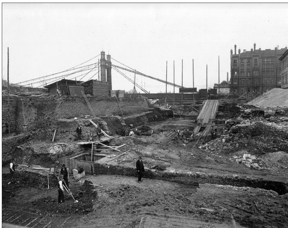
Obr. 1: Staré Město pražské (dále SMP), výkopy pro stavbu Ministerstva obchodu čp. 1039/I s odkrytými pozůstatky opevnění. Celkový pohled k Vltavě od jihozápadu, 1928 (ÚDU AV ČR, DSF, W-A-151/5-206).
