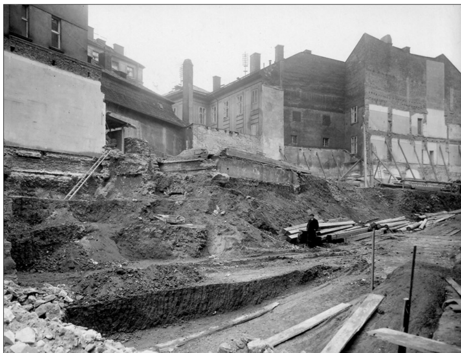
Obr. 19: SMP, výkopy pro stavbu pojišťovny Assicurazioni Generali v ulici Na Příkopě čp. 988/I s odkrytými pozůstatky opevnění. Celkový pohled k severozápadu. V popředí prostor příkopu, ve středu parkán a fragment hlavní hradební zdi. V pozadí bývalá Mincovna čp. 587/I, 1936 (ÚDU AV ČR, DSF, W-A-151/5-67).
