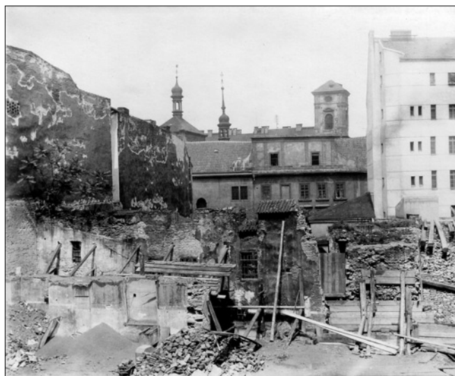
Obr. 23: SMP, úpravy pro stavbu policejního ředitelství v Bartolomějské ulici čp. 310/I s odkrytými pozůstatky opevnění. Pohled na vnější stranu hlavní hradební hradby za areálem bývalého čp. 346/I. V pozadí kostel sv. Bartoloměje (foto T. Vojta 1930?. ÚDU AV ČR, DSF, W-A-151/5-146).
