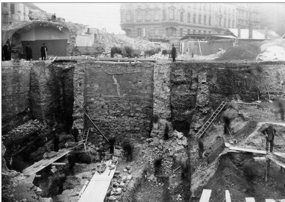
Obr. 15: SMP, výkopky pro stavbu obchodního domu čp. 655/I na místě bývalého premonstrátského semináře s odkrytými pozůstatky opevnění. Pohled na příčnou stěnu základů pod vstupní chodbou semináře. Vpravo od stavby oddělená šikmá stěna příkopové skarp s fragmentem parkánové zdi, 1928 (ÚDU AV ČR, DSF, W-A-151/5-149).
