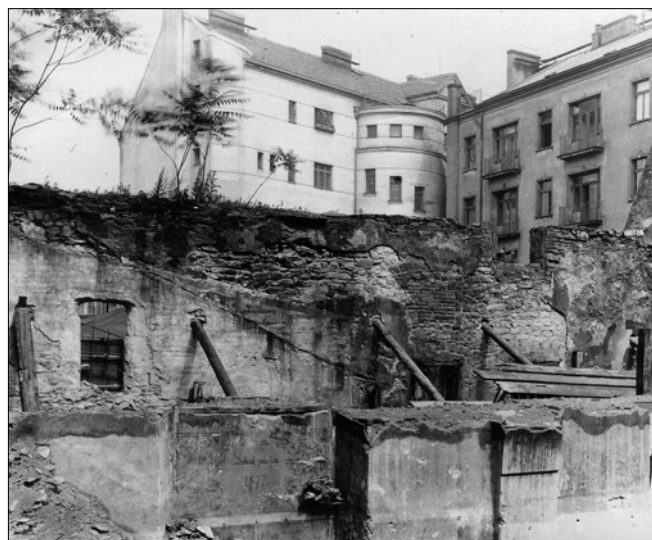
Obr. 24: SMP, úpravy pro stavbu policejního ředitelství v Bartolomějské ulici čp. 310/I s odkrytými pozůstatky opevnění. Pohled na vnější stranu hlavní hradební hradby za areálem bývalého čp. 346/I. Vpravo gotický štít zadního traktu domu čp. 344/I (foto T. Vojta 1930?. ÚDU AV ČR, DSF, W-A-151/5-137).
