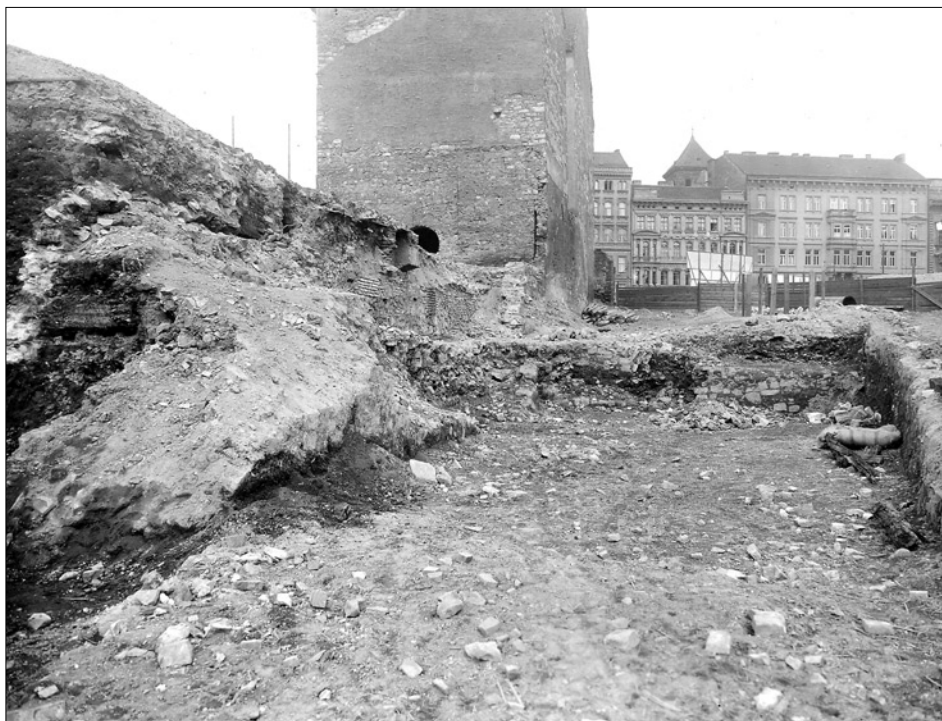
Obr. 11: SMP, výkopy pro stavbu Ministerstva obchodu čp. 1039/I s odkrytými pozůstatky opevnění. Pohled k východu na hlavní hradební zeď v popředí a líc kolmo k ní přilehlé zdi stejné struktury. V pozadí domy Revoluční ulice, 1928 (ÚDU AV ČR, DSF, W-A-151/5-84).
