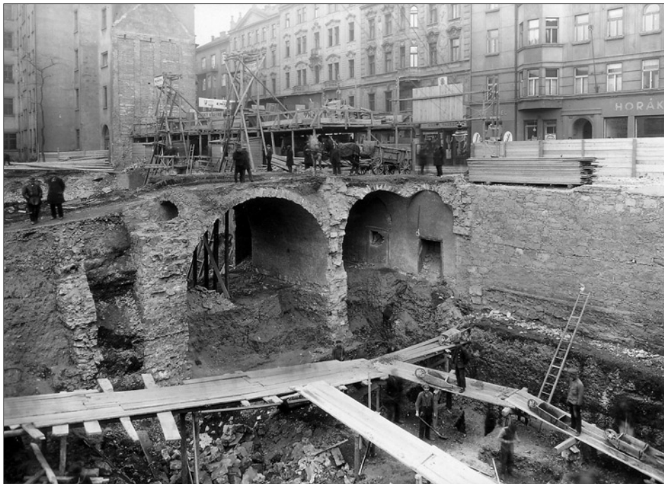
Obr. 14: SMP, výkopky pro stavbu obchodního domu Kotva čp. 655/I na místě bývalého premonstrátského semináře s odkrytými pozůstatky opevnění. Pohled na klenby suterénu semináře mezi středním a západním traktem v severní části stavby. Vlevo od stavby oddělená šikmá stěna příkopové skarp, 1928 (ÚDU AV ČR, DSF, W-A-151/5-108).
