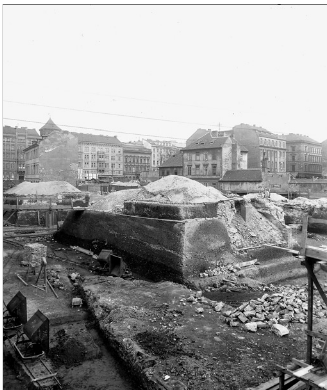
Obr. 9: SMP, výkopy pro stavbu Ministerstva obchodu čp. 1039/I s odkrytými pozůstatky opevnění. Pohled od západu na těleso parkánu (viz obr. 3, 7 a 8), 1928 (ÚDU AV ČR, DSF, W-A-151/5-96).
