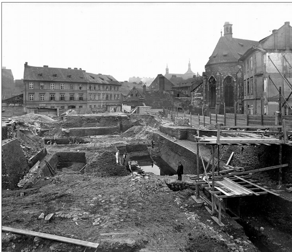
Obr. 3: SMP, výkopy pro stavbu Ministerstva obchodu čp. 1039/I s odkrytými pozůstatky opevnění. Celkový pohled od Vltavy k Anežskému klášteru. V popředí odkrytá koruna a líc hlavní hradební zdi, 1928 (ÚDU AV ČR, DSF, W-A-151/5-207).
