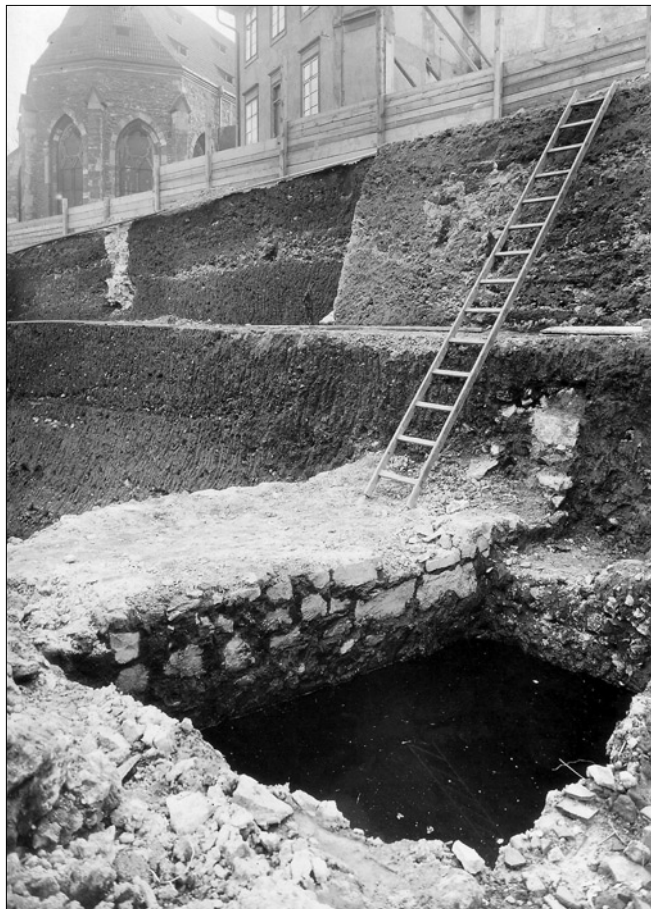
Obr. 8: SMP, výkopy pro stavbu Ministerstva obchodu čp. 1039/I s odkrytými pozůstatky opevnění. Pohled na vnější líc hlavní hradební zdi při severním konci výkopu. V pozadí presbytář kostela sv. Salvátora Anežského kláštera (viz obr. 3 a 7), 1928 (ÚDU AV ČR, DSF, W-A-151/5-91).
