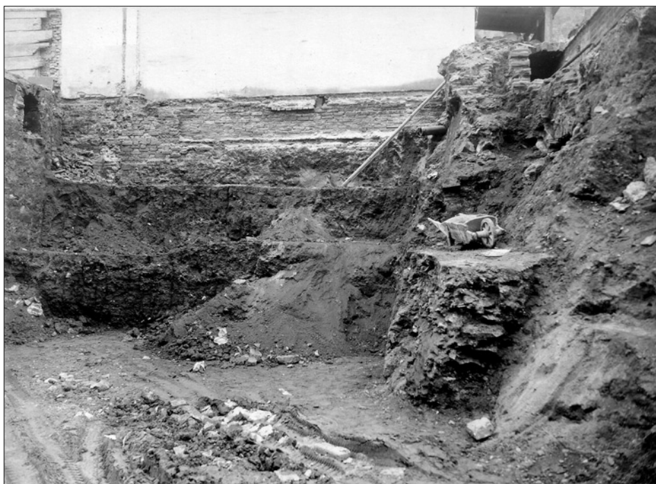
Obr. 21: SMP, výkopky pro stavbu pojišťovny Assicurazioni Generali v ulici Na Příkopě čp. 988/I s odkrytými pozůstatky opevnění. Detail skarpy a částečně odkrytého prostoru příkopu, 1936 (ÚDU AV ČR, DSF, W-A-151/5-68).
