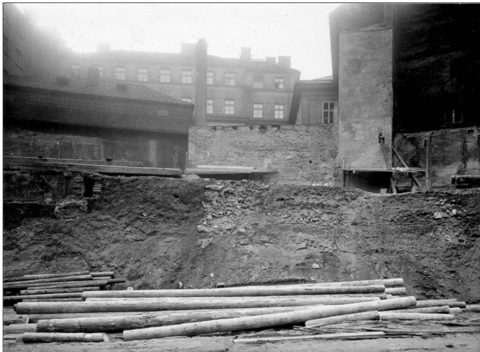
Obr. 20: SMP, výkopky pro stavbu pojišťovny Assicurazioni Generali v ulici Na Příkopě čp. 988/I s odkrytými pozůstatky opevnění. Průřez hlavní hradbou a zaniklým dvorním objektem čp. 586/I s cihelnou dlažbou, 1936 (ÚDU AV ČR, DSF, W-A-151/5-65).
