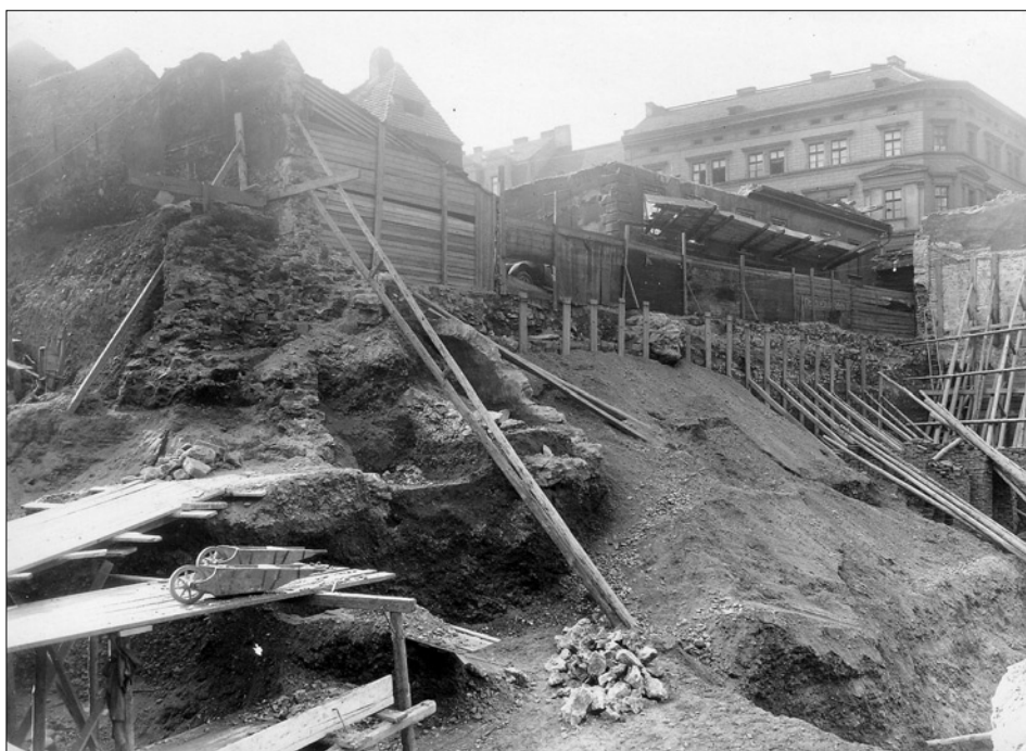
Obr. 17: SMP, výkopy pro stavbu obchodního domu čp. 655/I na místě bývalého premonstrátského semináře s odkrytými pozůstatky opevnění. Pohled na zbytky kanalizační šachty a zdi objektu (věže?) přistaveného k hlavní hradební zdi v severozápadní části areálu, 1928 (ÚDU AV ČR, DSF, W-A-151/5-175).
