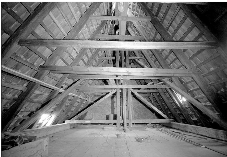
Obr. 6: Praha - Podolí, kostel sv. Michaela archanděla, celkový pohled do prostoru krovu lodi od západu. V centru je patrná štenýřová konstrukce sanktusníku (foto V. Tuř, 2006).
