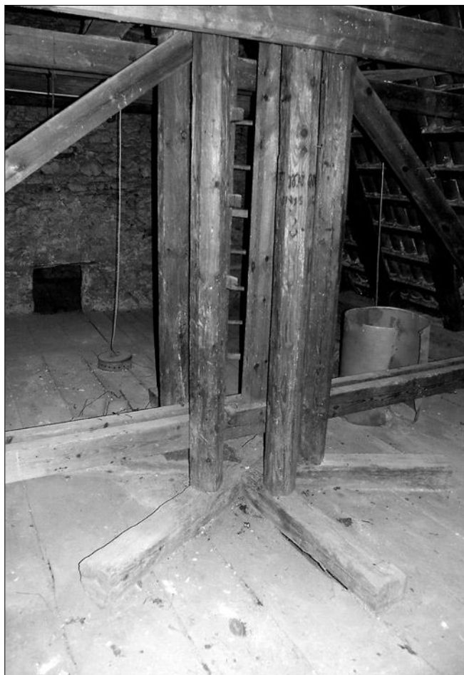
Obr. 8: Praha - Podolí, kostel sv. Michaela archanděla, detail paty sanktusníku. Štenýřová konstrukce je uložena prostřednictvím šestipaprscitého roštu přímo na záklop stropu lodi. Na středních štenýřích je patrné ryté vnoření (foto J. Veselý, 2006).
