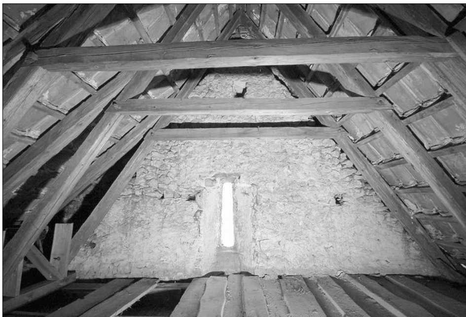
Obr. 11: Praha - Podolí, kostel sv. Michaela archanděla, pohled na krov presbytáře a západní líc jeho štítu s dvojicí oken. Horní okénko je zaslepené (foto J. Veselý, 2006).
