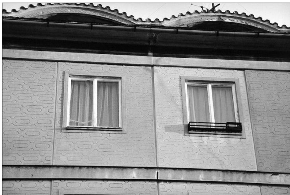
Obr. 2: Miloslav Wimmer, prototyp panelového domu s montovaným skeletem, Praha – Dáblice, U Přefy 771/25, detail fasády (foto E. Pýchová).
