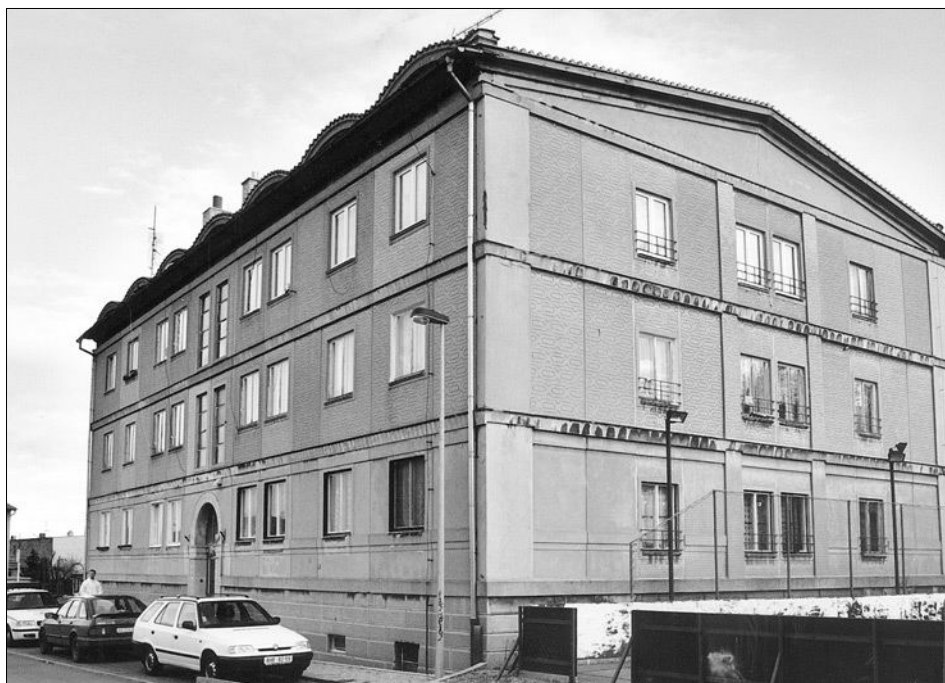
Obr. 6: Miloslav Wimmer, prototyp panelového domu s montovaným skeletem, Praha – Ďáblice, U Prefy 771/25, realizace (foto E. Pýchová).
