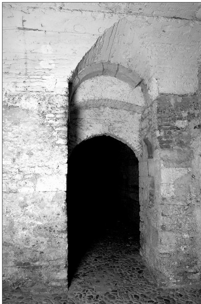
Obr. 4: Dům čp. 606a „Ad sedem“. Torzo východního portálu síně. Kvádrové zdivo a oblouk portálu po 1135 (?), konzola tympanonu vzniklá dodatečně (foto G. Čapková).
