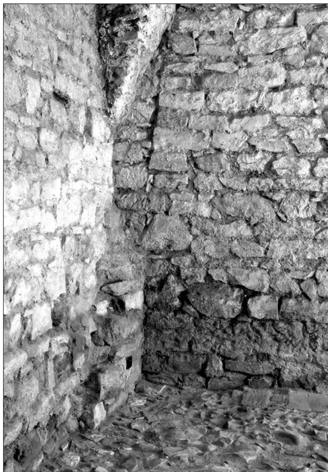
Obr. 13: Dům čp. 606a. Jihovýchodní kout suterénní síně sklenuté na střední pilíř. Stopy dvou stavebních etap. Druhá čtvrtina 13. století (foto J. Vítovský).
