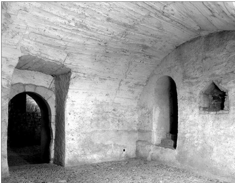
Obr. 17: Bývalá směnárna čp. 606b. Síň na jihozápadě suterénu. Vlevo vstup z bočního vestibulu, vpravo zadní vstup. Kolem 1230 (foto J. Vítovský).
