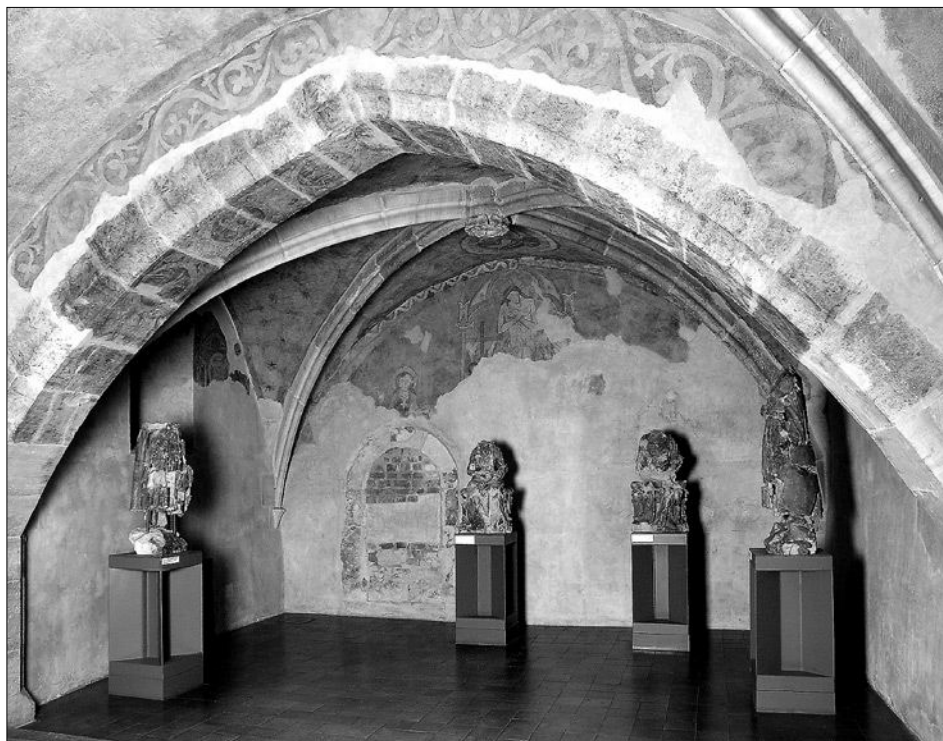
Obr. 30: Palác čp. 605. Oratoř Václava II. (?) v přízemí jižního křídla. Zdivo, západní portálek a pas s klenebními kápiemi před 1278. Žebra, svorníky, klenební konzoly a malba před 1305 (foto G. Capková).
