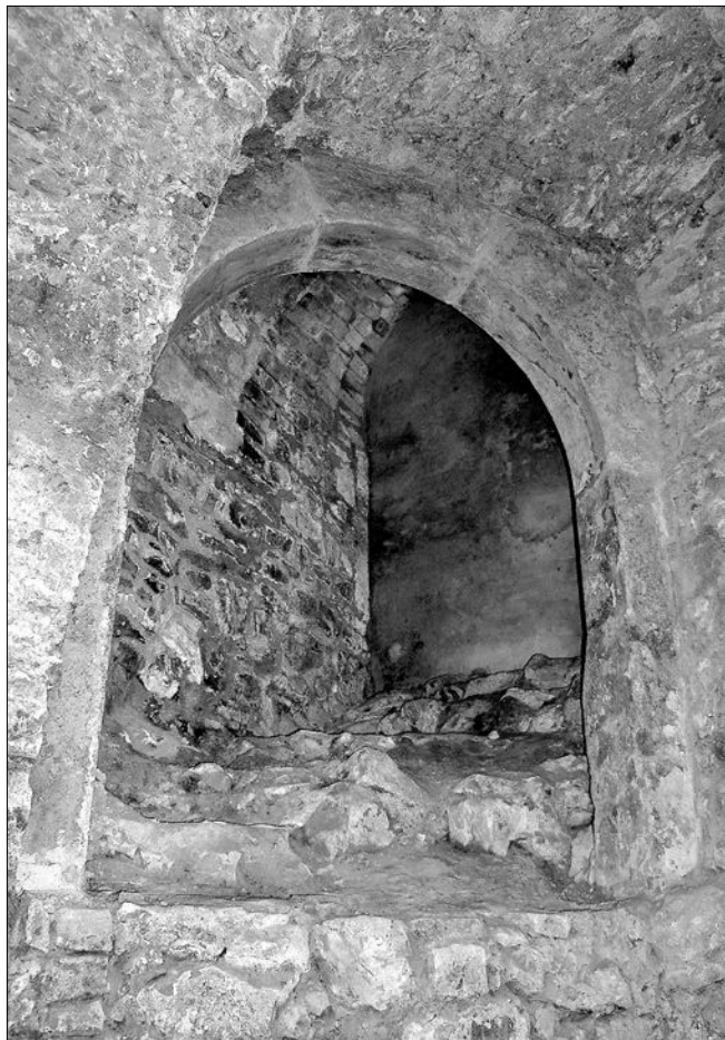
Obr. 15: Palác čp. 605. Torzo sestupu z východního nádvoří do jižního příčného ramene (dnes v čp. 606). Průhled vnitřním portálem na cihelnou klenbu schodiště. Kolem 1250 (foto J. Vítovský).
