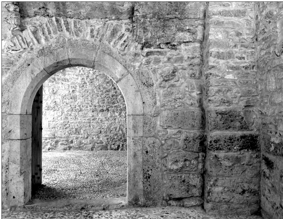
Obr. 16: Palác čp. 605. Portál v přičce mezi jižním příčným ramenem a jižním křídlem suterénu (dodatečně spuštěný níž). Portál kolem 1240, spodní část stěny kolem 1500 (foto J. Vítovský).
