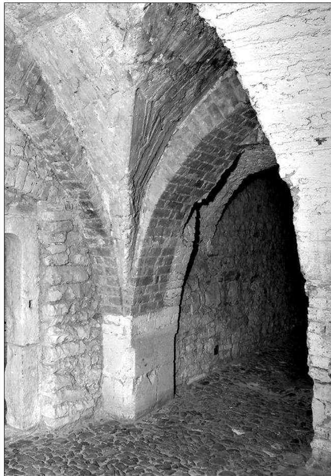
Obr. 11: Dům čp. 606a. Síň jižního přístavku domu „Ad sedem“, sklenutá na střední pilíř. Pohled na původní pilíř a dodatečné přičky. Kolem 1240; přestavby 2. polovina 14. století a mladší (foto J. Vítovský).
