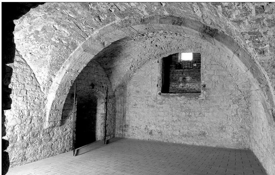
Obr. 24: Dům čp. 607 (patrně Eberlinova mincovna). Suterénní síň s křížovými klenbami a pasem. Pohled na rub spodku domovního průčelí s otvorem do náměstí. Kolem 1240 (foto G. Čapková).
