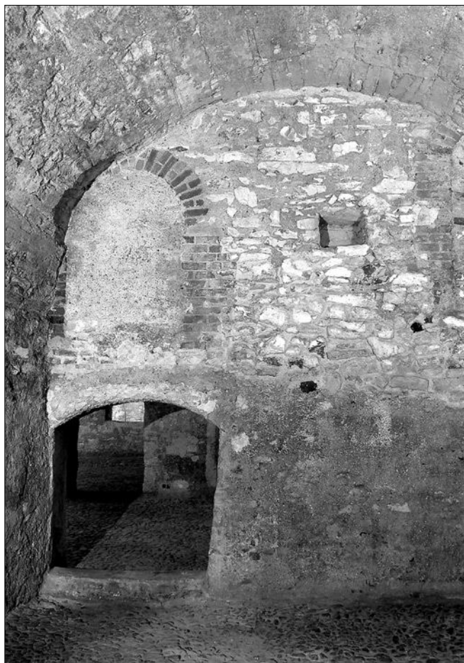
Obr. 21: Bývalá směnárna čp. 606b. Zazděné cihelné vstupy ve východní zdi severního příčného ramene. Pohled od východu. Kolem 1250 (foto J. Vitovský).
