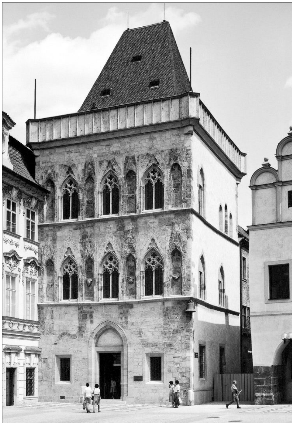
Obr. 32: Palác čp. 605. Věžová budova. Průčelí po restaurování. Po 1310 (foto V. Obereigner).
