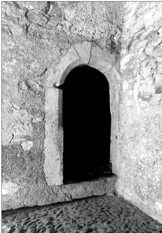
Obr. 20: Bývalá směnárna čp. 606b. Portálek s drápkem mezi třetí suterénní místností a suterénem severního příčného ramene. Třicátá léta 13. století (foto J. Vítovský).
