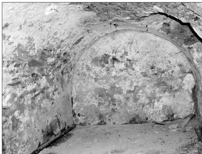
Obr. 5: Horní Benešov, čp. 31. Tzv. předstř sklepa, stav v roce 2003 (foto K. Kovář).
