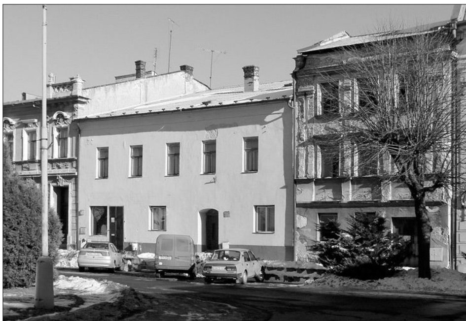
Obr. 1: Horní Benešov (okres Bruntál), nám. Míru, domy čp. 30 a 31, stav v roce 2003 (foto K. Kovář).
