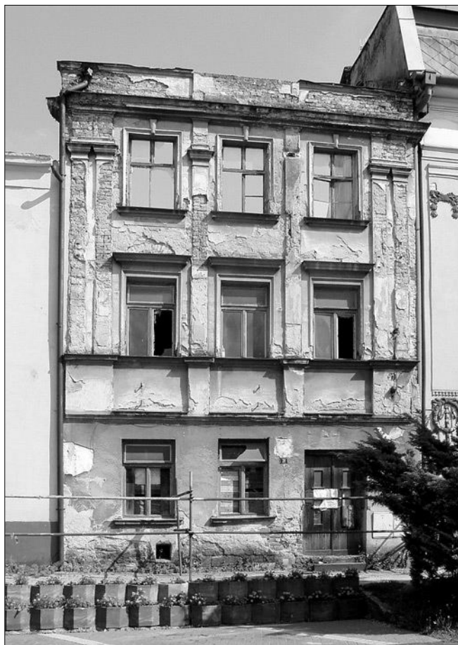
Obr. 6: Horní Benešov, čp. 31. Fasáda v průběhu demoličních a stavebních prací, stav v roce 2003 (foto K. Kovář).
