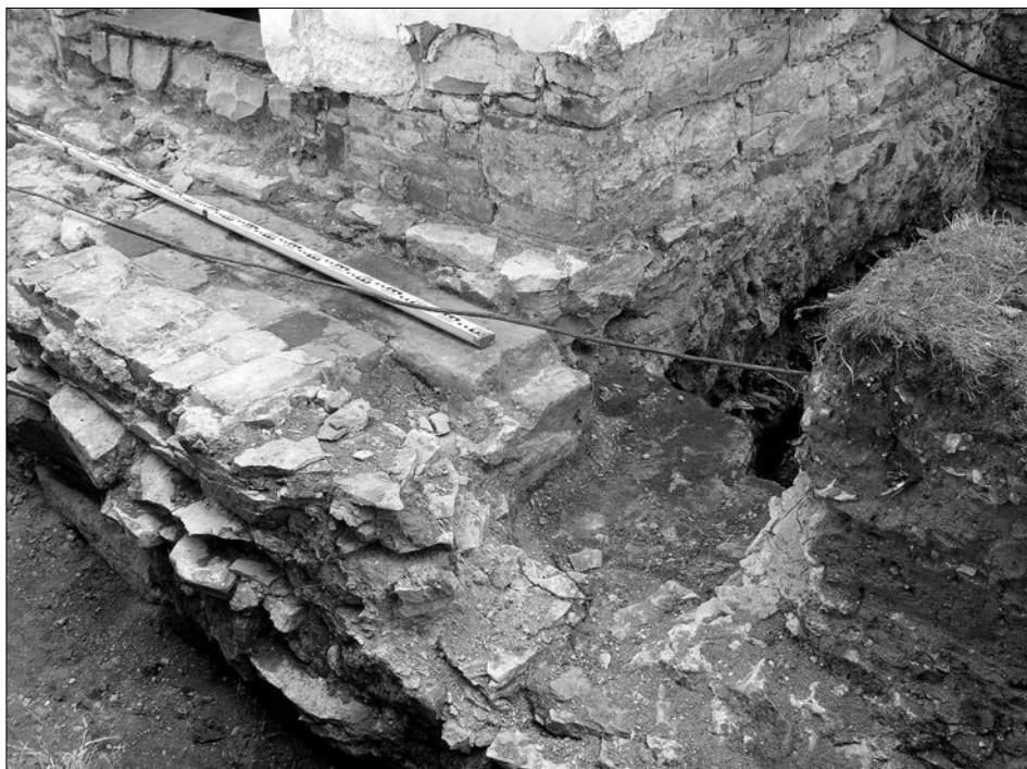
Obr. 13: Mělník – Pšovka, bazilika sv. Vavřince, práh mladšího vstupu vybudovaný ze dvou pískovcových schodů a cihlového zdiva. Jeho pravý okraj se nachází ve stejné linii jako západní líc vstupní před síně.
