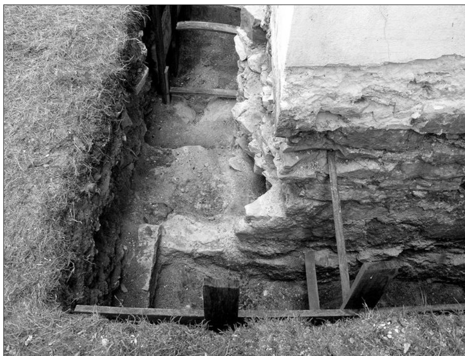
Obr. 4: Mělník – Pšovka, bazilika sv. Vavřince, severovýchodní nároží boční lodě. Vpravo pozůstatek nadzemního zdiva adaptovaného do podoby západního opěráku presbytáře.
