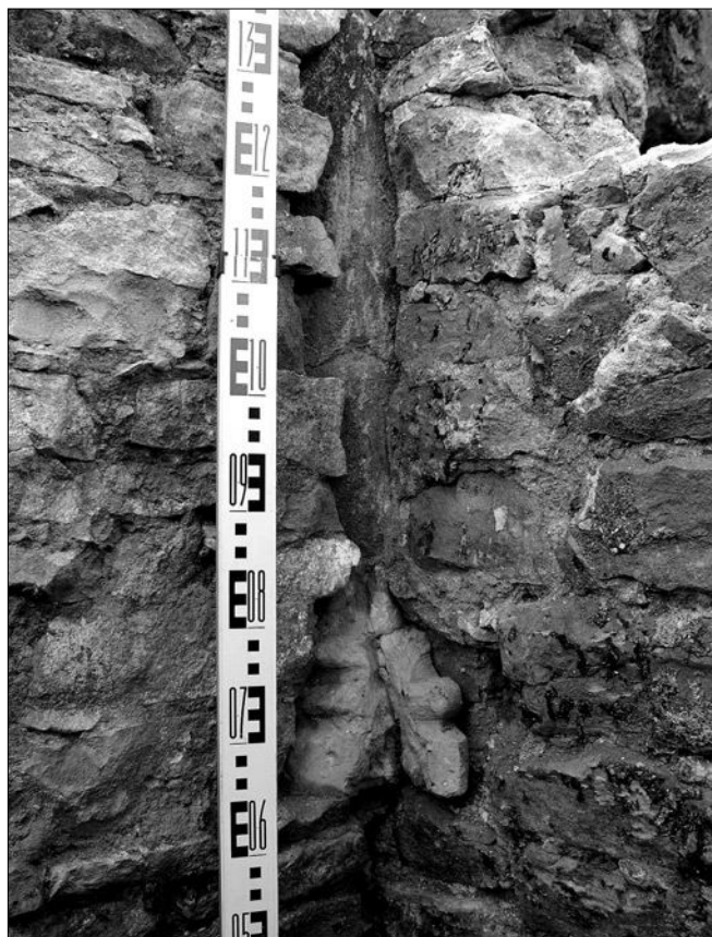
Obr. 17: Mělník – Pšovka, bazilika sv. Vavřince, polopilíř s profilovanou patkou vsazený do západního zdiva lodi. Jako jediný z pilířů byl proveden z pískovce. Zleva k němu přiléhá zazdívká mezilodní arkády.
