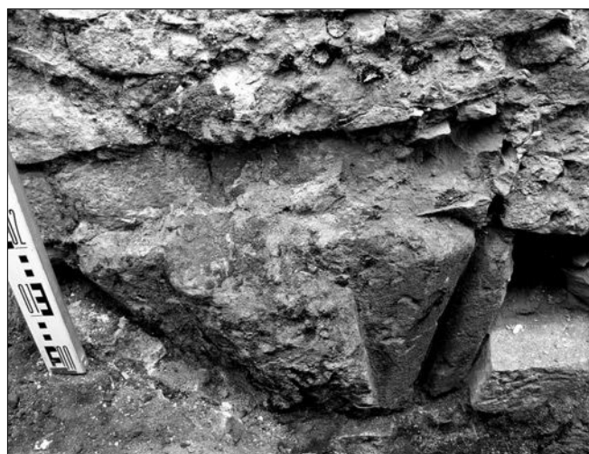
Obr. 18: Mělník – Pšovka, bazilika sv. Vavřince, torzo pískovcového náběžníku klenby v zazdívkě mezi 3. a 4. pilířem mezilodní arkády.
