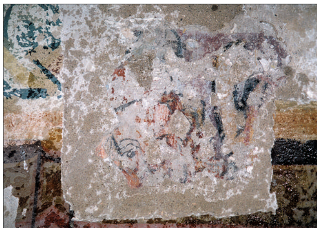
Obr. 16: Vrbno, kostel Povýšení sv. Kříže, jižní stěna presbytáře, hlava světce, stav po odkrytí malby.
