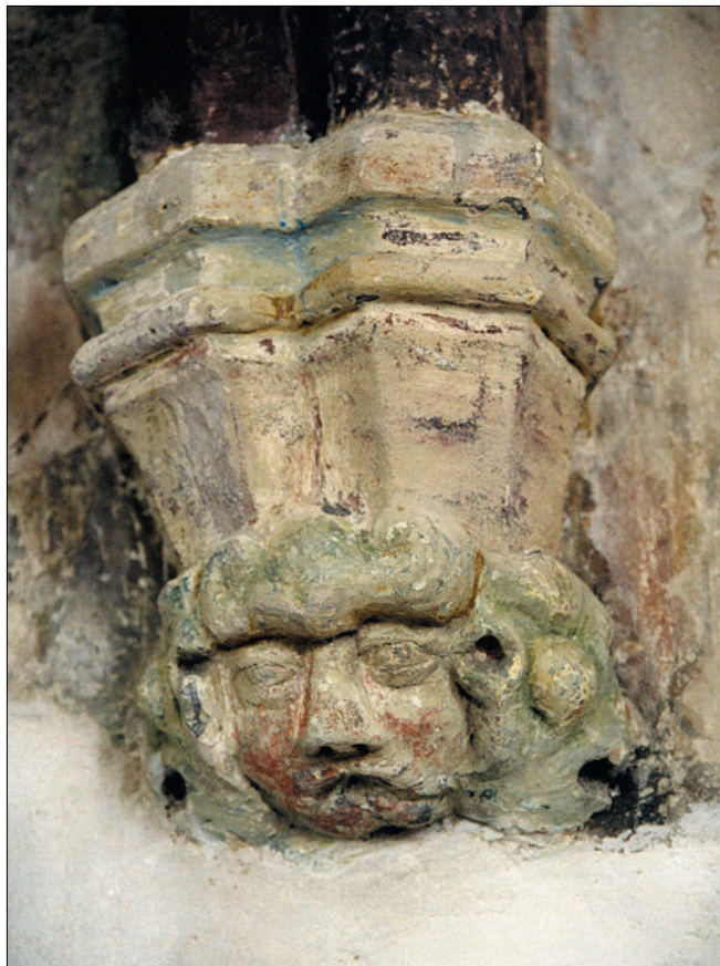
Obr. 4: Vrbno, kostel Povýšení sv. Kříže, severní stěna presbytáře, detail konzoly s hlavou divého muže.
