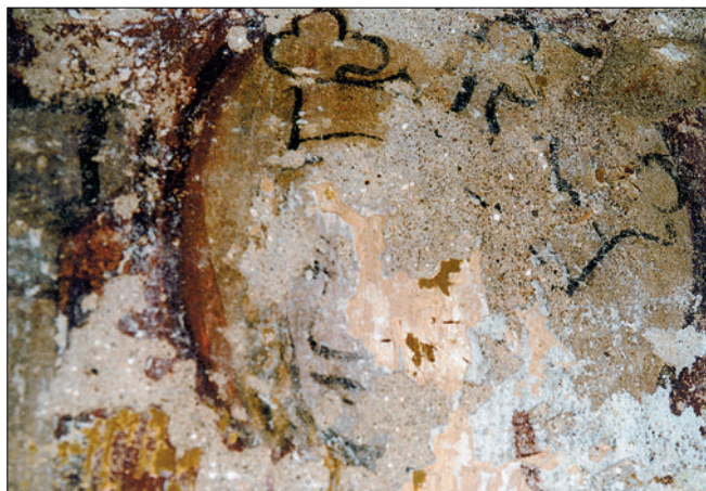
Obr. 23: Vrbová, kostel Povýšení sv. Kříže, jižní stěna presbytáře, sv. Barbora, stav po odkrytí, detail.
