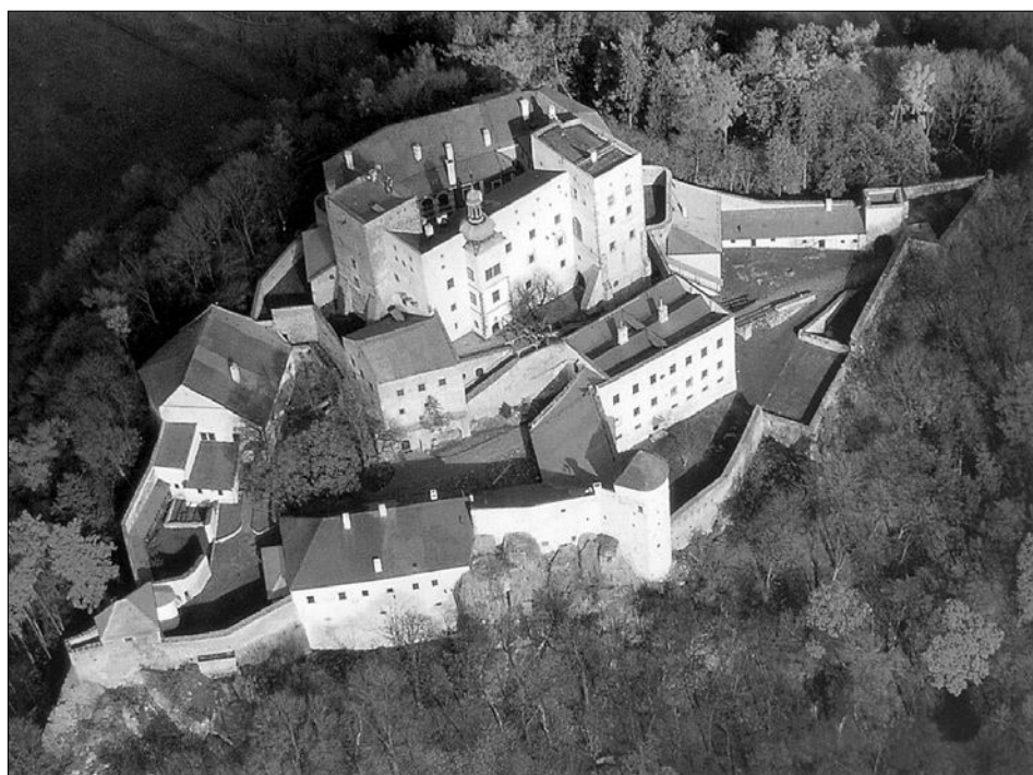
Obr. 1: Hrad Buchlov – letecký snímek hradu, pohled od jihozápadu; uprostřed horní části snímku hradní jádro obklopené parkánem, pod jeho jihozápadním nárožím (v popředí) se nachází dům s Tanečním sálem. Napravo od něj jsou patrné schodišťová rampa, nástupní terasa a průchozí Hodinová věž s bání (novodobá pohlednice; Gloriet s. r. o., foto: J. Kulich).
