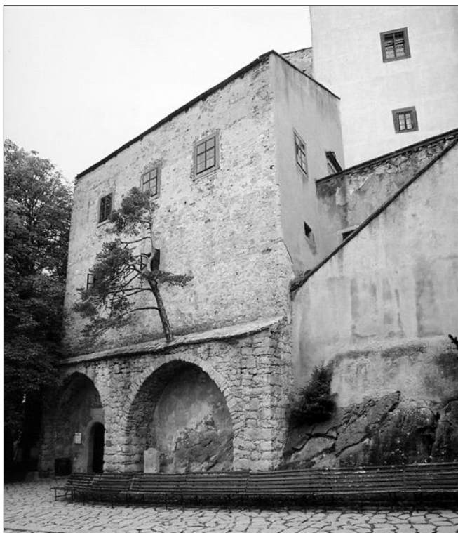
Obr. 6: Hrad Buchlov – dům s Tanečním sálem, pohled od jihovýchodu; dole v ploše levé slepé arkády vstup do 1. NP, napravo stoupající koruna zdiva schodišťové rampy, nad ní část východního průčelí a ustupující část jižního průčelí objektu.
