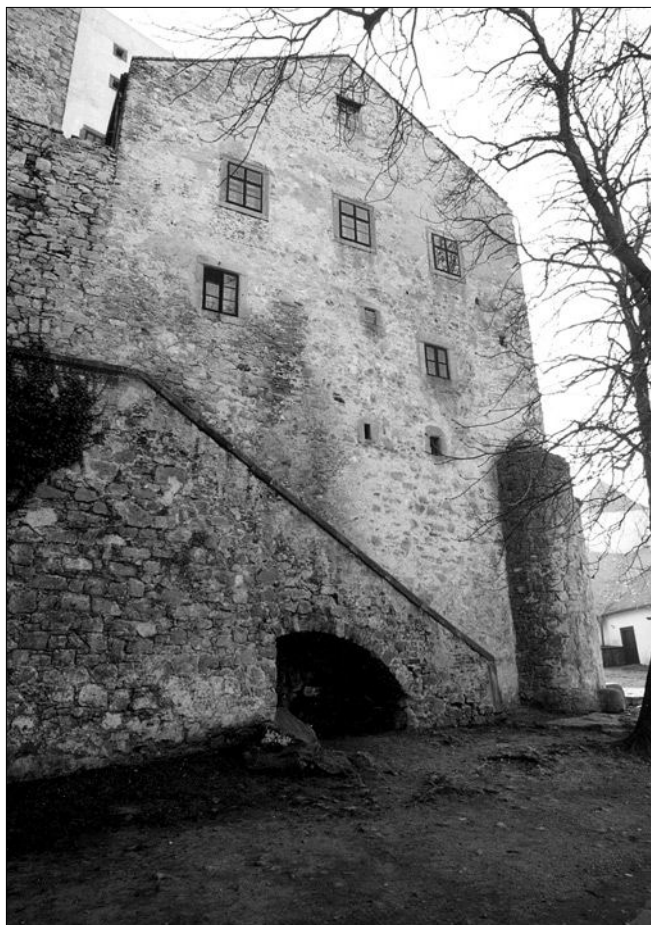
Obr. 2: Hrad Buchlov – dům s Tanečním sálem, pohled od západu; dole podklenutá schodišťová rampa, napravo zaoblený nárožní pylon zdíva, na-levo nad schodišťovou rampou parkánová hradba, navazující na objekt s Tanečním sálem (není-li uvedeno jinak, všechny kresby a fotografie R. Vrla 2005).
