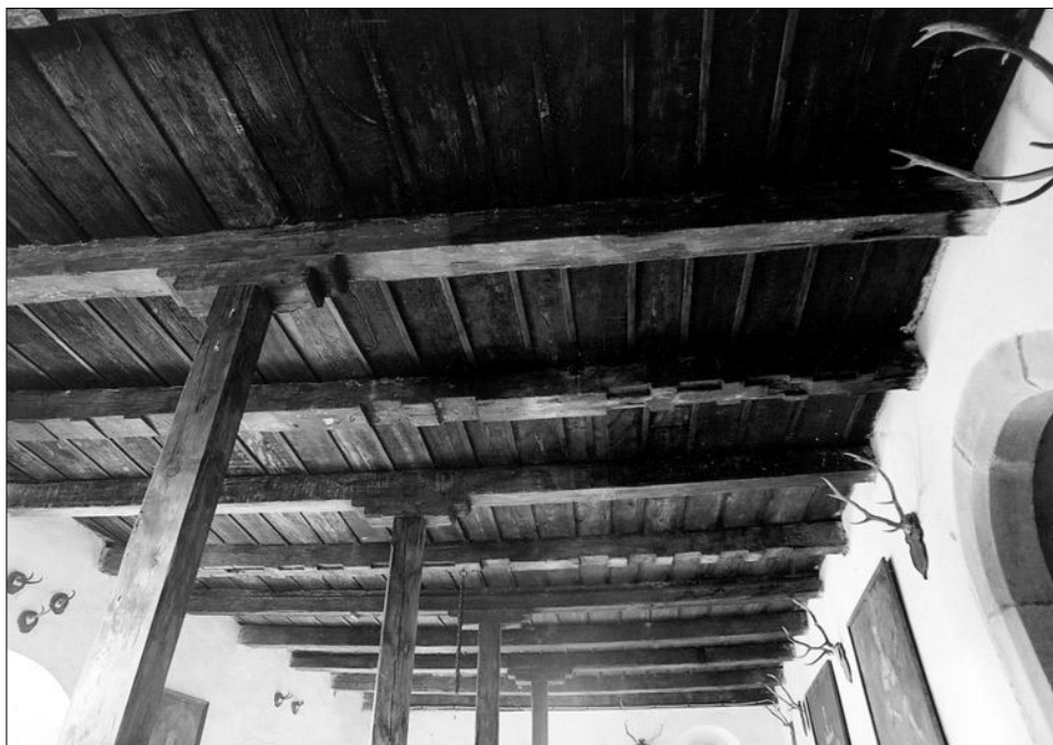
Obr. 12: Hrad Buchlov – dům s Tanečním sálem; 3. NP, detail trámového stropu jižní místnosti, napravo vstup do severní místnosti.
