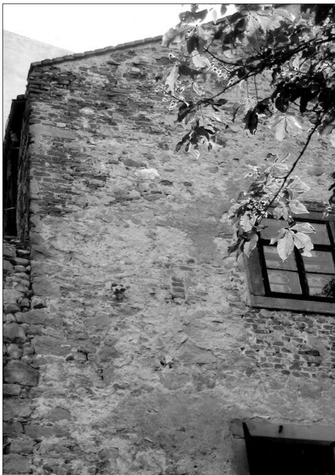
Obr. 5: Hrad Buchlov – dům s Tanečním sálem, detail části severozápadního nároží s šikmým rozhraním, oddělujícím zdiva jiného charakteru (zbytek staršího štítu?). Pohled od západu.
