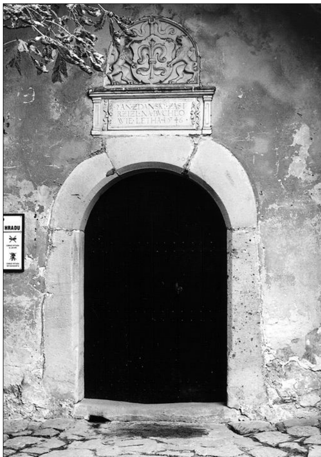
Obr. 7: Hrad Buchlov – dům s Tanečním sálem, detail vstupu do 1. NP, pohled od jihu.
