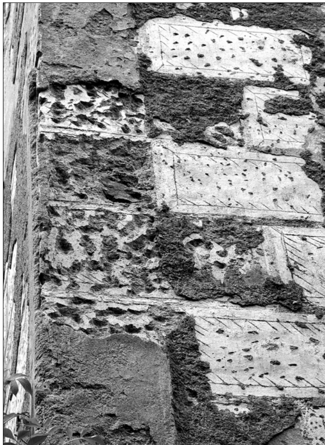
Obr. 23: Zvěstov (okres Benešov), zámek čp. 1. Detail nároží, kde se pod opadávající omítkou z 19. století objevují plochy jen částečně narušeného renesančního sgrafita (foto J. Beránek, 2005)
