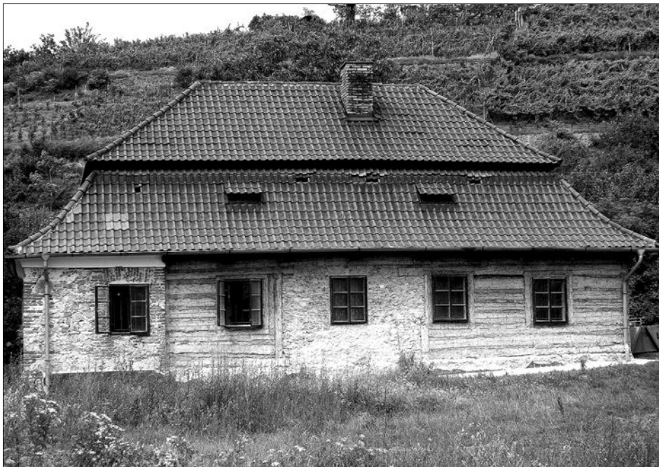
Obr. 10: Modřany (Praha 12), viniční dům čp. 6, celkový pohled na hlavní stavení usedlosti od jihu. Střecha stavby již byla opravena, zatímco opravy konstrukcí přízemí probíhají postupně. Po sejmutí většiny omítek bylo možné doložit rozsah zachování původních konstrukcí a dílčí pozdější zásahy (např. přezdění stěny v rozsahu levé okenní osy). V tomto případě byla akce OPD výsledkem členěné odborně personální pomoci územnímu odbornému pracovišti NPÚ v hl. m. Praze, které na projektu OPD zatím nespolupracuje, řešitelem z jiného pracoviště (foto V. Jesenský, 2005).
