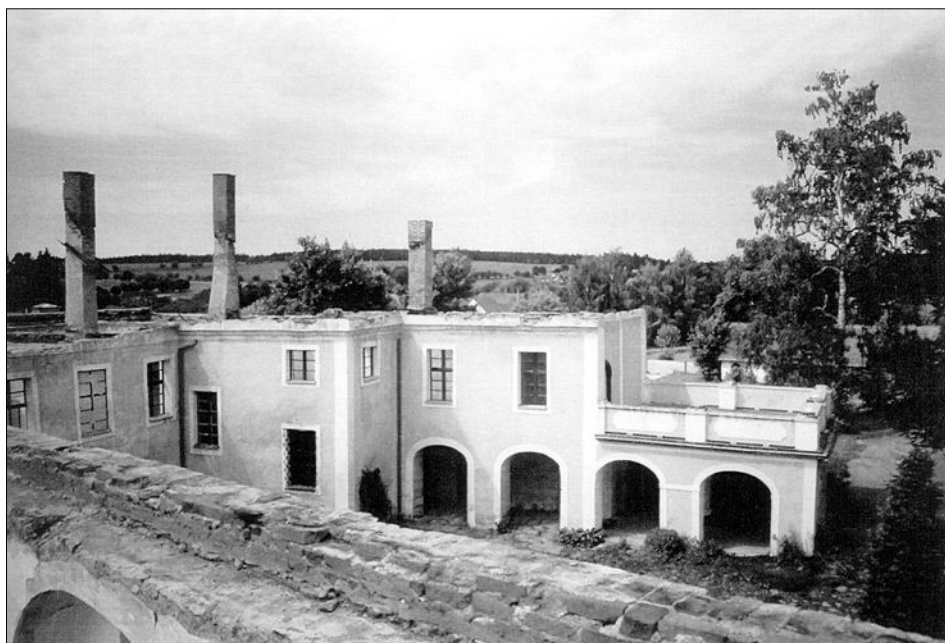
Obr. 19: Vodice (okres Tábor), zámek. Objekt po tragickém požáru poskytuje mnoho informací o reliktech výzdoby a o četných konstrukčních řešeních. V případě budoucích oprav by měly akce OPD pokračovat a doplňovat další poznatky (foto V. Ouarda, 2005).
