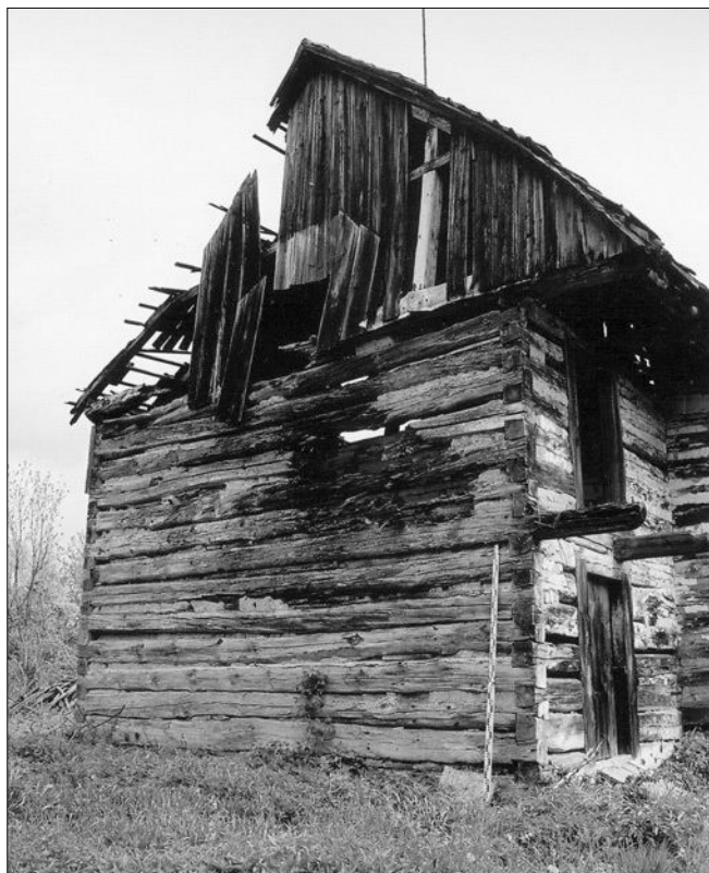
Obr. 13: Rabakov (okres Mladá Boleslav), usedlost čp. 2 – roubená stodola s připojenou dvouetážovou sýpkou. Příklad akce OPD zaměřené na objekt bezprostředně ohrožený zánikem v důsledku ztráty využití. V takových případech se mnohdy jedná o poslední dokumentaci (foto J. Kypta, 2005).
