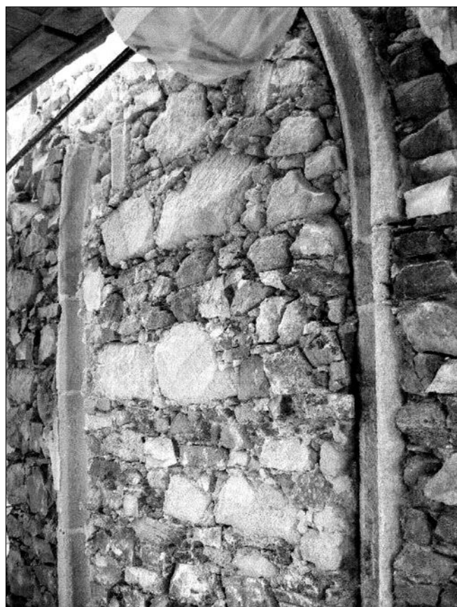
Obr. 17: Strašice (Rokycany), kostel sv. Vavřince, detail zazdívky gotického okna ve východní stěně presbyteria. Středověké kostely reprezentují ve většině venkovských lokalit nejvýznamnější doklad minulosti. V průběhu dlouhého života těchto památek většinou došlo k řadě více či méně rozsáhlých změn (četné kostely díky nepříteli osudu v minulosti zanikly – mnohé bohužel byly zničeny až po roce 1948...), většinou vyvolaných vývojem liturgie a slohového názoru. Proto je většina průzkumů sakrálních staveb na venkově, ale i ve městech či v kláštorech rozhodujícím přínosem k poznání kulturních dějin. Opravy by měly být vždy využity k realizaci OPD. Protože je většina aktuálních oprav prováděna s respektem k památkové hodnotě (i když po řemeslné stránce jsou některé zásahy nadměrné – to se může týkat nejedné prakticky úplné výměny omítek), má tím větší význam sbírat poznatky o těch místech staveb, která jsou případně dočasně zpřístupněna, někdy i s odstupem desítek let. Takovému postupnému sběru poznatků dobře odpovídá modulový přístup k OPD, cíleně směřující k vytváření pozitivistických NZ, jež ve svém součtu budou přinášet stále komplexnější poznání (foto T. Karel, 2005).
