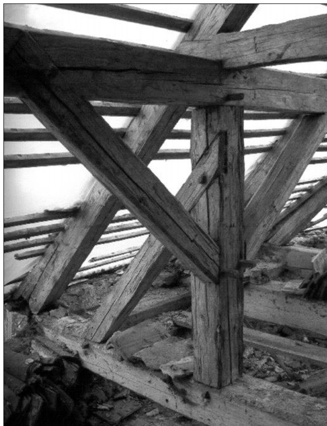
Obr. 14: Seč (okres Plzeň-jih), kaple sv. Barbory. Příklad využití opravy krovu k realizaci akce OPD. Při sejmutí krytiny je zpravidla možné pořídit fotodokumentaci konstrukce krovu bez problémů s jinak obvyklým nedostatkem osvětlení (foto T. Karel, 2005).
