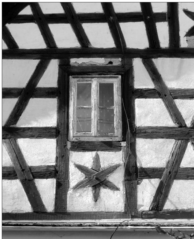
Obr. 1: Číhaná (okres Karlovy Vary), usedlost ev. č. 4 (původně čp. 18), detail hrázděného střešního štítu. Příklad akce OPD probíhající v několika krocích. Nejprve byl proveden předběžný průzkum, identifikující hodnoty památky, na jehož základě byly vypracovány podmínky pro připravovanou opravu. Po zahájení stavebních prací byly ze stavebního lešení prozkoumány běžně nepřístupné detaily hrázděné konstrukce štítu, přičemž byl dokumentován způsob, jímž byly vytvořeny dekorativní hvězdice (foto L. Zeman, 2005).
