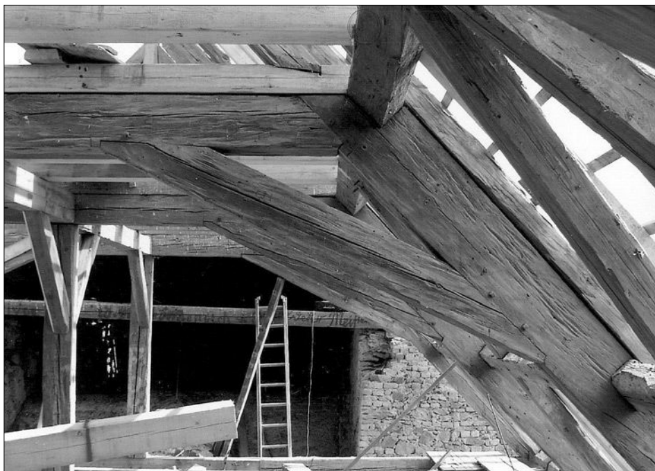
Obr. 11: Olbramovice (okres Znojmo), kostel sv. Jakuba Většího, detail krovu lodi v průběhu stavebních prací. Konstrukce krovů jsou velmi ohroženou součástí stavebních památek. Proto lze vítat, že jsou v posledních letech častěji opravovány šetrnějšími řemeslními postupy. Přesto je třeba prosazovat provedení OPD, neboť v průběhu opravy lze zpřístupnit některé části krovu, jinak nedosažitelné. To mohou být partie při hřebeni střechy nebo horní plochy krovů, kde mohou být sledovány např. otisky staršího laťování. Při akcích OPD v krovech by měly být podchyceny také zbytky starších krytin, jež bývají pohozeny v koutech nebo v zásypu kleneb (zásypy by neměly být vybírány bez dohledu archeologa!). Prohlédnuto a dokumentováno by mělo být půdní zdivo, na němž mohou být patrné cenné doklady stavebního vývoje, rovněž často dosažitelné nebo viditelné jen v době opravy! (foto L. Šabatová, 2005).
