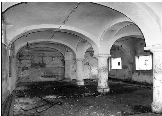
Obr. 5: Kročehlavy, Kladno (okres Kladno), hospodářský dvůr čp. 1, interiér chlévů před demolicí (foto E. Volfová, 2005).
