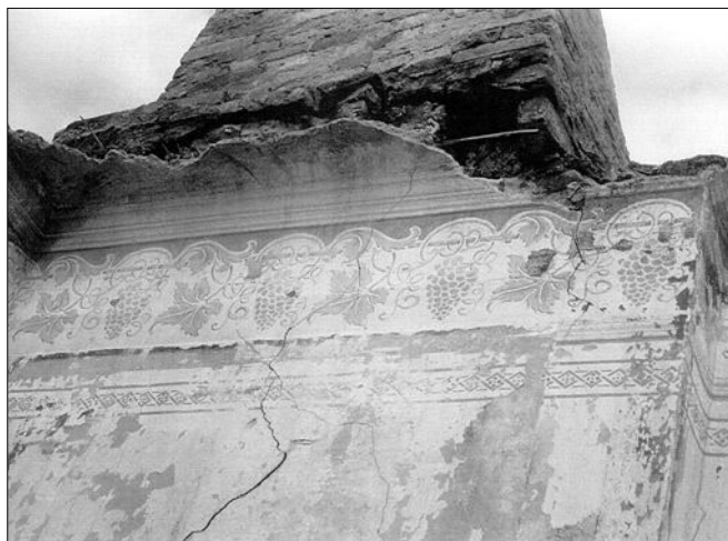
Obr. 20: Vodice (okres Tábor), zámek. Detail secesní malířské výzdoby interiéru po destrukci stropů vyhořelého objektu (foto V. Oúroda, 2005).
