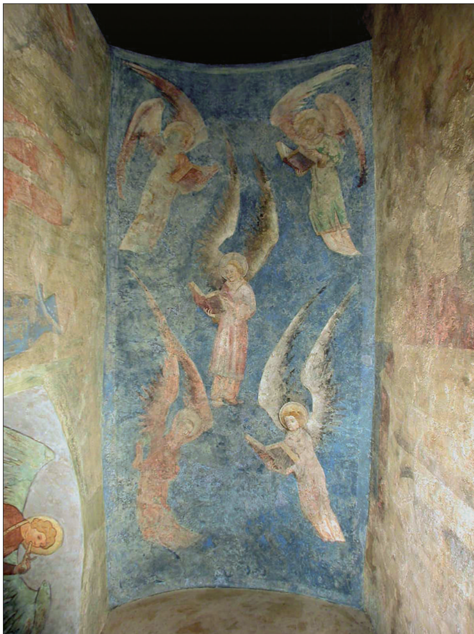
Obr. 11: Původní zachovaná klenba, fragmenty 5 postav andělů a modrého podkladu, stav po opravě.
