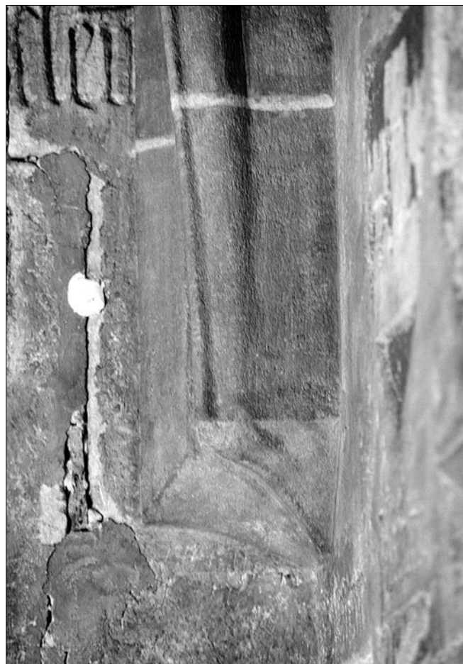
Obr. 19: Lauf a. d. Pegnitz, erbovní sál, detail pravého klenebního výběhu s podložkou tvořenou přízedním žebrem (foto R. Němec, 2003).
