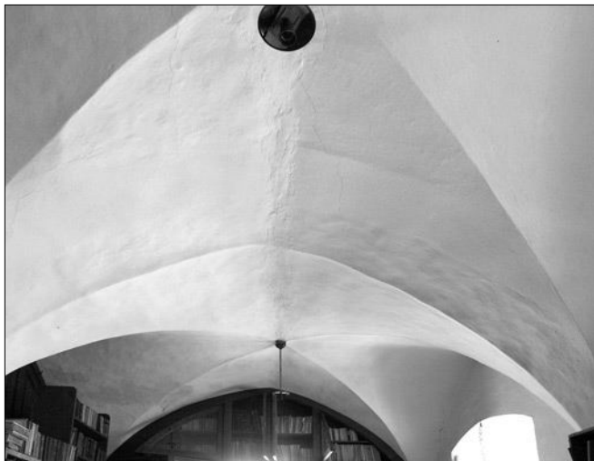
Obr. 30: Bečov nad Teplou, hrad, tzv. Pluhovské domy, první patro 1-4, klenba v pohledu od severu.
