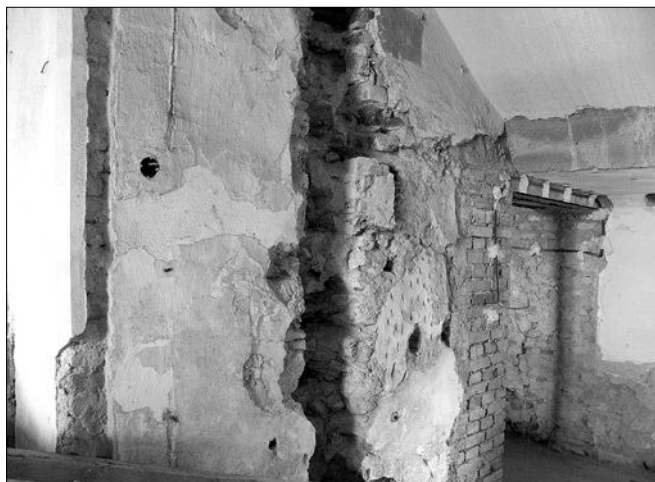
Obr. 28: Bečov nad Teplou, hrad, tzv. Pluhovské domy, první patro 1-1, vřetenová zeď schodiště, jižní stěna nesoucí vrstvy omítky počínaje renesancí.
