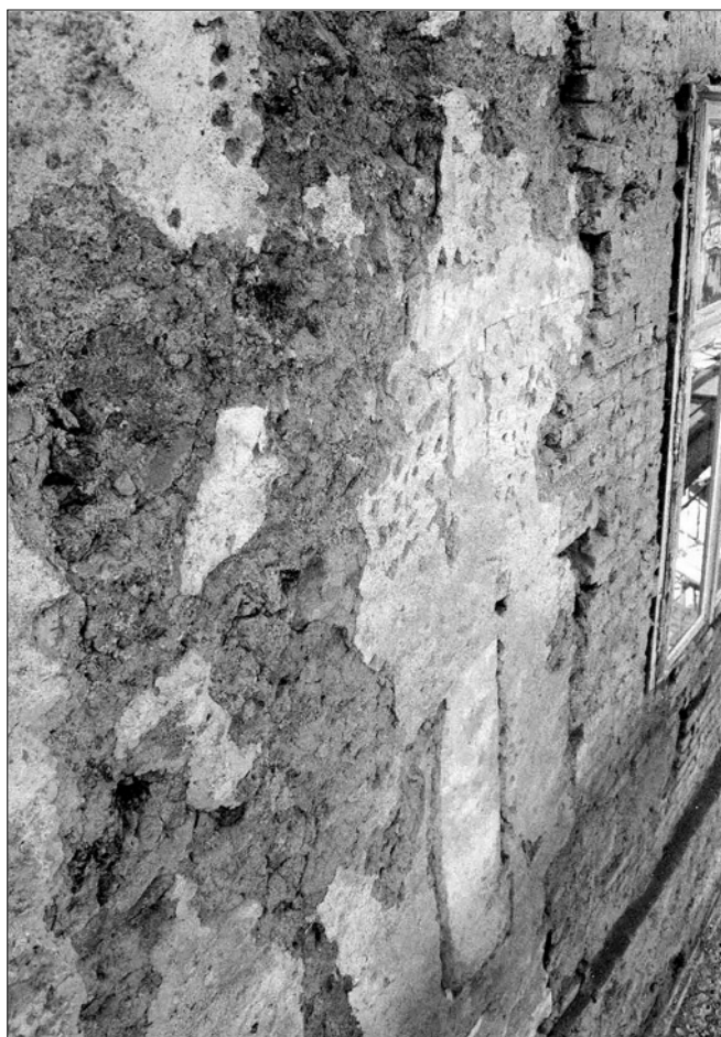
Obr. 19: Bečov nad Teplou, hrad, tzv. Pluhovské domy, nádvorní průčelí, pozdně gotické okenní ostění in situ ve 2. patře (položka 2 na obr. 13). Foto P. Měchura 2002, úhel pohledu dán možnostmi lešení.
