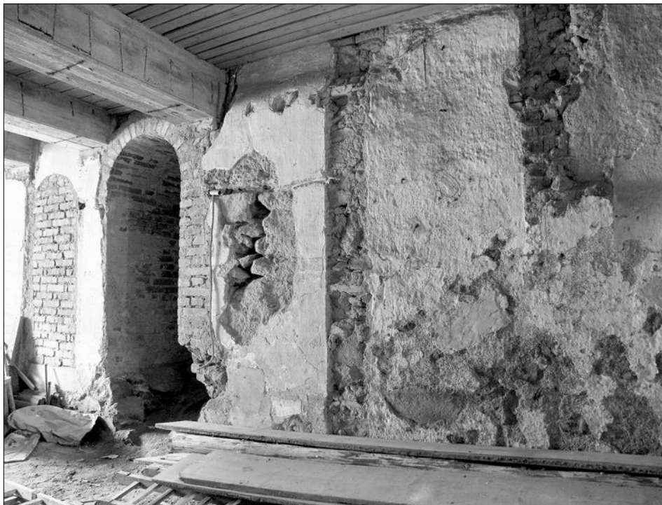
Obr. 20: Bečov nad Teplou, hrad, tzv. Pluhovské domy, přízemí 01, jižní stěna, vpravo pata bývalého pasu založena do otvoru gotického okna.
