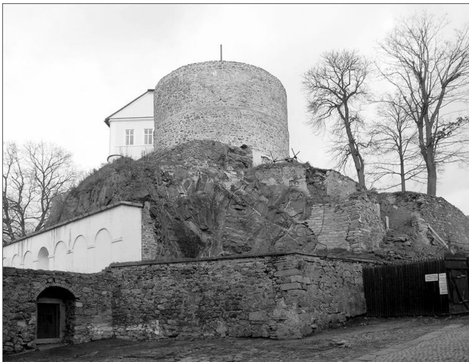
Obr. 10: Bečov nad Teplou, hrad, válcová věž od jihu.
