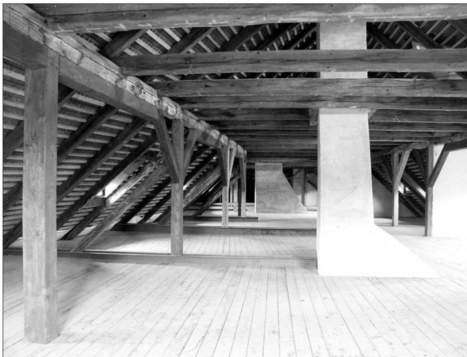
Obr. 31: Bečov nad Teplou, hrad, tzv. Pluhovské domy, klasicistní krov, pohled od jihu.
