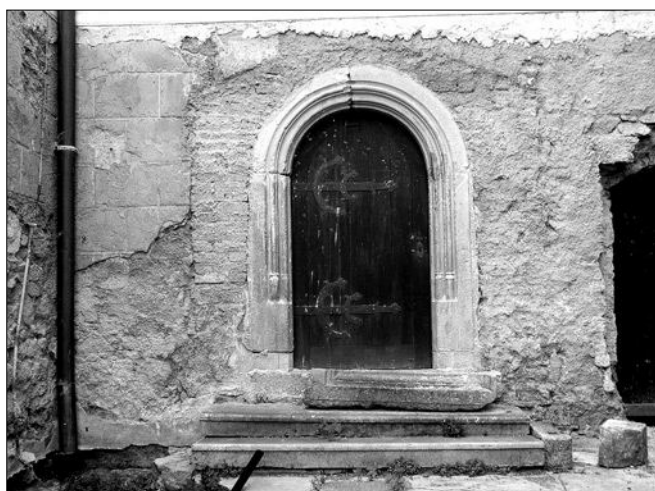
Obr. 17: Bečov nad Teplou, hrad, tzv. Pluhovské domy, nádvorní průčelí, druhotně použitý portál ve vchodu do severní části (prostor bývalé kuchyně), vlevo klasicistní rustika.
