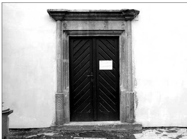
Obr. 16: Bečov nad Teplou, hrad, tzv. Pluhovské domy, nádvorní průčelí, druhotně použitý portál ve vchodu do přízemí dvoudílného jádra.
