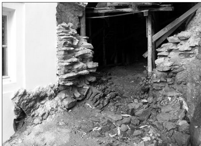
Obr. 18: Bečov nad Teplou, hrad, tzv. Pluhovské domy, nádvorní průčelí, reliktů objektu spojujícího Pluhovské domy s horním hradem; vlevo záklenek (položka 3 na obr. 13), dole uprostřed úsek čelo klenby sklepa.
