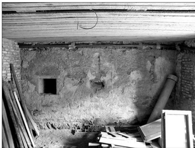
Obr. 22: Bečov nad Teplou, hrad, tzv. Pluhovské domy, přízemí 02, severní stěna, vlevo nově přezděné gotické okno z počáteční fáze objektu, pohled z bývalého interiéru, dole vylehčovací pas nad bývalým vchodem do sklepa dvojdílného jádra.
