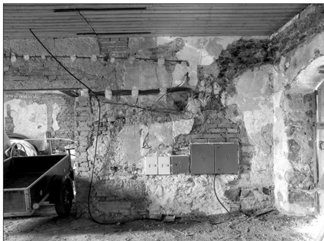
Obr. 25: Bečov nad Teplou, hrad, tzv. Pluhovské domy, přízemí 06, severní stěna v prostoru bývalého raně renesančního kuchyně, skříň elektrického rozvodu v zádávce starého otvoru.
