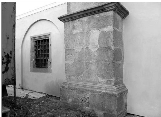
Obr. 15: Bečov nad Teplou, hrad, tzv. Pluhovské domy, nádvorní průčelí, opěrný pilíř bývalého jihovýchodního nároží, vlevo dodatečná zazdíčka klasicistní arkády s vloženým raně renesančním ostěním.
