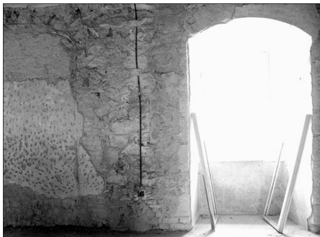
Obr. 29: Bečov nad Teplou, hrad, tzv. Pluhovské domy, první patro 1-2, východní stěna, vlevo nika pozdně gotického okna, přestavěná renesančně a v další renesanční fázi zazděná, vpravo klasicistní okenní nika, ve špaletách druhotně užitě kvádry.
