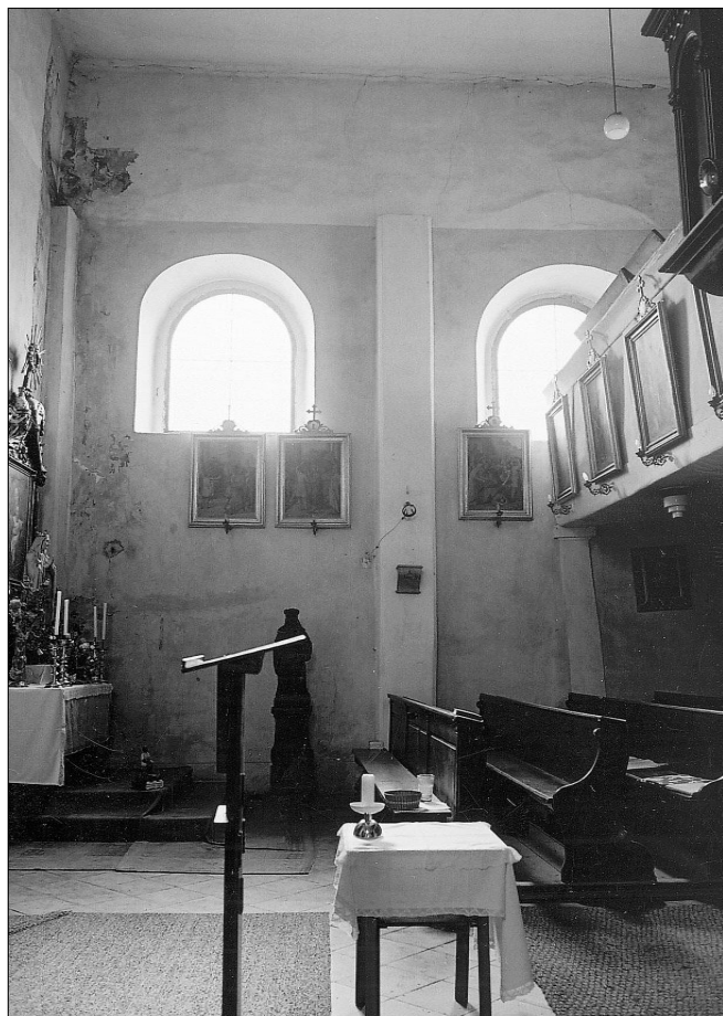
Obr. 6: Záboreč nad Labem, kostel sv. Prokopa, interiér lodi – pohled na východní stěnu. Při stěně mezi okny a v koutě přizděné polopíliře, nad kterými se rýsují obloučky po čelech klenby. Vpravo kruchta z roku 1835 (foto J. Žižka).
