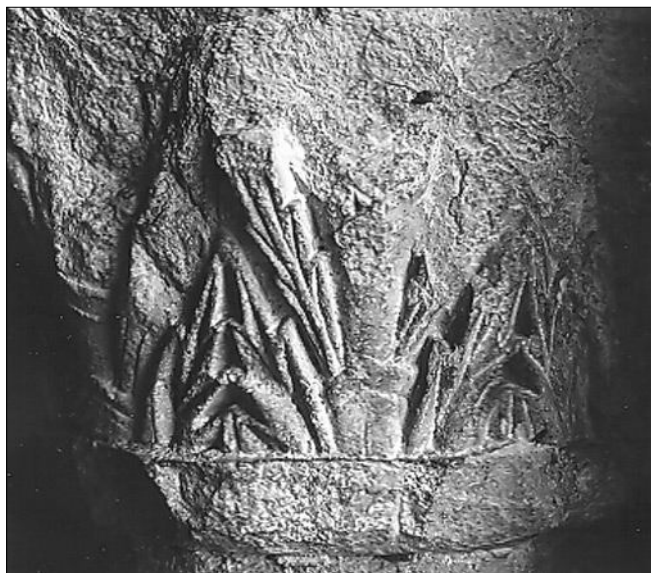
Obr. 8: Záboří nad Labem, kostel sv. Prokopa. Hlavice polosloupů v západní arkádě. Hlavice je značně poškozená. Přesto je zřejmé, že její tvarování je prakticky protikladem předchozí hlavice, neboť s jejími vláčnými liniemi kontrastuje ostře geometrickými trojúhelníkovitými formami lístků. Souhrnně lze říci, že obě zachované hlavice polosloupů se od hlavice sloupů svým výtvarným pojetím výrazně odlišují.
