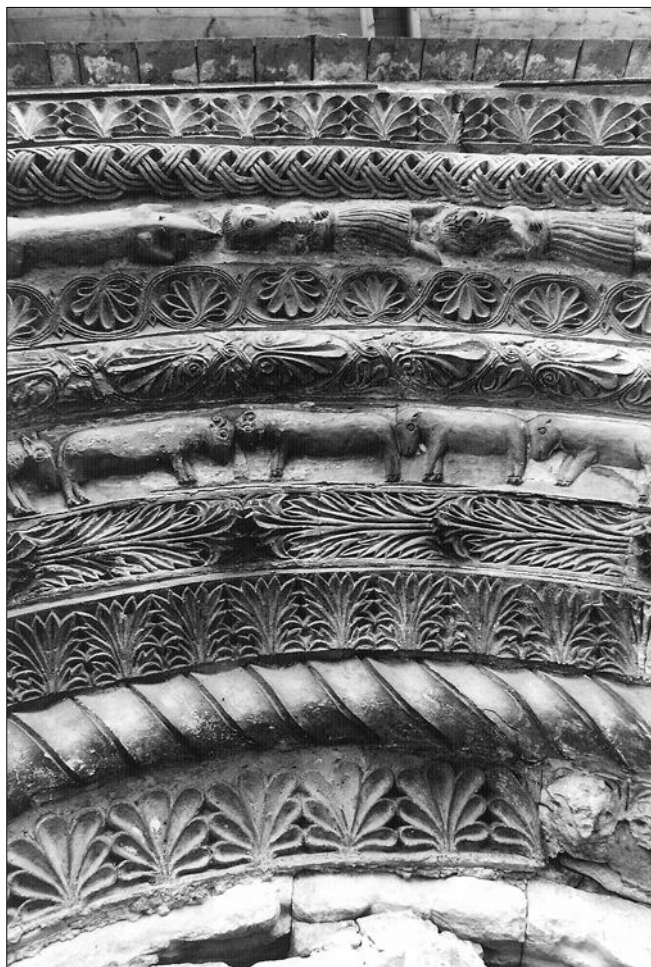
Obr. 6: Záboří nad Labem, kostel sv. Prokopa. Reliéfní výzdoba portálu před zahájením restaurace. Některé části výzdoby byly při předchozích opravách zcela nově provedeny. Z malty z cementu zejména vnitřní pás palmet (kde byly původně výrazně plastické akanty, jejichž fragmenty jsou patrné upravo), sousedící tordovaný kanelovaný prut (který je volně provedenou napodobeninou zakrytých zbytků původního prutu) a oba vnější pásy s palmetami a pletencem. Na ostatní části archivolt byl v průběhu restaurování zjištěn většinou vynikající stav zachování reliéfní výzdoby. Z konstrukčního hlediska stojí za pozornost, že segmenty prutů se většinou jen minimálně na hranách překrývají, nebo k sobě přiléhají pouze hranami. Rozhodně nelze mluvit o tom, že by se jednalo o jinak běžnou konstrukci navzájem se přečnělkově podporujících oblouků. Poněkud zjednodušeně lze říci, že se jedná spíše o obklad, i když z ostatních souvislostí plyne, že archivoltly byly skládány na ramená a na jejich horní plochu byly položeny další záklenky z pískovcových kvádrů. Tyto vylehčující oblouky byly na horní straně pokryty omázkou.
