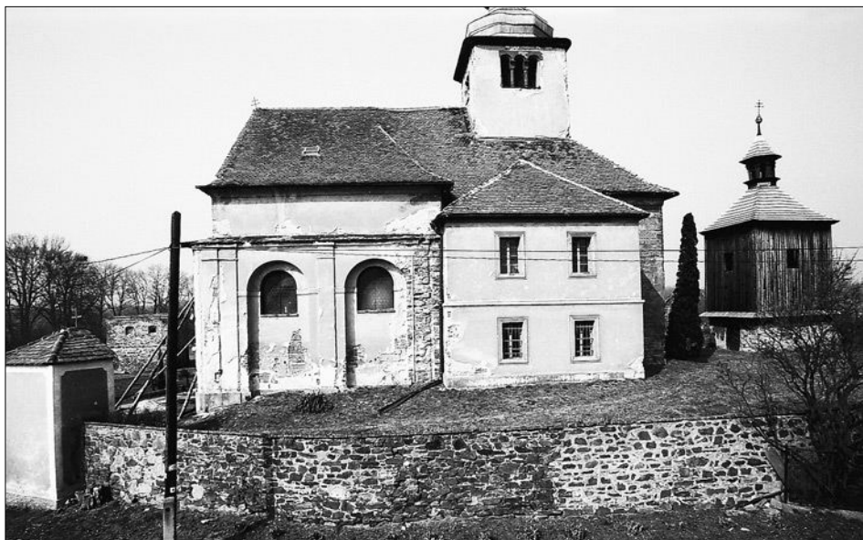
Obr. 1: Zábore nad Labem, kostel sv. Prokopa, pohled od východu: vpravo loď s patrem, dodatečně sníženým. Sakristie s oratoří v patře na místě apsidy postavena 1850–1851 (v té době však již z apsidy stály jen drobné úseky zdiva po stranách někdejšího vítězného oblouku) – ve zdivu sakristie jsou zjišťovány kvádry s vypouklými či prohmtnutými plochami, pocházející zjevně z líc pláště zdiva apsidy. Vlevo přiléhá dodatečně připojená románská předsíní, původně na východní straně otevřená trojdielnou arkádou. Tato subtilní architektura byla později částečně destruována – zejména se zřítlo nebo bylo sneseno jihovýchodní volné nároží. Následně byla zvýšena v souvislosti s vložením klenutého dvoulodí, k čemuž mohlo dojít snad v 16. století nebo kolem poloviny 17. století. Souvislost vnějších lichých arkád s předsíní nasvědčuje tomu, že vznikly ještě před zvýšením obvodového zdiva předsíně – jinak by totiž nebylo jasné, proč nadezdívka přesně lícuje se spodním starším zdivem. Chronologii úprav předsíně ještě bude třeba věnovat pozornost (všechny snímky autor).
