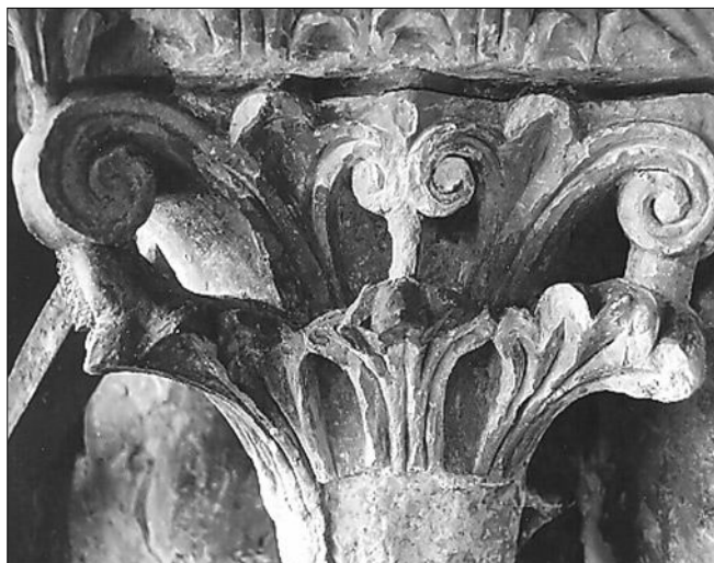
Obr. 3: Zábork nad Labem, kostel sv. Prokopa. Hlavice z levé strany ostění portálu. Nad dvěma řadami akantů (spodní řada je téměř zcela zničená – jen vpravo je patrný úsek jen hrubě opracovaného listu, obráceného do koutu ústupku ostění) jsou stonky stočené do volut. Levá voluta byla později odlomena a domodelována z tmelu, přičemž došlo k mírnému zalomení křivky.
