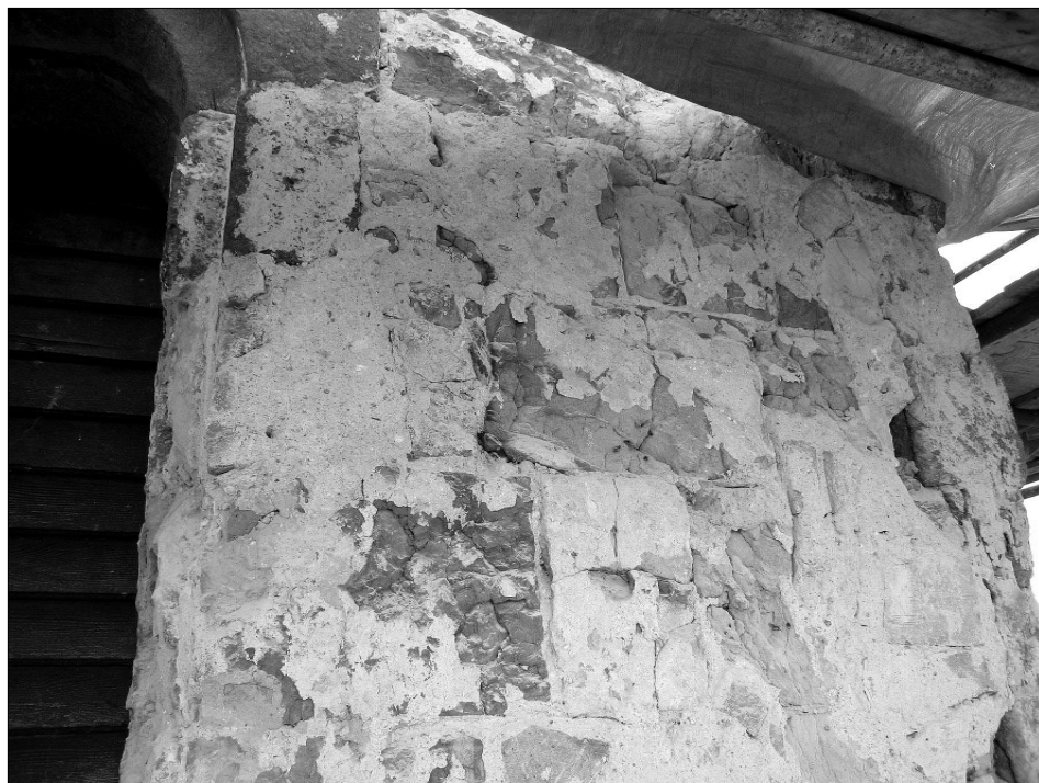
Obr. 12: Záboří nad Labem, kostel sv. Prokopa, kvádrové zdivo upravo od sdruženého okna na východní straně věže.
