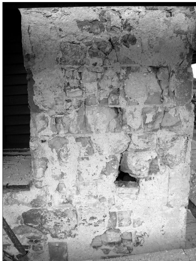
Obr. 14: Záboří nad Labem, kostel sv. Prokopa, zdivo upravo od sdruženého okna na jižní straně věže, dole je patrný fragment původního základu okna.
