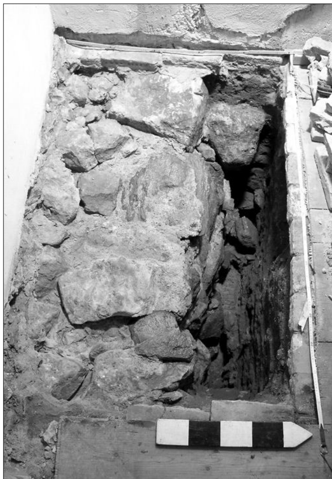
Obr. 5: Záhoří nad Labem, kostel sv. Prokopa, pohled na odkrytý základ čelní zdi předsíně v sondě č. II/04.
