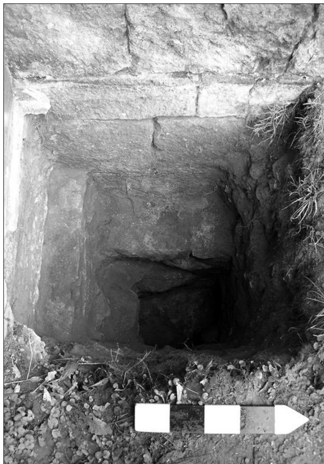
Obr. 6: Záboří nad Labem, kostel sv. Prokopa, pohled na románské kvádríkové zdivo v základu původního kostela a na mladší základ barokní sakristie v sondě č. IV /04.
