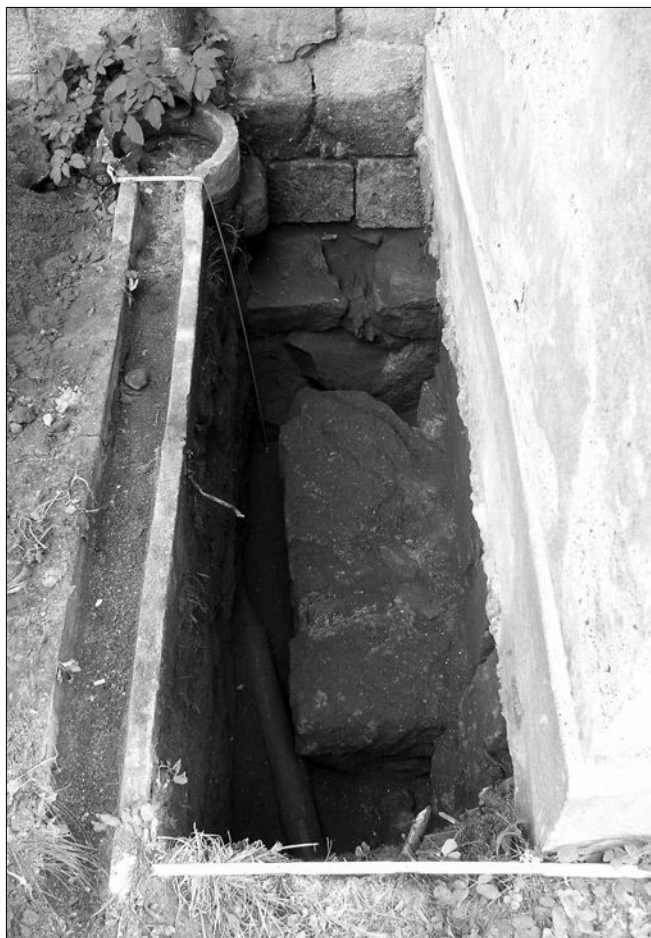
Obr. 7: Záboří nad Labem, kostel sv. Prokopa, pohled na napojení základu předsině v sondě č. V/04.
